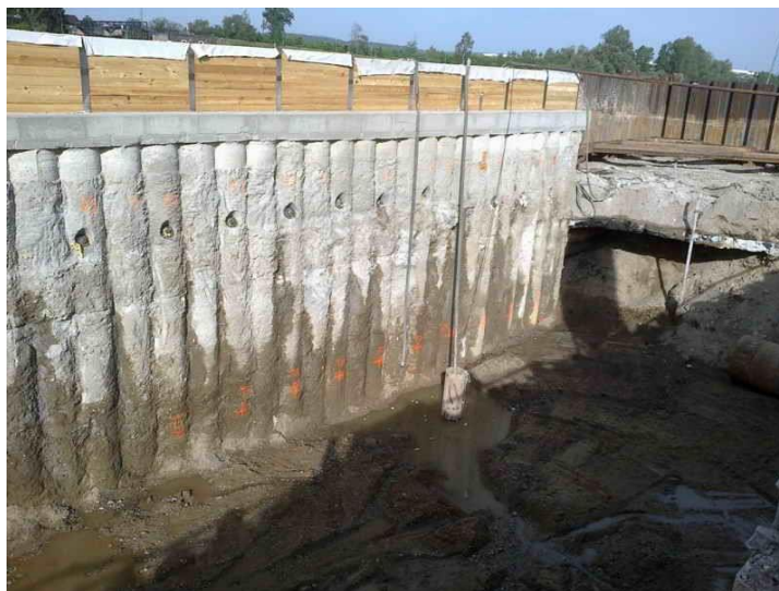
Obr. 17: Pilotová stěna tangenciální [46]
