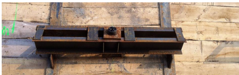
Obr. 8: Převázka tvořená dvojicí U profilů přivařených k sobě ocelovými pásky [30]
