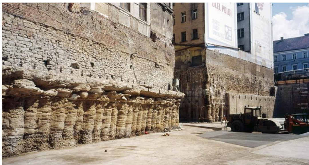
Obr. 24: Objekt podchycen pomocí sloupů tryskové injektáže [34]
