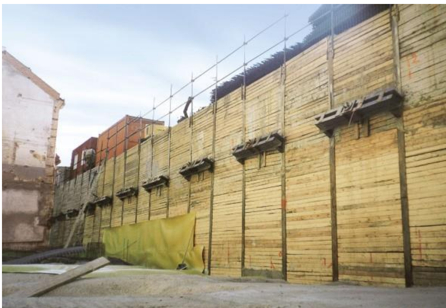
Obr. 4: Pažená stavební jáma pomocí technologie záporové pažení [42]
