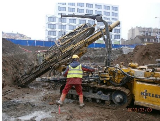
Obr. 29: Vrtání zemních kotev [61]
