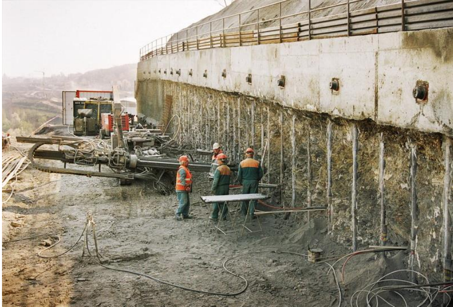
Obr. 14: Mikrozáporvá stěna [37]
