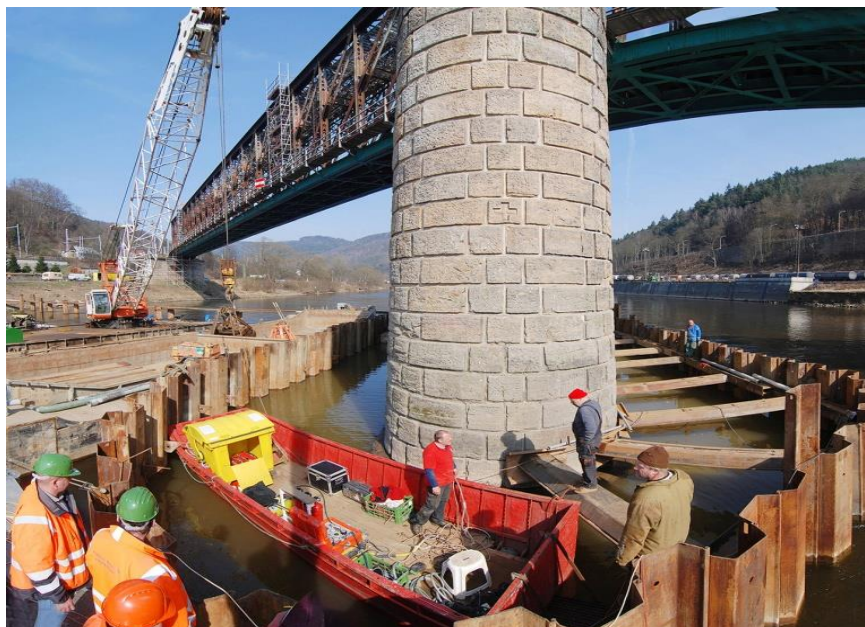
Obr. 2: Jímka v řece ze štětovnic obestavěná kolem mostního pilíře [60]
