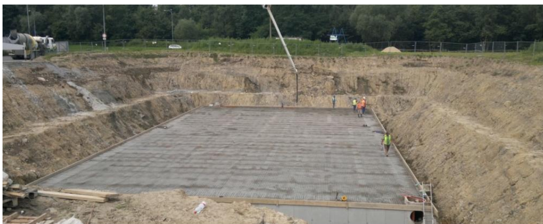
Obr. 1: Pohled do odstupňované svahované jámy [26]
