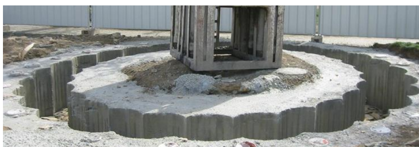
Obr. 19: Vodící zídka (šablona) pro převrtávané piloty [35]
