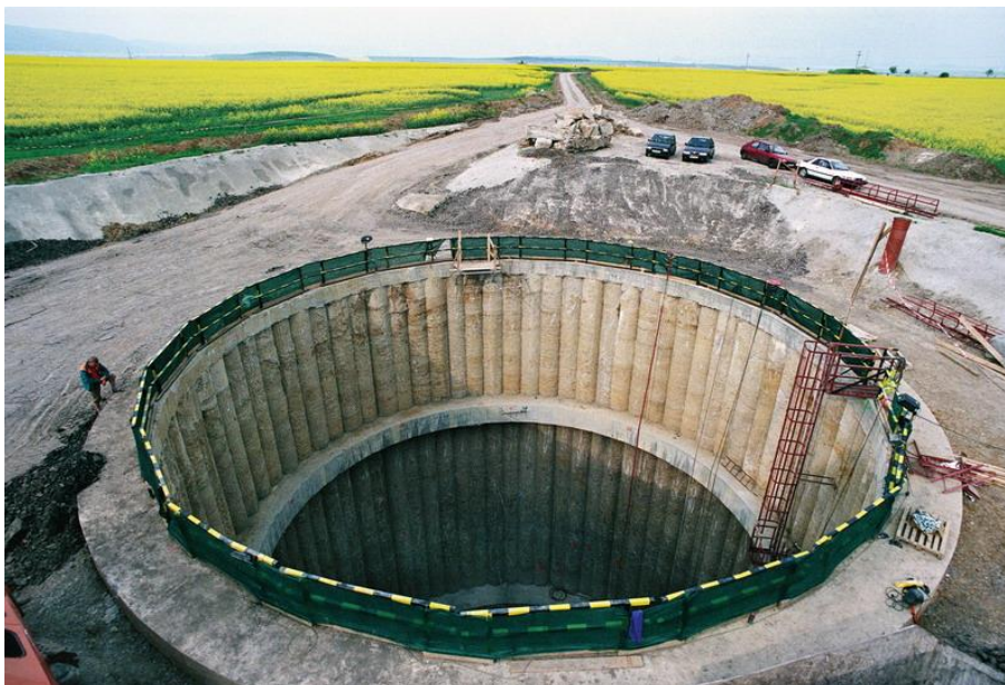
Obr. 20: Převrtávaná pilotová stěna kruhového půdorysu [47]
