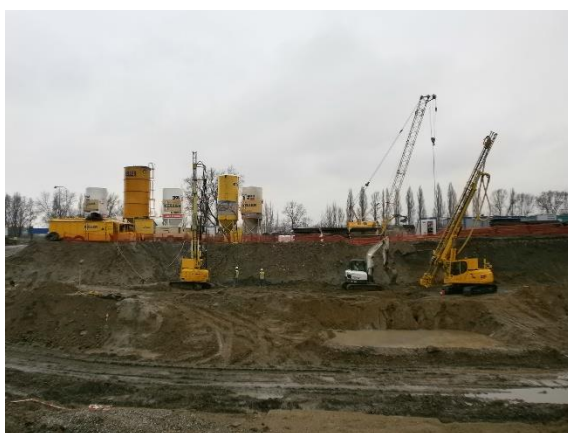
Obr. 28: Provádění tryskové injektáže [61]
