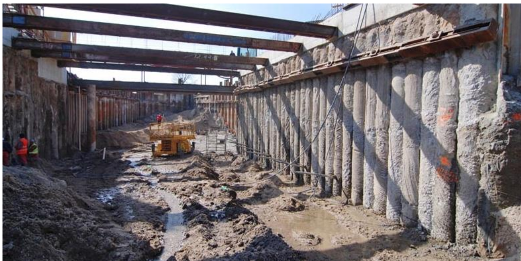
Obr. 3: Těsněná stavební jáma v místě s vysokou hladinou podzemní vody [27]
