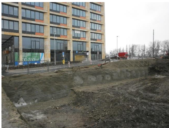
Obr. 27: Hřebíkový svah s kari sítí a zastříkaný betonem [61]
