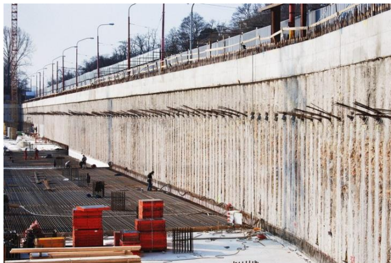
Obr. 18: Převrtávaná pilotová stěna [45]
