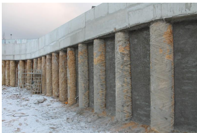
Obr. 16: Pilotová stěna s velkou osovou vzdáleností [44]
