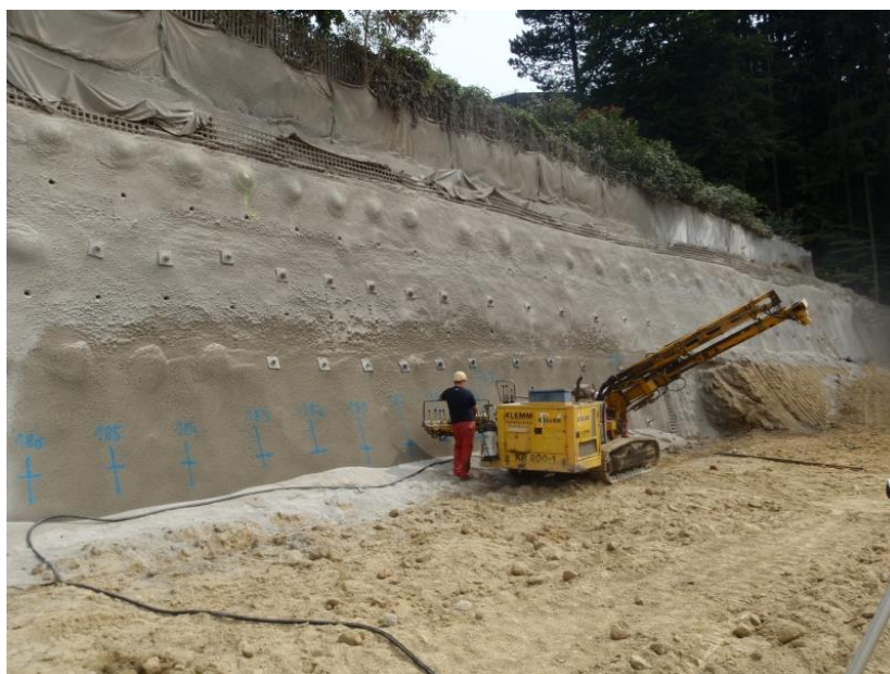
Obr. 5: Svah zajištěný hřebíkováním [41]
