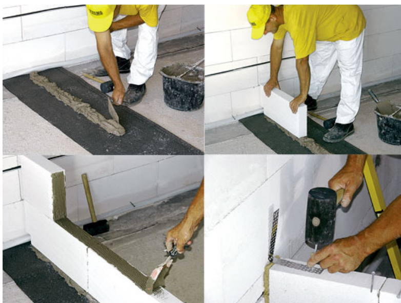
Obrázek 12: Porobetonové příčky (24)
