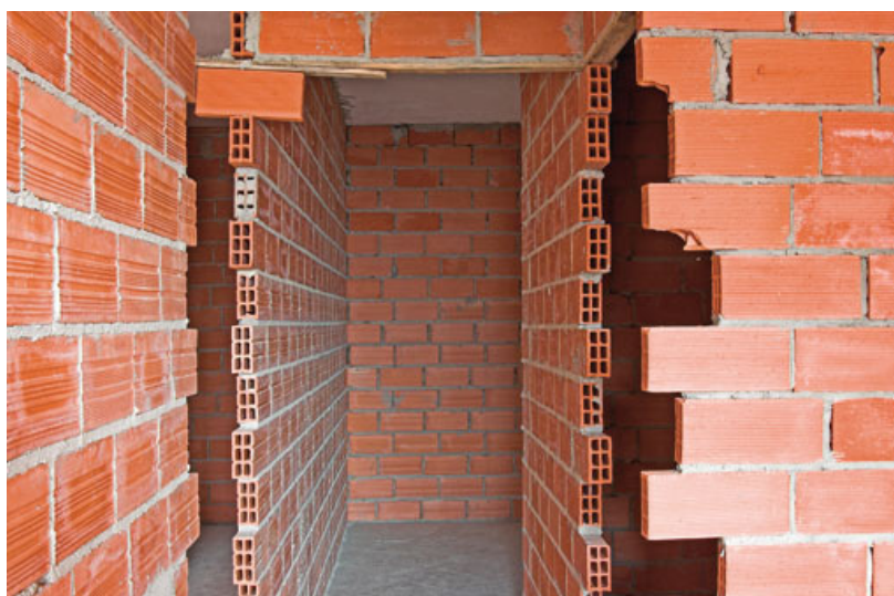
Obrázek 13: Keramické příčkovky (24)
