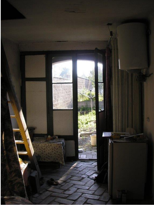
příprava teplé vody v elektrickém boileru
