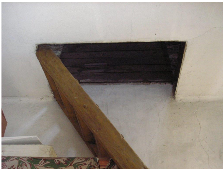
schody na půdu
