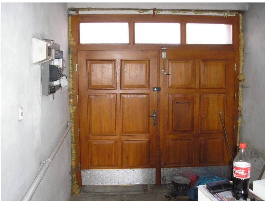
vstupní dveře vyměněny elektroinstalace - jističe
