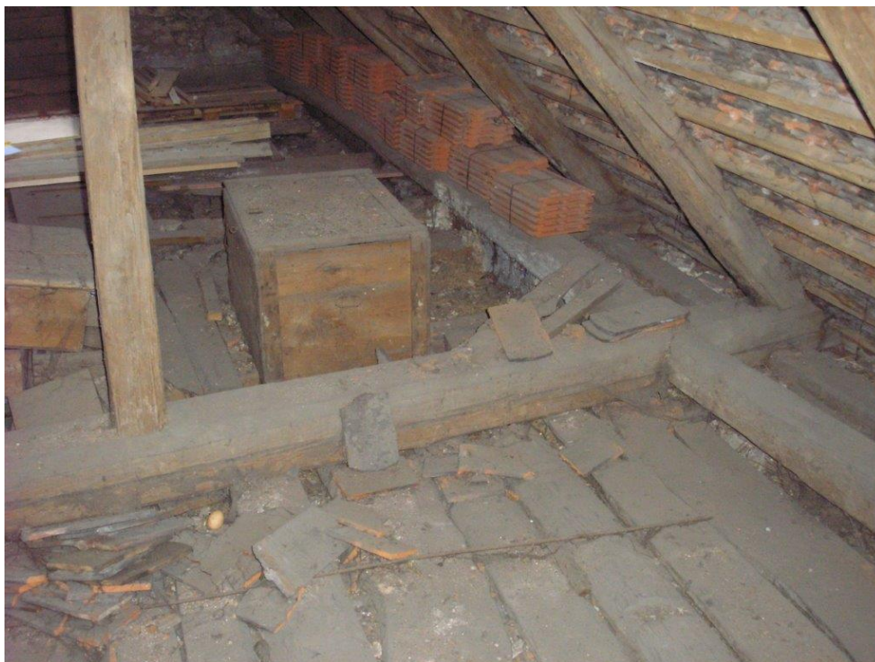
Obrázek 34: Napadení záklopu červotočem
