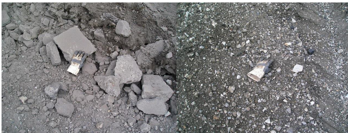
Obrázek 6: Rozrytý povrch před předrcením a po předrcení
