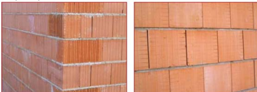
Obrázek 15: Převazba cihelných bloků POROTHERM
