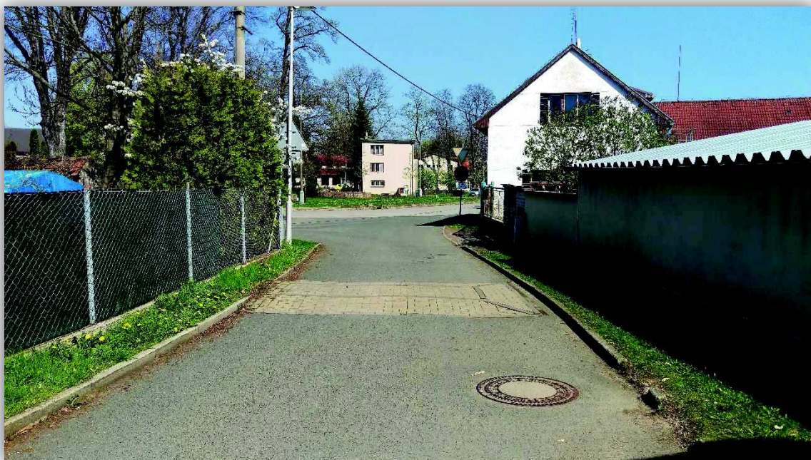
Obrázek 18 – Přejezdový práh v obytné zóně v ulici Skalická
