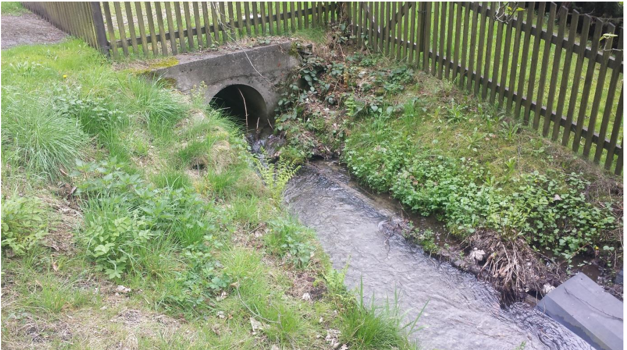
Zatrubnění přívodního kanálu u obytných objektů
