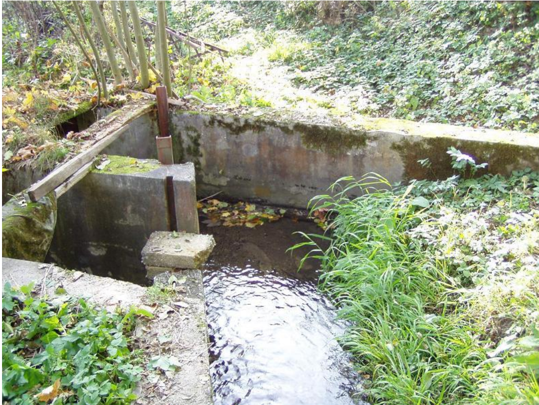
Vtokové těleso do MVE
