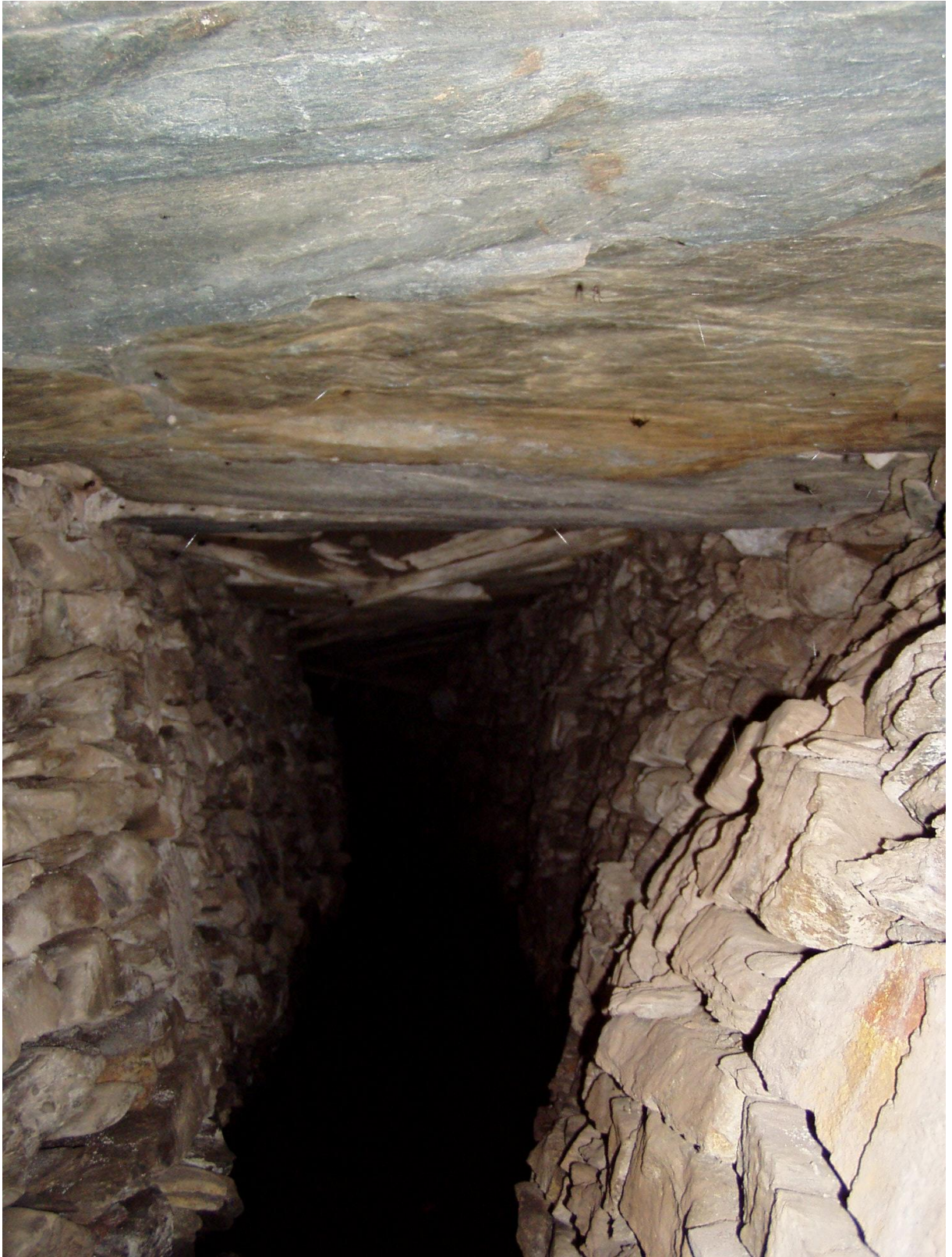
Strop odtokového kanálu
