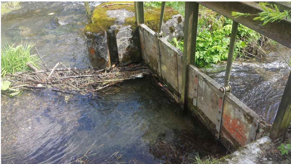
Stavidla vtokového kanálu
