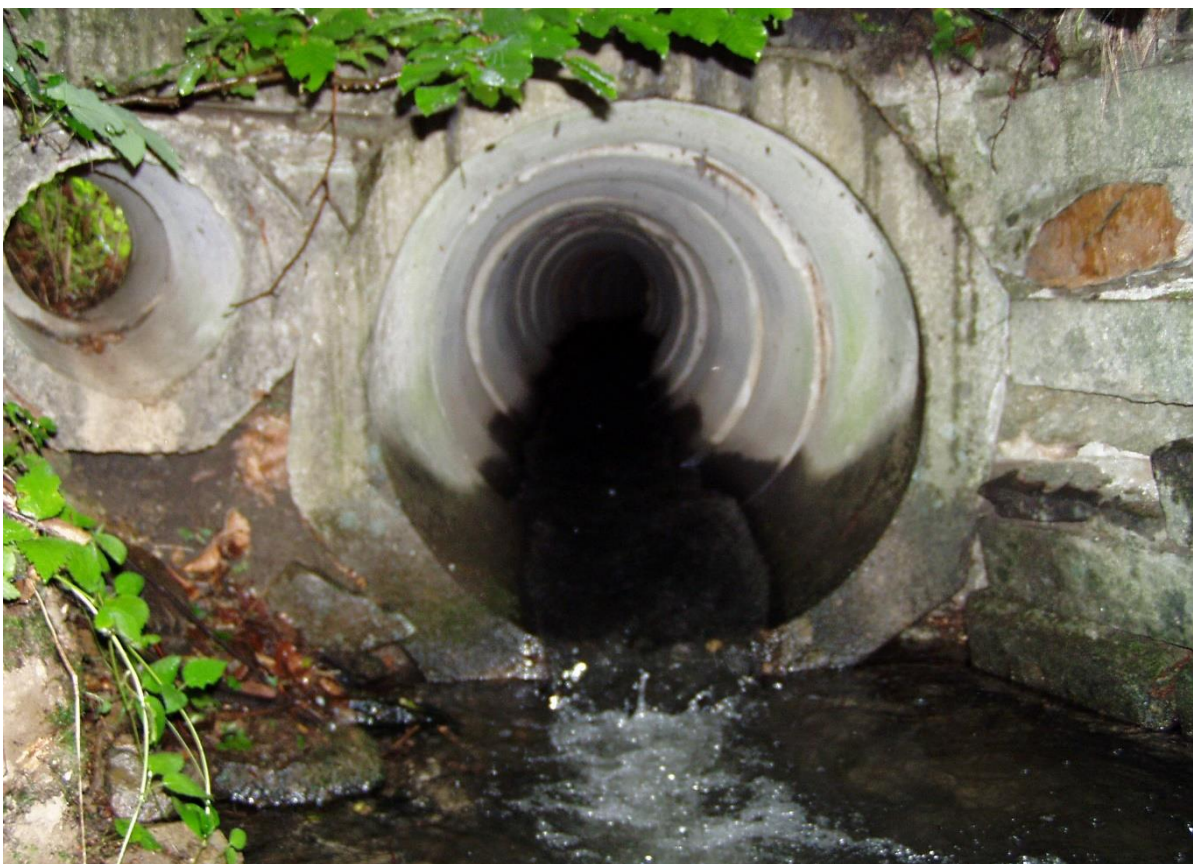
Propustek pod silnicí
