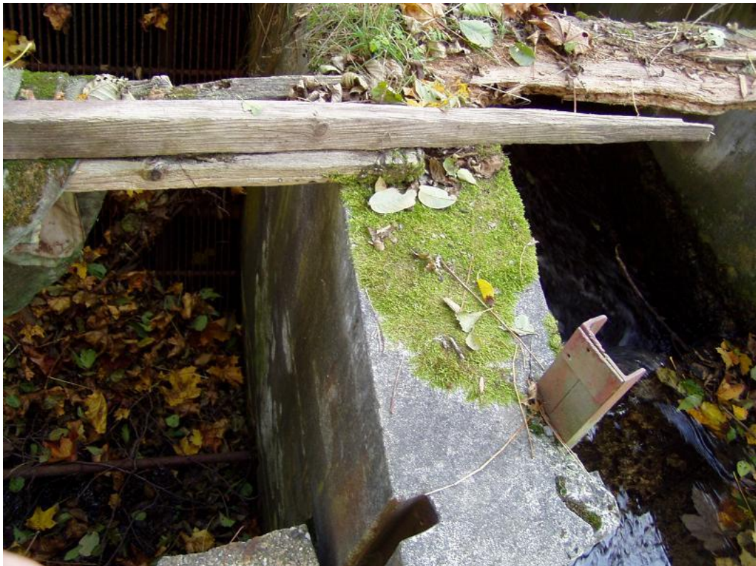
Vtokové těleso do MVE, pohled shora
