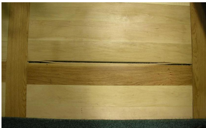
Obr. 23: Důsledek extrémních objemových změn dřevěné podlahy (sesychání) [36]
