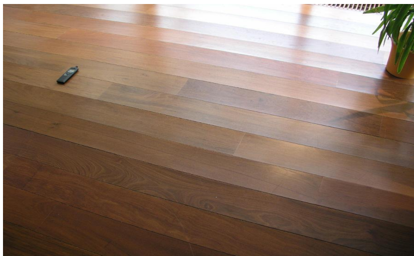
Obr. 24: Důsledek extrémních objemových změn dřevěné podlahy (příčné prohnutí dílců) [36]
