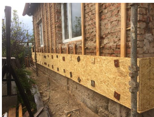
Obr. 6: Bednění první řady (z vlastních zdrojů)
