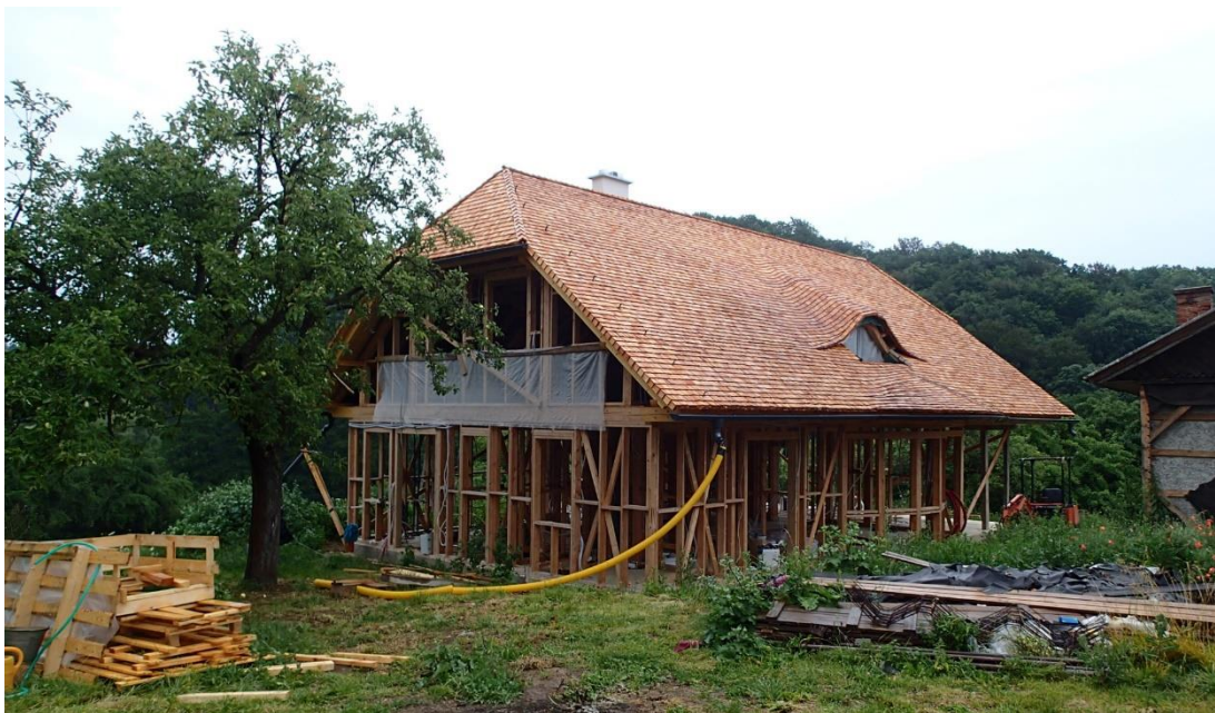
Obr. 10: Stavba připravena pro betonování příček (foto od p. Majringera z www.konopny-beton.cz )
