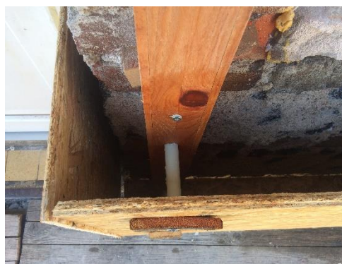
Obr. 7: Detail použití distančníků (z vlastních zdrojů)
