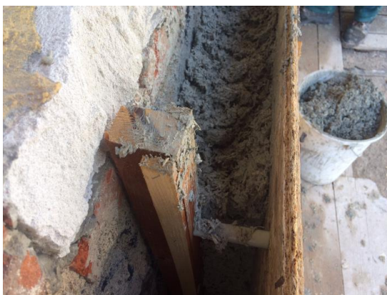
Obr. 8: Ukázka čerstvě vybetonovaného konopného betonu v bednění (z vlastních zdrojů)
