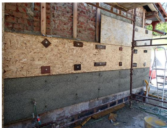
Obr. 9: Ukázka procesu betonáže při třetím dnu betonování (z vlastních zdrojů)
