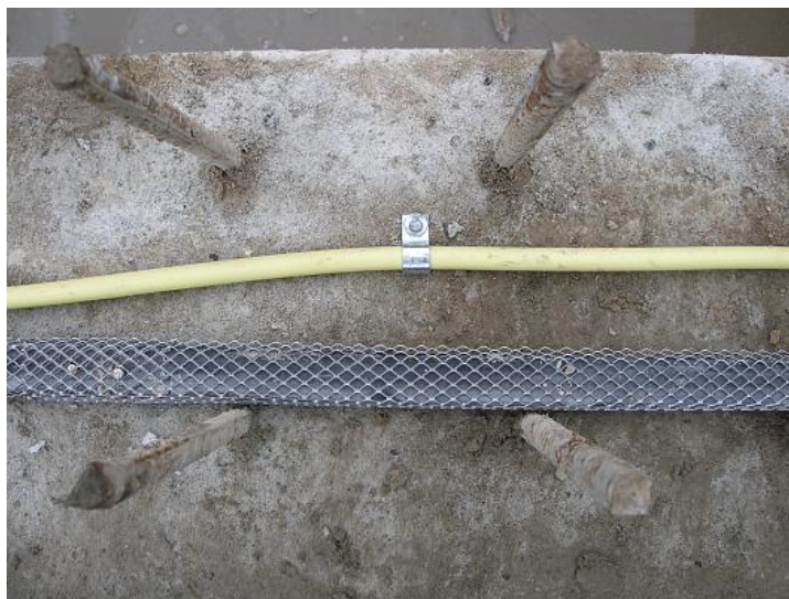
Obr. 11 – Bentonitové bobtnající těsnění (převzato z [5])
