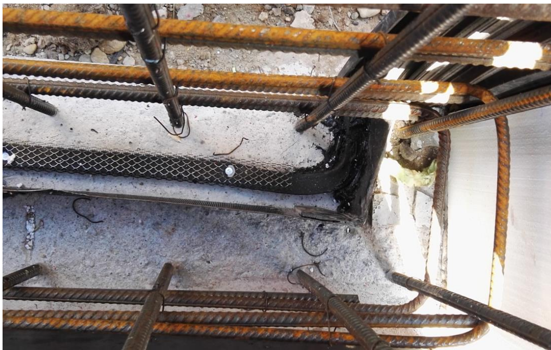
Obr. 39 – Spojování těsnění (foto autor)
