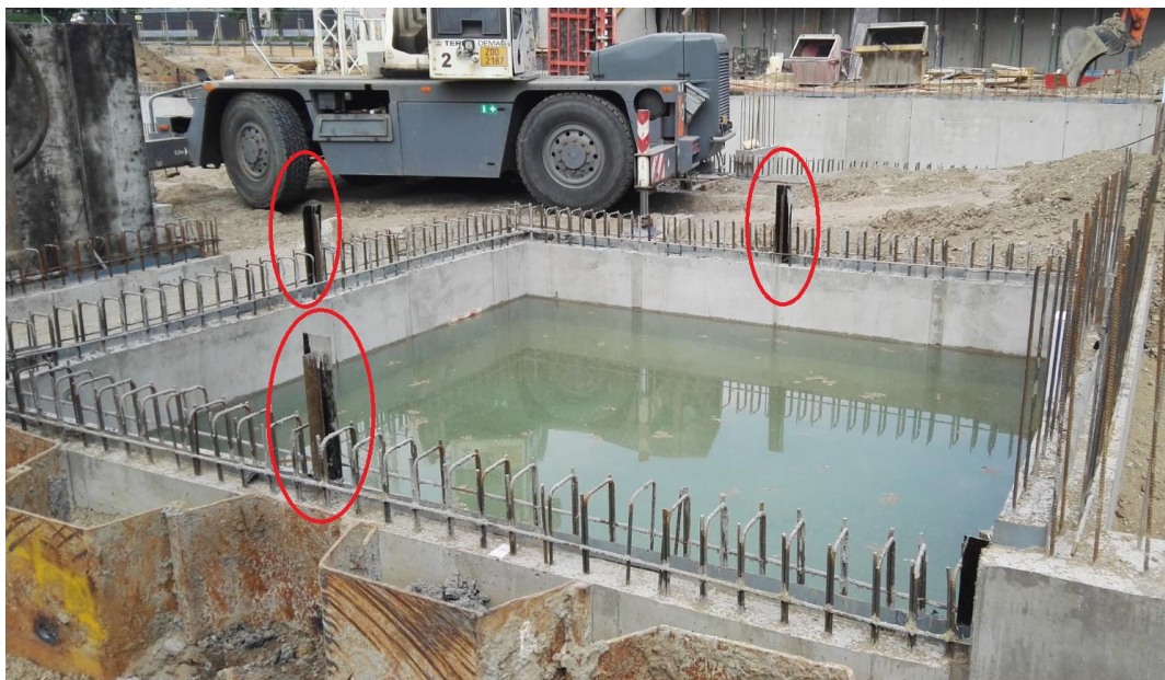
Obr. 37 – ASS řízené spáry v zaplavené zakladačové šachtě (foto autor)
