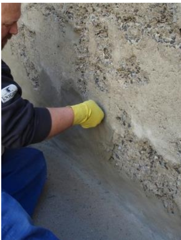
Obr. 15 – Sanace kaveren pomocí krystalizační ucpávky (převzato z [9])
