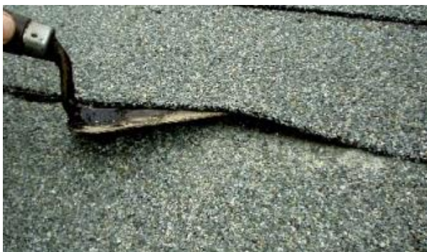
Obr. 3 – Kontrola spojů izolačskou špachtlí (převzato od Dekprojekt, s.r.o.)
