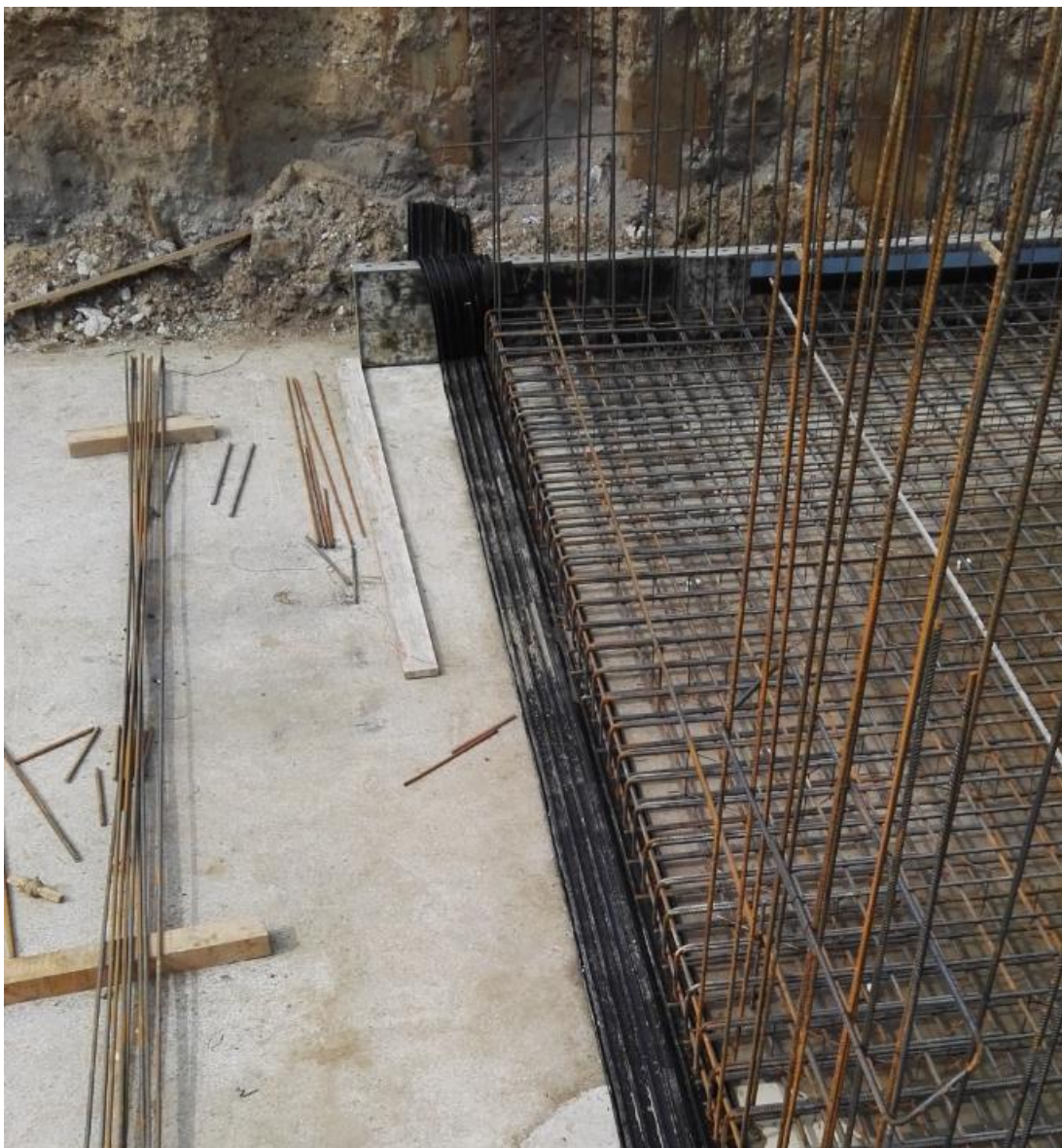
Obr. 32 – Pohled na těsnění dilatační spáry (foto autor)
