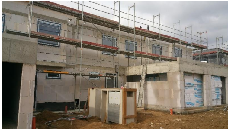
Obr. 37 Dokončování fasádního lešení
