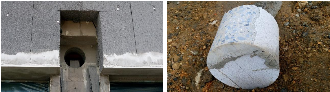
Obr. 107 Přesně vytvořený prostup a vyřezaný prvek
