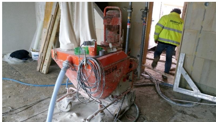
Obr. 34 Strojní omítačka v provozu
