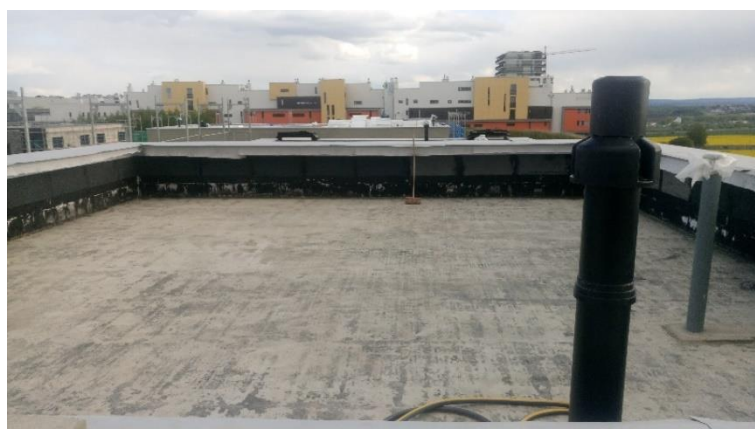
Obr. 97 Pohled na střechu po dvou měsících (M1040A)
