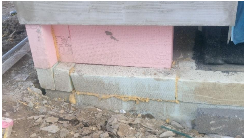
Obr. 74 Neochráněný polystyren po třech měsících (M1040A)
