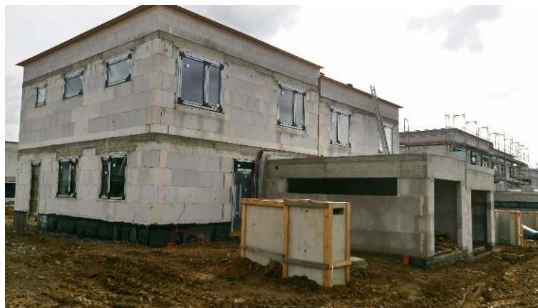
Obr. 41 Pozastavené práce na dvojdomu č. 63-64
