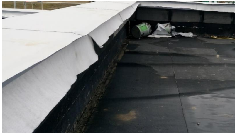
Obr. 95 Detail izolace u atiky I (M1040A)
