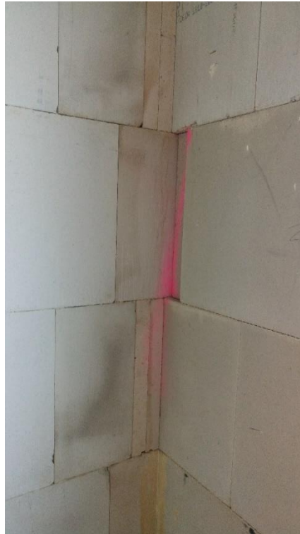
Obr. 109 Chybná skladba tvárnic (M1040A)
