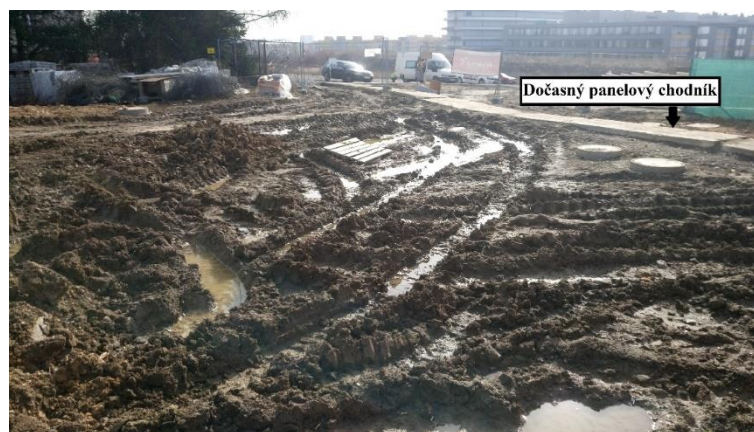
Obr. 54 Neupravený prostor u hlavního vstupu
