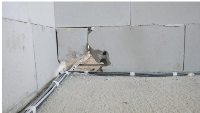
Obr. 105 Amatéřsky vytvořený průstup v příčce (M1040A)
