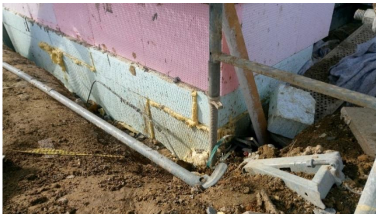
Obr. 70 Detail soklového rohu I (M1040A)
