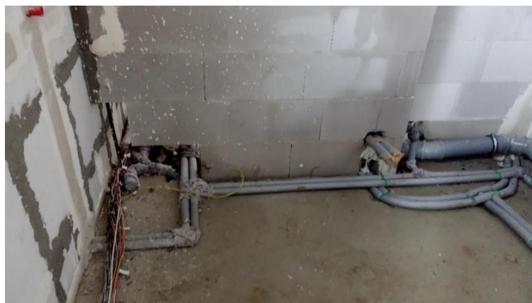
Obr. 103 Vodovodní a kanalizační rozvody (M1040A)
