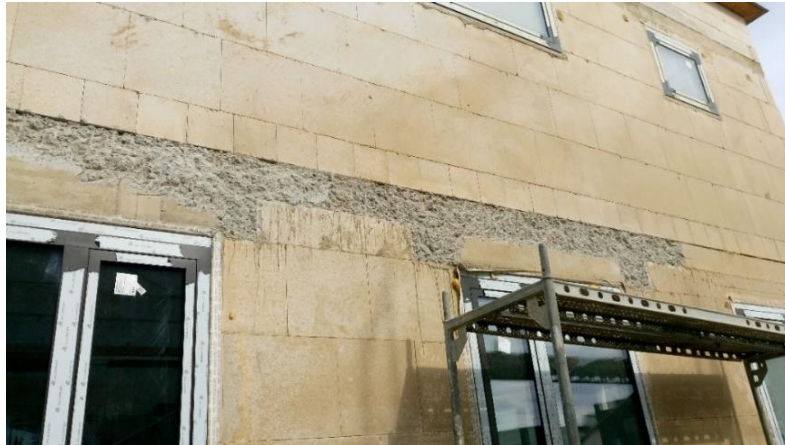
Obr. 80 Vysekaná vyboulená část stropní desky (M820)
