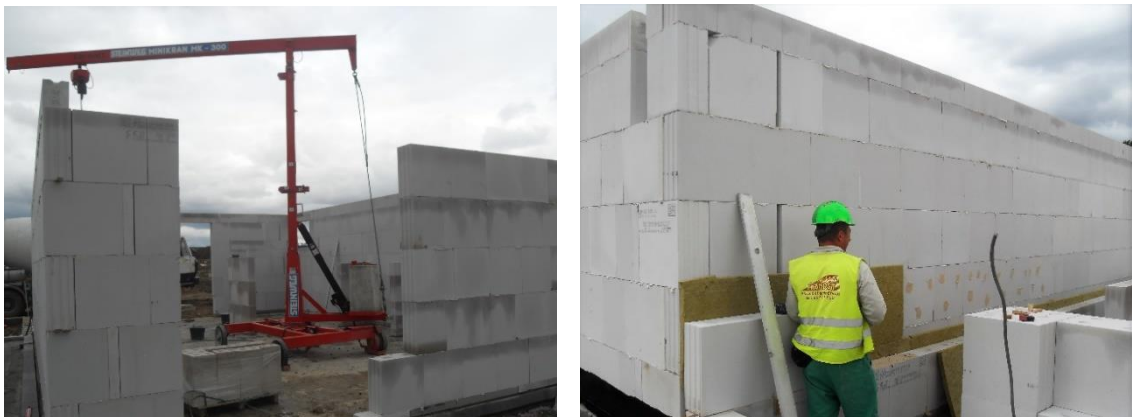
Obr. 31 Zdění a provádění dilatace
