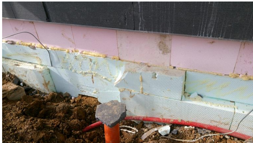
Obr. 72 Pohled na sokl provedený z různých materiálů (M1040A)
