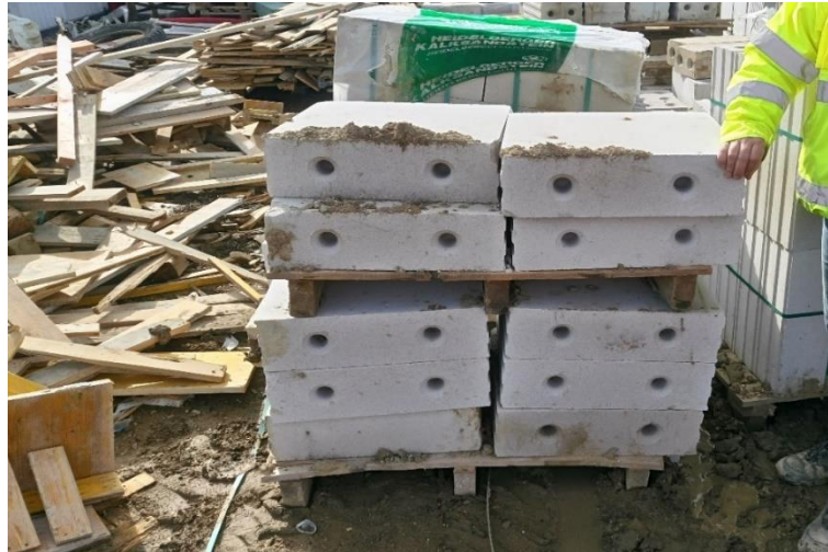
Obr. 56 Příklad uložení tvárnic
