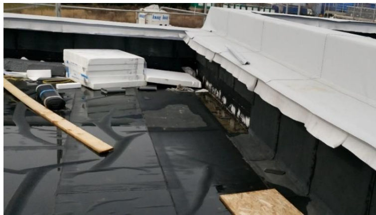
Obr. 96 Detail izolace u atiky II (M1040A)
