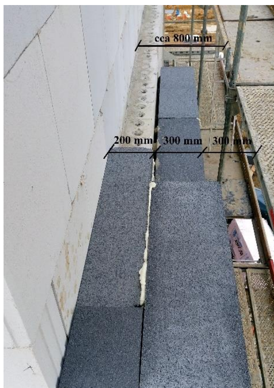
Obr. 64 Nezajištěné lešení na volném okraji
