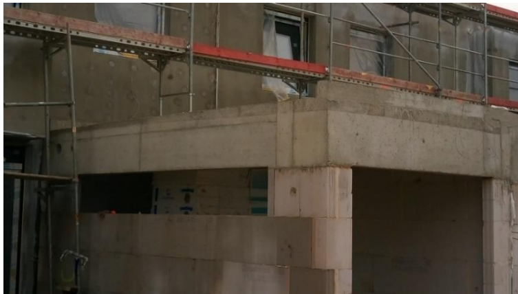
Obr. 92 Správně provedená monolitická deska
