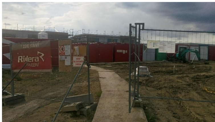
Obr. 26 Hlavní vstup na stavbu
