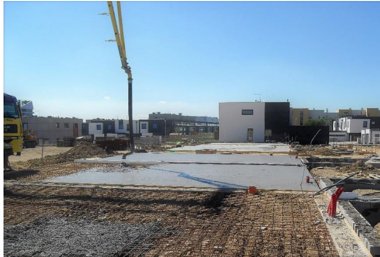
Obr. 30 Betonáž základových desek
