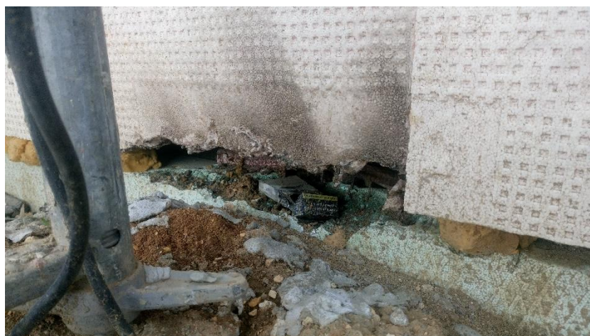
Obr. 75 Ohořelá část soklu (M820)
