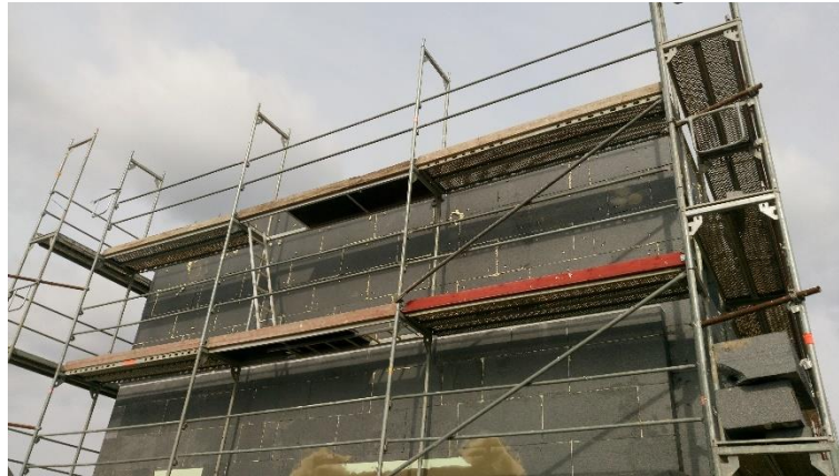
Obr. 49 Kotvení izolantu
