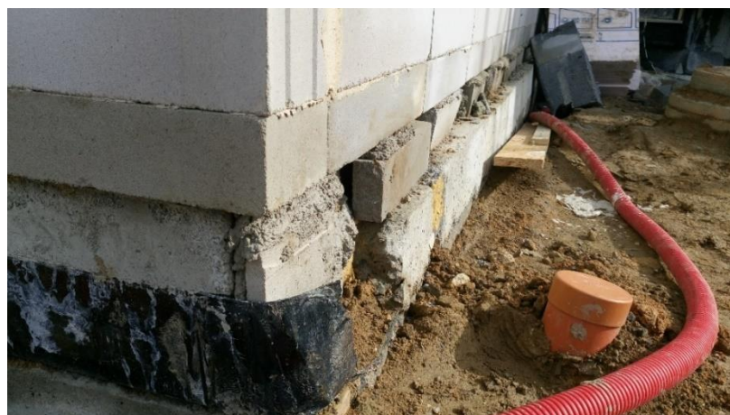
Obr. 86 Detail posunuté desky garáže II
