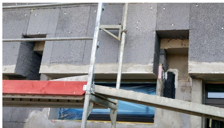
Obr. 48 Vyřezaná část izolantu pro prostup
