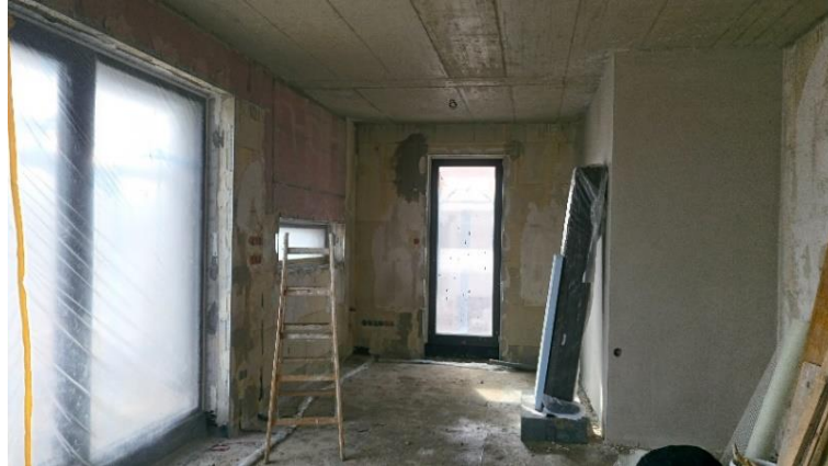
Obr. 35 Místnost připravena na omítání
