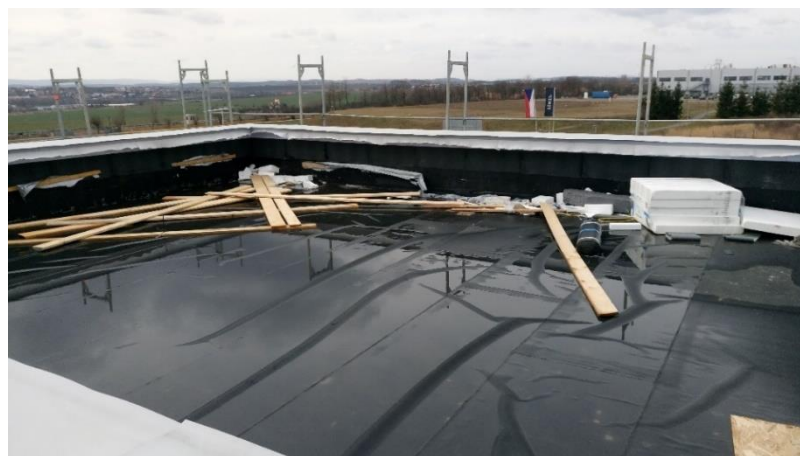
Obr. 94 Pohled na střechu domu č.59 (M1040A)
