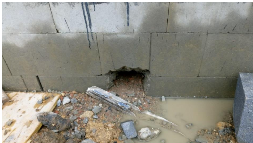
Obr. 77 Prostup základovou konstrukcí (M820)
