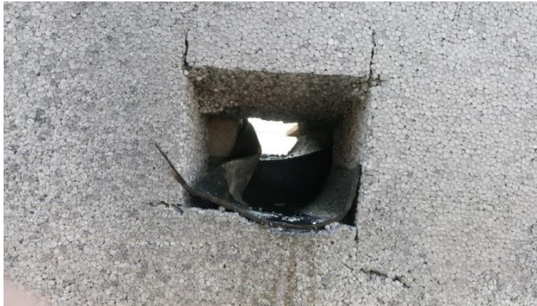
Obr. 100 Detail provizorní vpusti na vnější straně atiky (M700)
