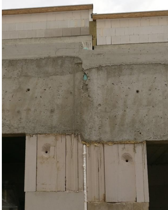
Obr. 87 Detail probetonované dilatace
