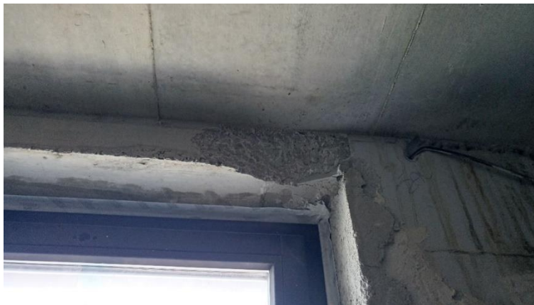
Obr. 121 Porušený monolitický překlad (M1040A)
