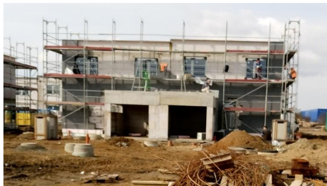
Obr. 44 Provádění KZS (domy č.45-46)
