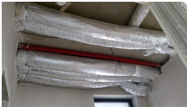
Obr. 21 Nainstalované hadice pro VZT (M1040A)
