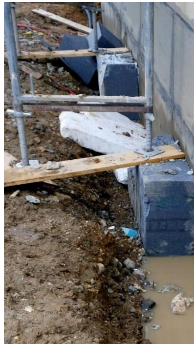
Obr. 65 Nepřijatelné založení paty lešení
