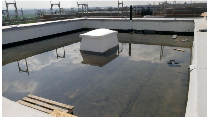
Obr. 98 Pohled na střechu domu č.39 (M700)
