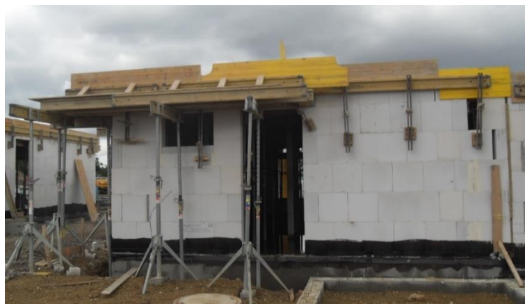
Obr. 81 Ukázka bednění monolitického věnce (M820)
