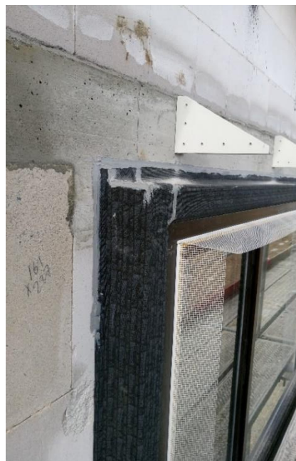
Obr. 15 Hotový smontovaný a utěsněný rám ILLBRUCK
