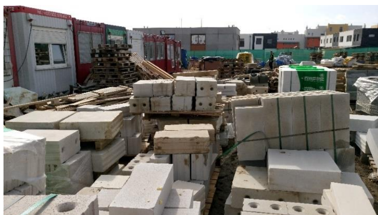
Obr. 27 Venkovní sklad zdicího materiálu
