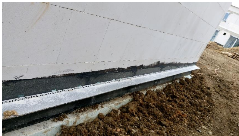
Obr. 83 Zabezpečená základová spára
