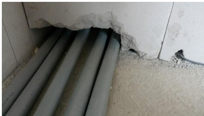
Obr. 106 Průstup v příčce (M820)
