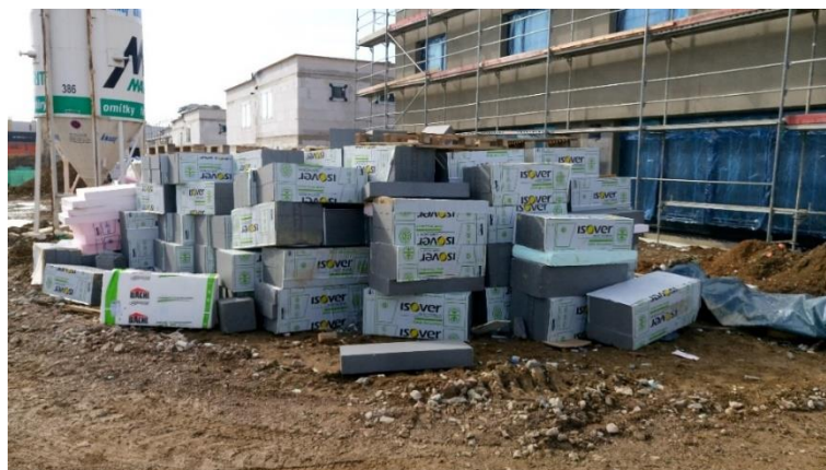
Obr. 60 Neodborně uskladněný tepelný izolant
