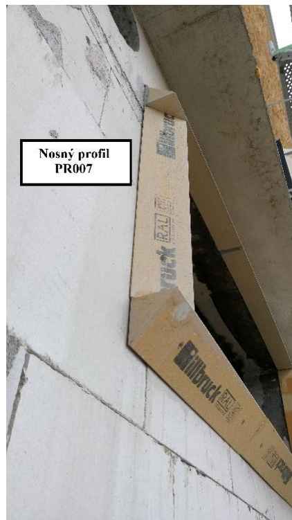
Obr. 14 Upevněné profily PR007 okolo otvoru
