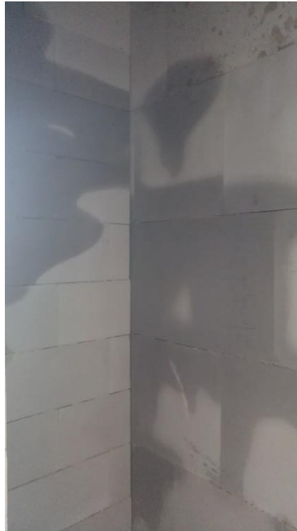
Obr. 115 Navlhlé zdi
