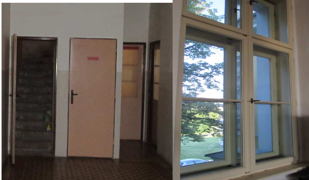
foto č. 8, 9: Okna a dveře v druhém nadzemním podlaží
