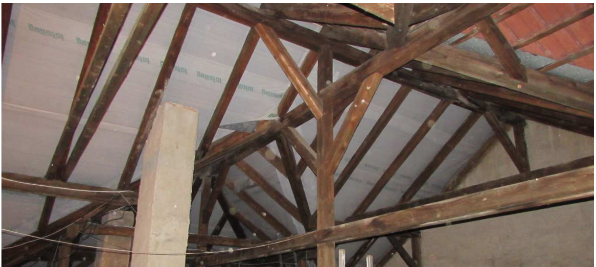
foto č. 7: Vazba krovu
