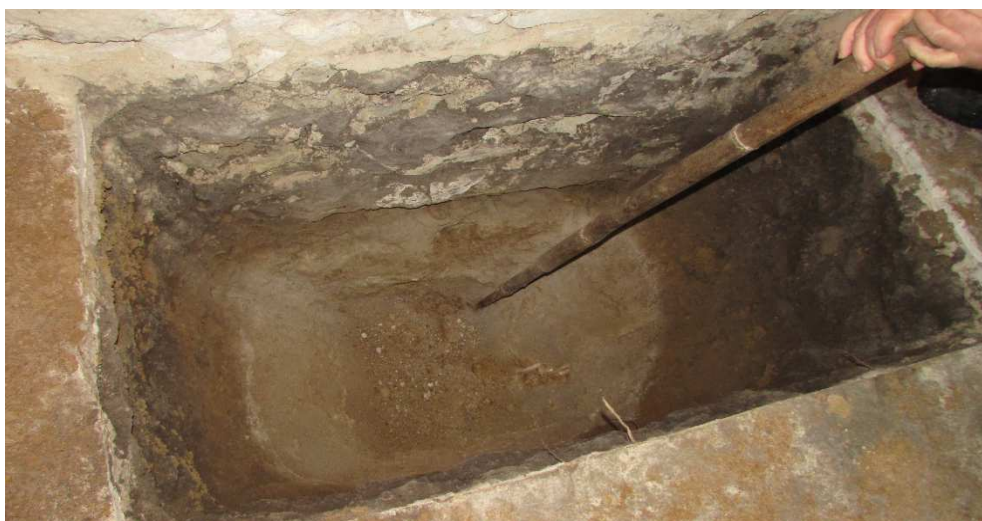
foto č.1: Hloubka základové spáry zastižena v hloubce 0,6m pod podlahou
