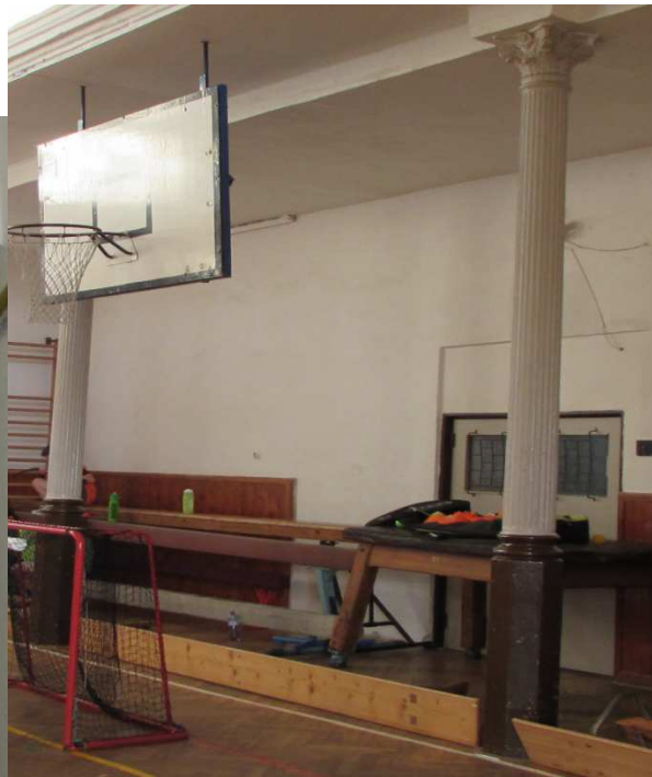
foto č. 5: Litinové podpory ochozu
