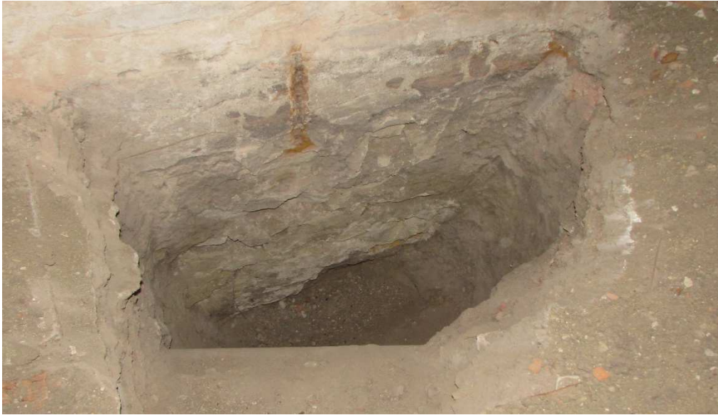
foto č. 2: Hloubka základové spáry zastižena v hloubce 1,3m pod podlahou
