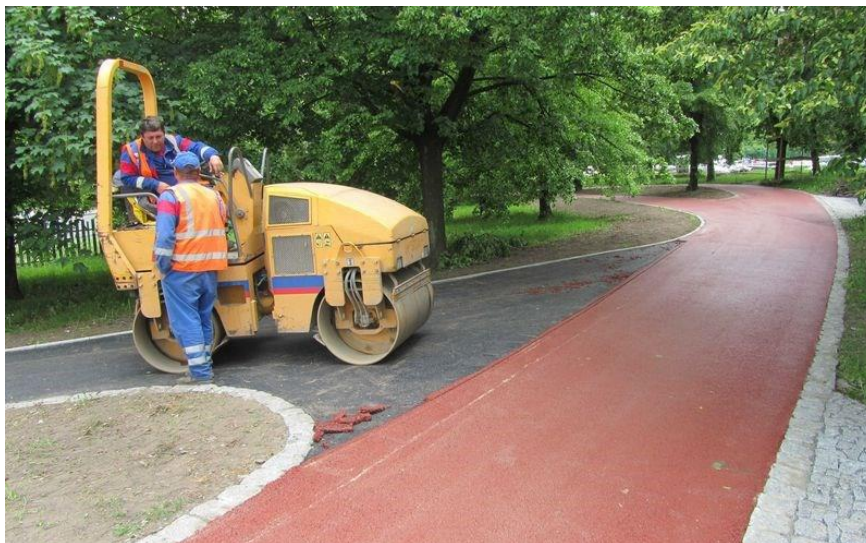
Obrázek č. 4 – Pokládka barevného koberce BBTM 8A+ [2]
