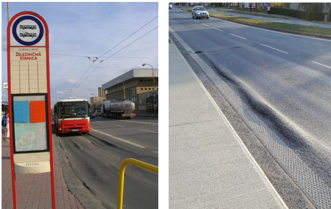
Obrázek č. 6 – vyjetá kolej na autobusové zastávce (vlevo) [9], vytlačení asfaltové směsi na okraj vozovky (vpravo) [10]
