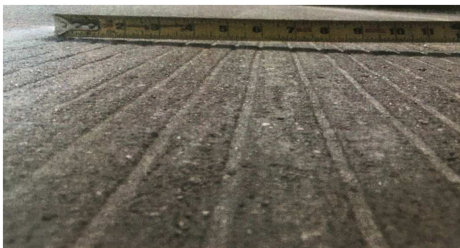
Obrázek 18: Úprava povrchu CB krytu diamantovými kotouči
