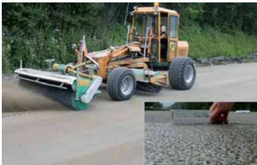
Obrázek 17: Úprava povrchu CB krytu vykartáčováním
