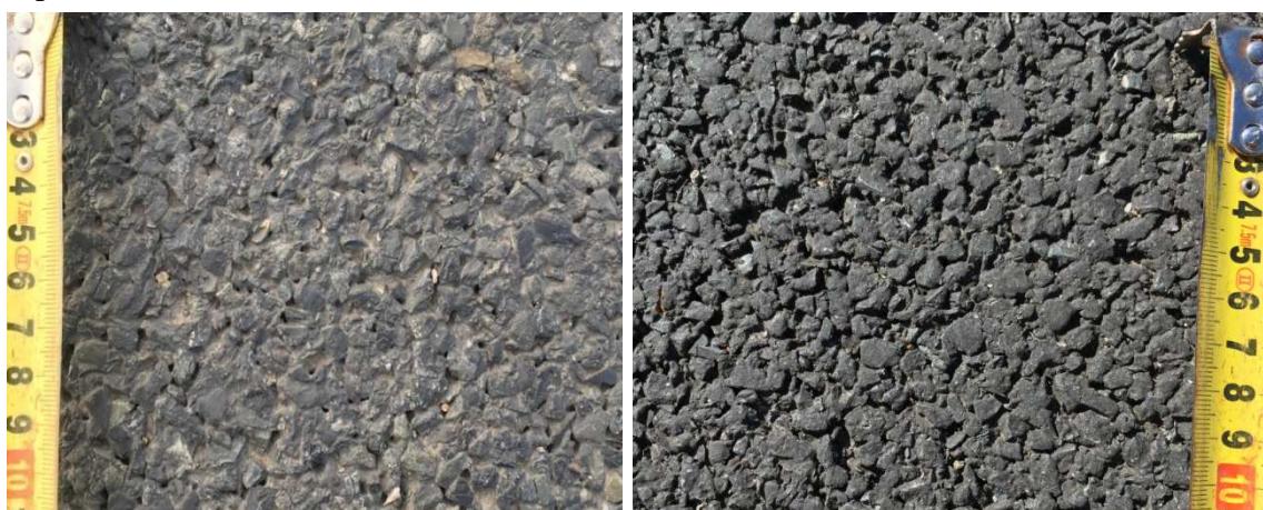
Obrázek 37: Detail obrusné asfaltové vrstvy SMA 8-NH (vlevo realizace 2011, vpravo realizace 2015)
