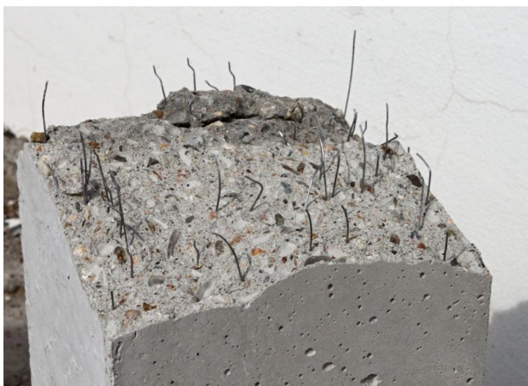
Obr. 16 Rozlomený trámek z drátkobetonu po zkoušce pevnosti v tahu za ohybu – převzato z webu www.ebeton.cz
