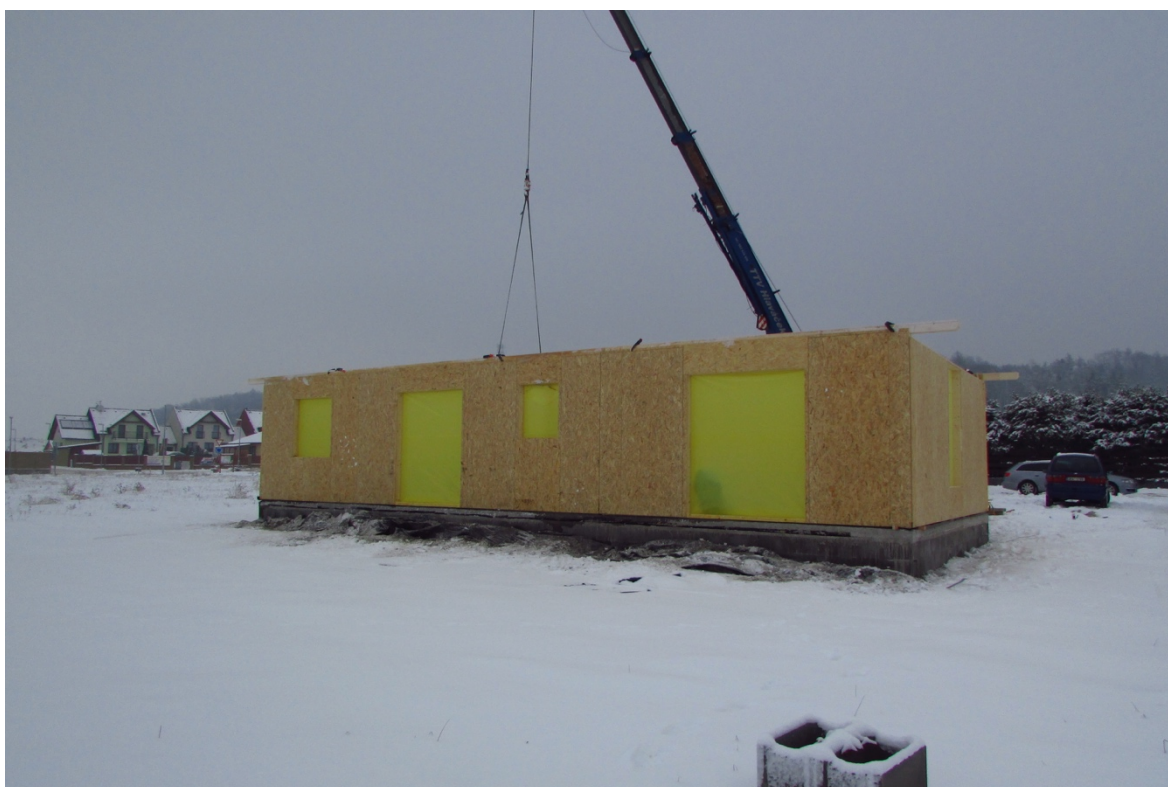
Obr.1.13: Pohled na RD
