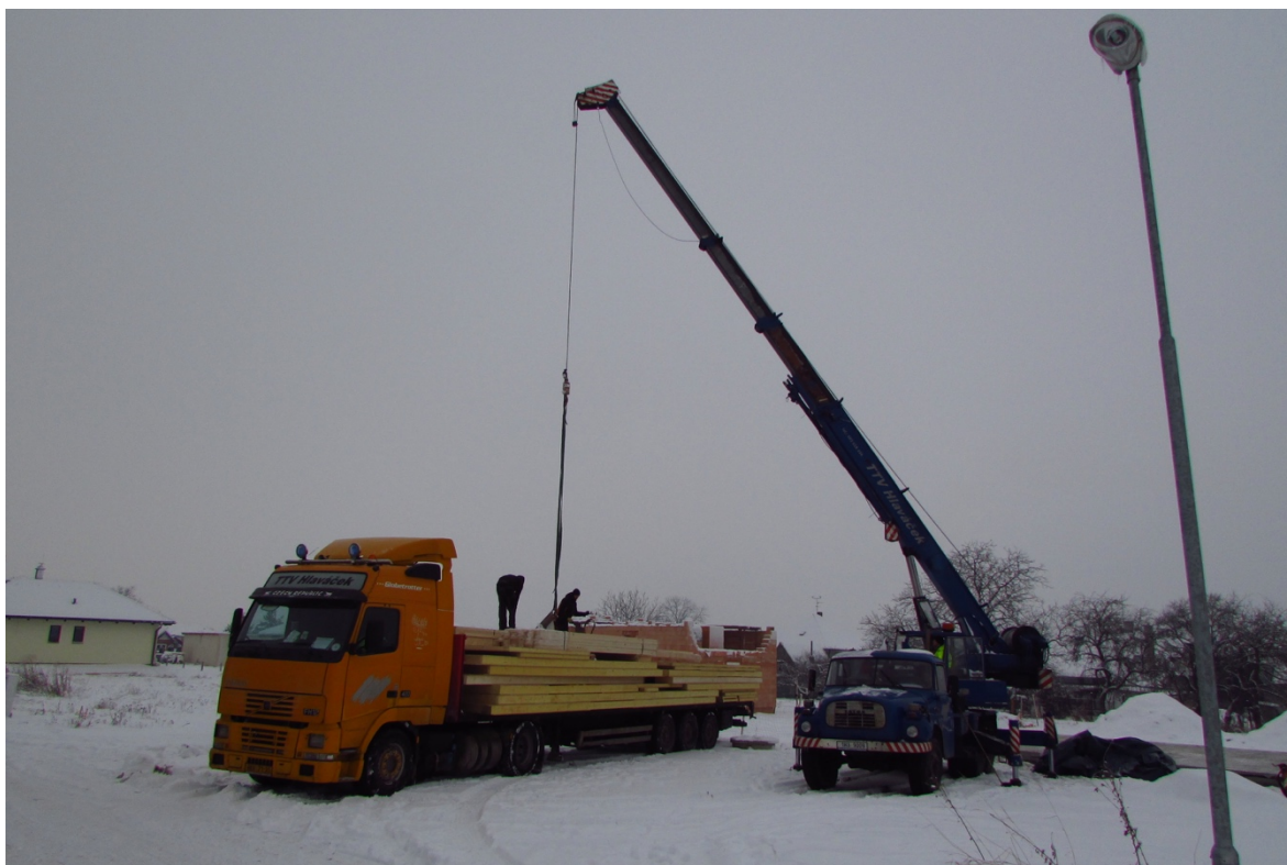
Obr.1.11: Upevnění panelu na jeřáb
