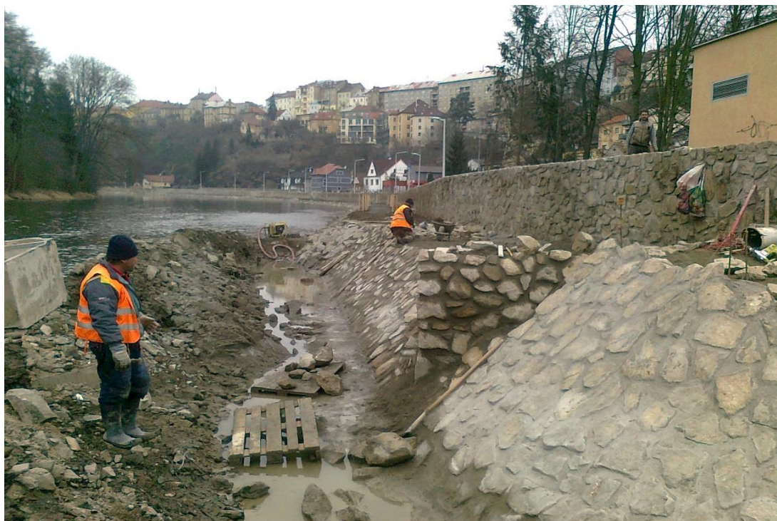
Obrázek 3 Výstavba protipovodňové hráze
