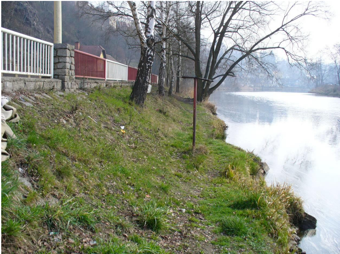
Obrázek 1 Fotodokumentace původního stavu
