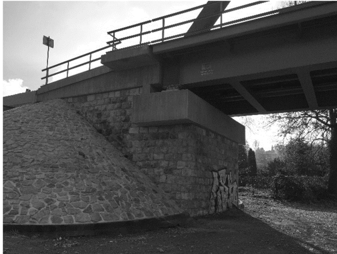
Obr. 3.7: Pohled na opěru železničního mostu v Boršově nad Vltavou
