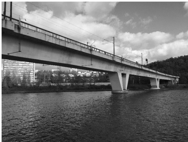
Obr. 3.1: Pohled na Holešovický most z levého břehu
