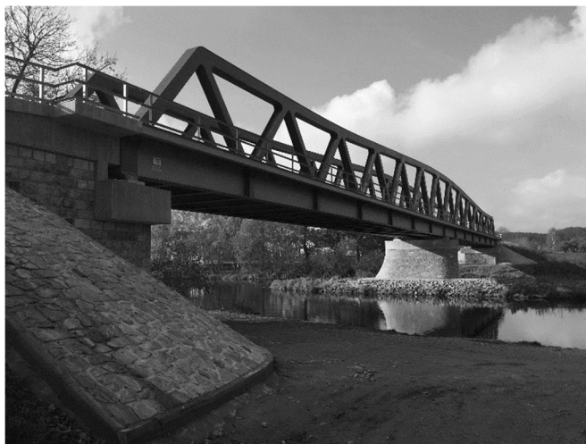
Obr. 3.6: Pohled na zrekonstruovaný železniční most v Boršově nad Vltavou
