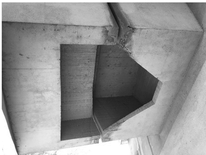
Obr. 3.2: Vylehčení průřezu u opěry
