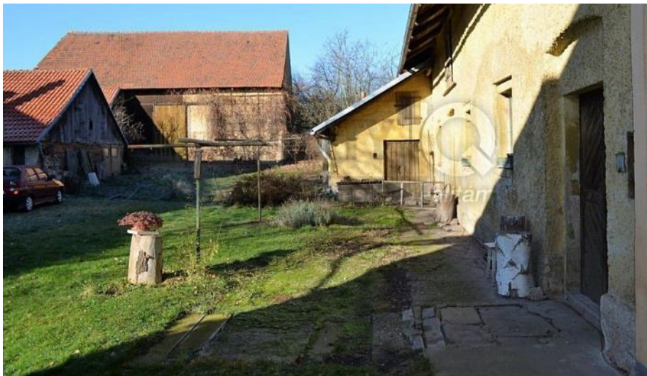
Obr. 7 Pohled do dvora domu v Drahodobudicích
