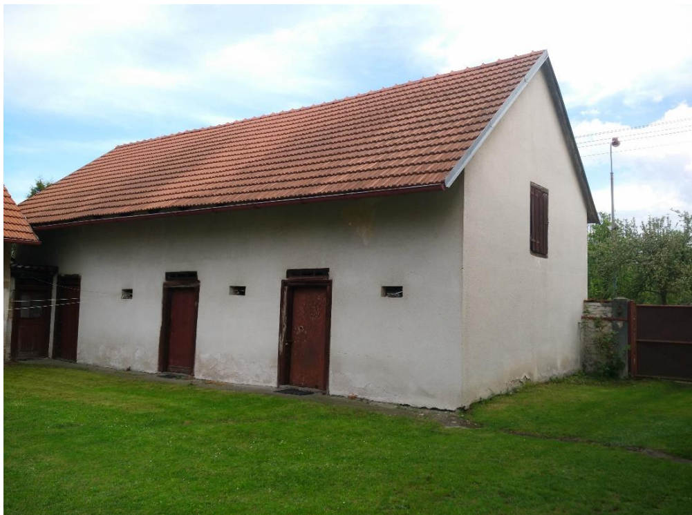
Obr. č. 3 Budova k uskladnění věcí (špejchar)
