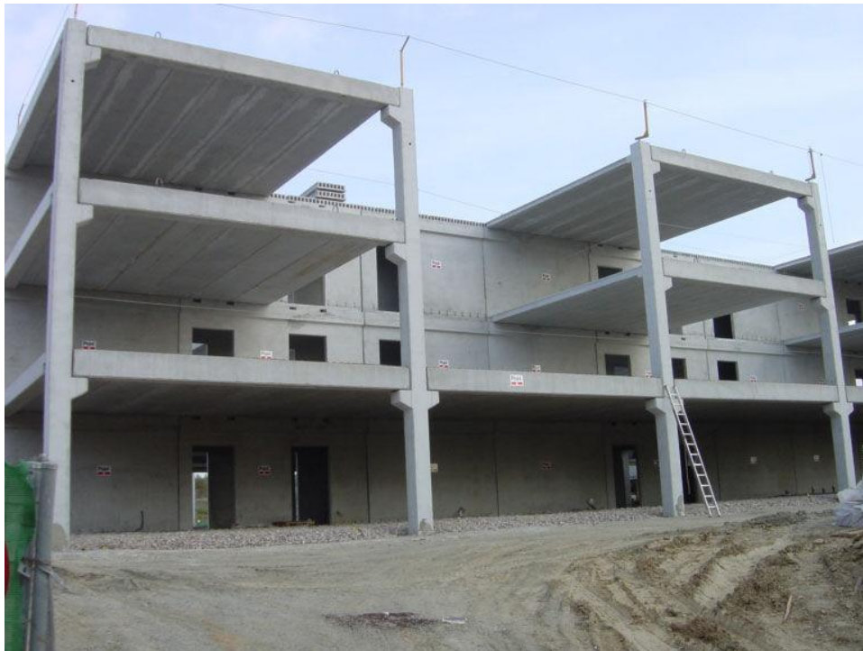
Obr. 1.1.: Příklad prefabrikované skeletové konstrukce [2]
