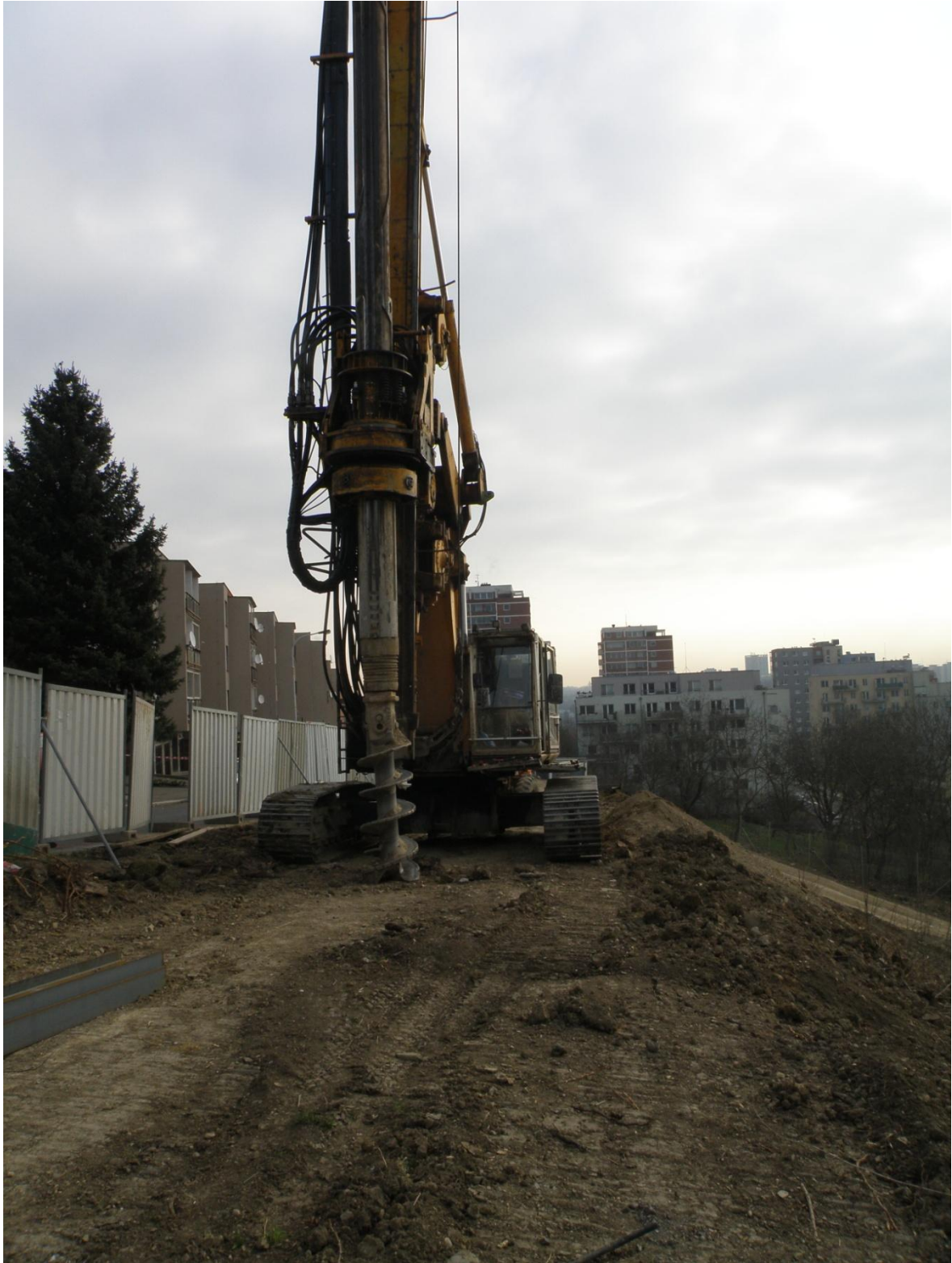
Obr. 2: vrtací souprava BAUER BG 22 H v první fázi výkopových prací
