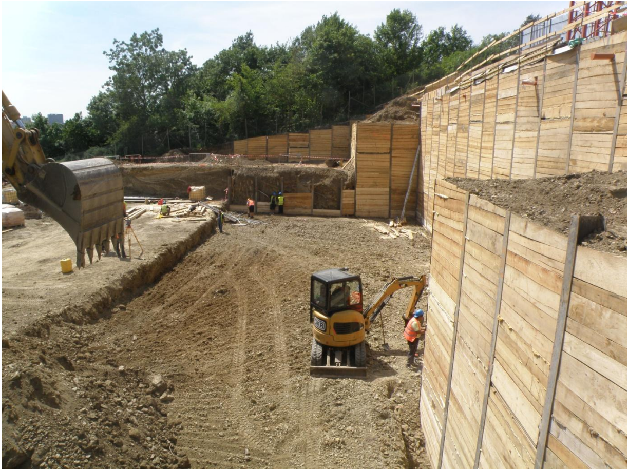
Obr. 5: Bagr CAT 303C CR v třetí fázi výkopových prací
