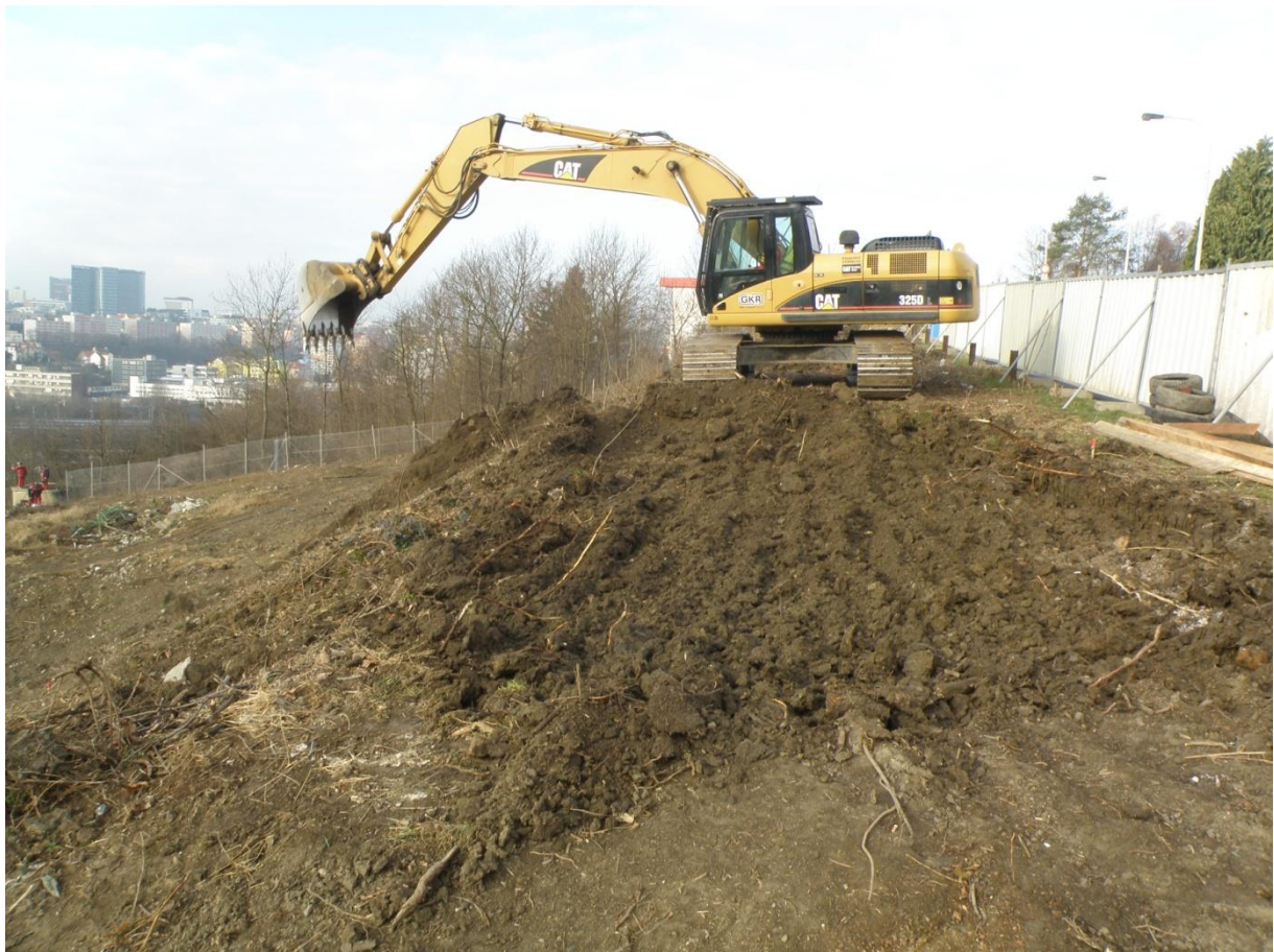
Obr. 1: Rypadlo CAT 325DL při začátku výkopových prací
