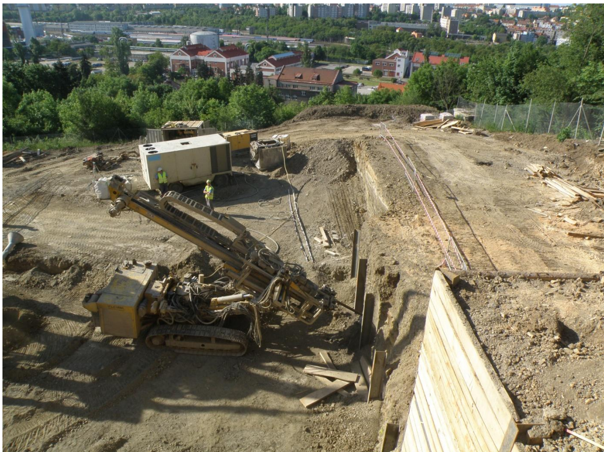
Obr. 4: Vrtací souprava KLEMM Bohrtechnik KR806-3D v třetí fázi výkopových prací
