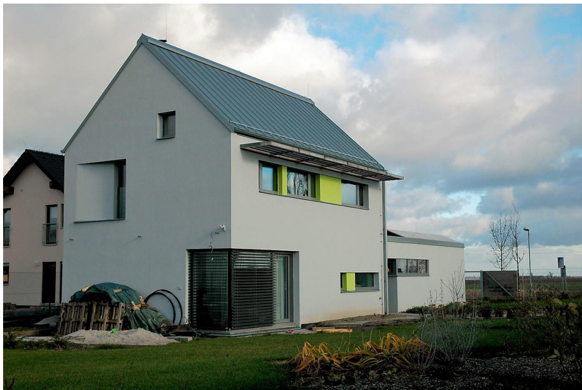
Obr. 10: Fotografie domu Rostoklaty. Zdroj: (Centrum pasivního domu)
