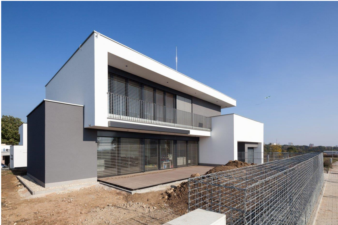
Obr. 8 Fotografie domu Kociánka. Zdroj: (Centrum pasivního domu)
