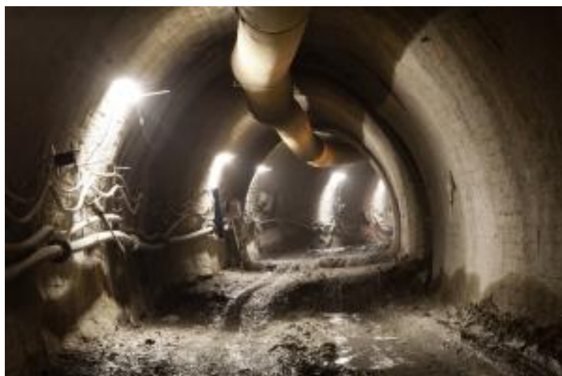
Obrázek č. 9: Průzkumná štola tunelu Radlice
