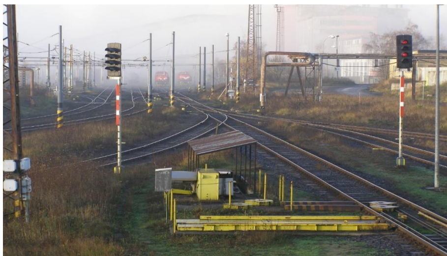
Obrázek 4 - pohled z velínu na místo příjezdu lokomotivy do plnicí stanice
