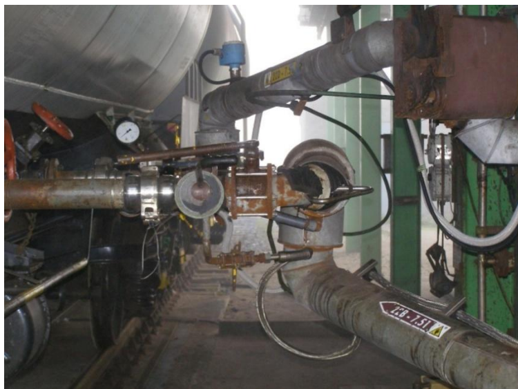
Obrázek 6 - připojení plnicího ramene
