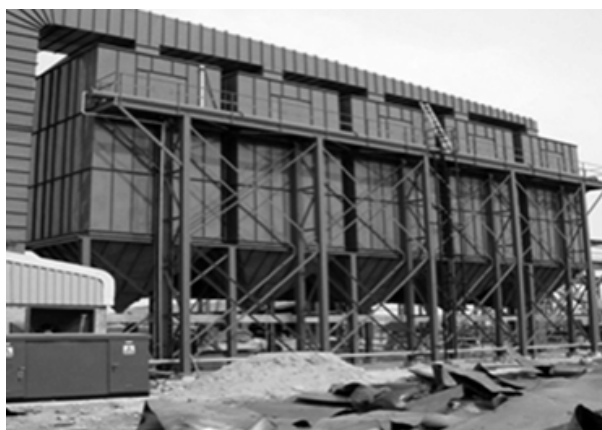
Obr. 4.3 – Tkaninové hadicové filtry zabírají značný obestavěný prostor. [19]
