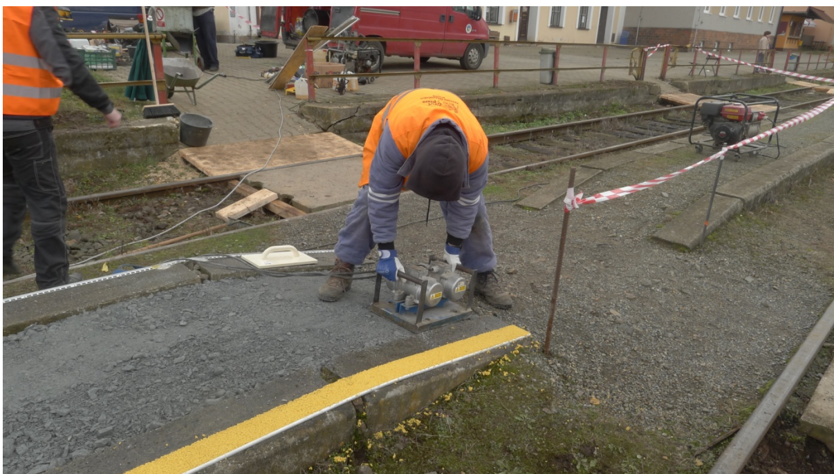
Obr. 65 Hutnění dosypané štěrkodrti
