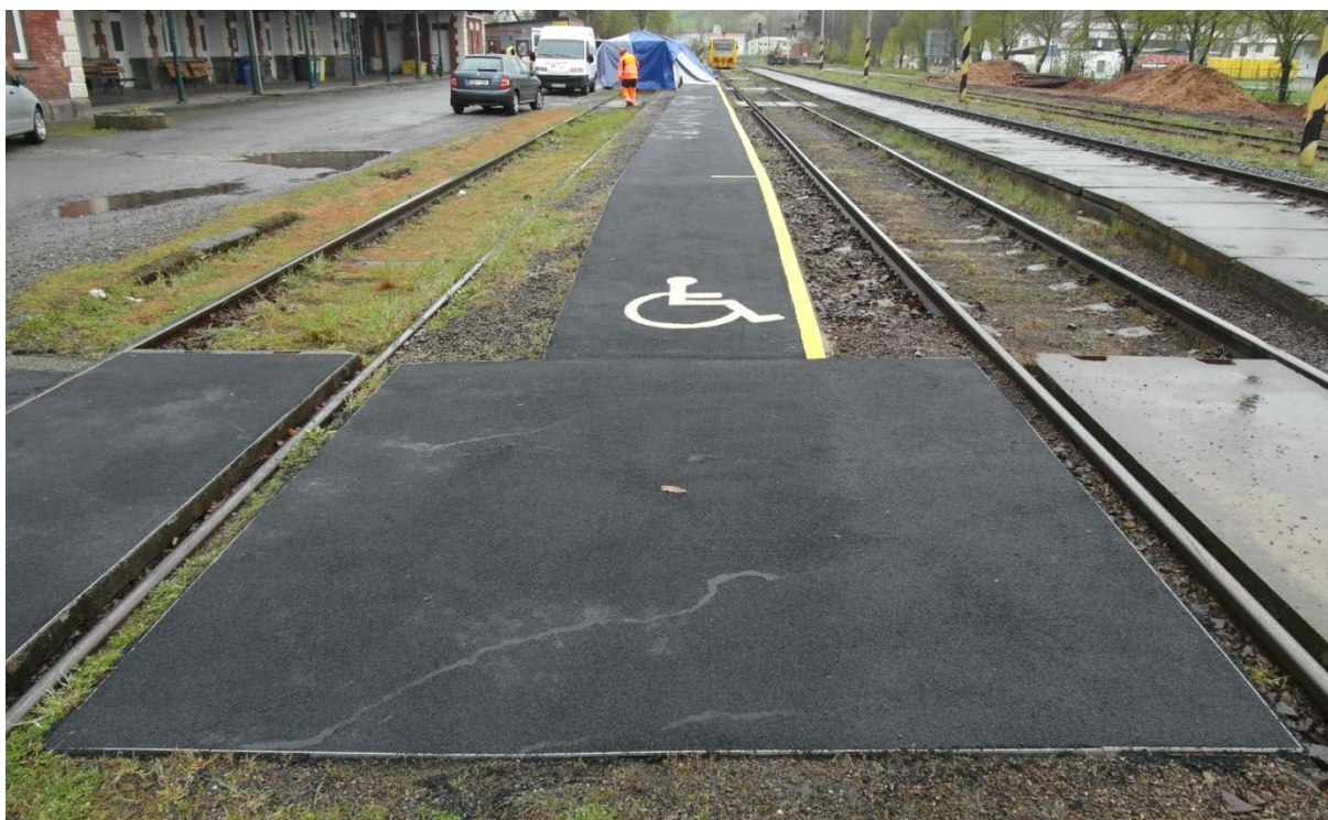
Obr. 102 Pohled na provedené povrchy gumové stěrky směrem k výpravní budově
