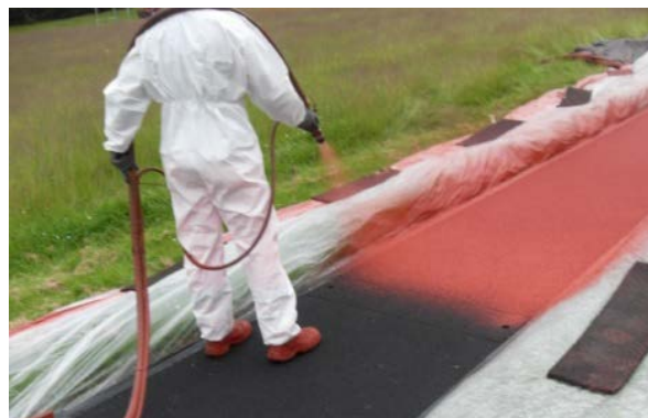
Obr. 35 Nástřik "spray" vrstvy
