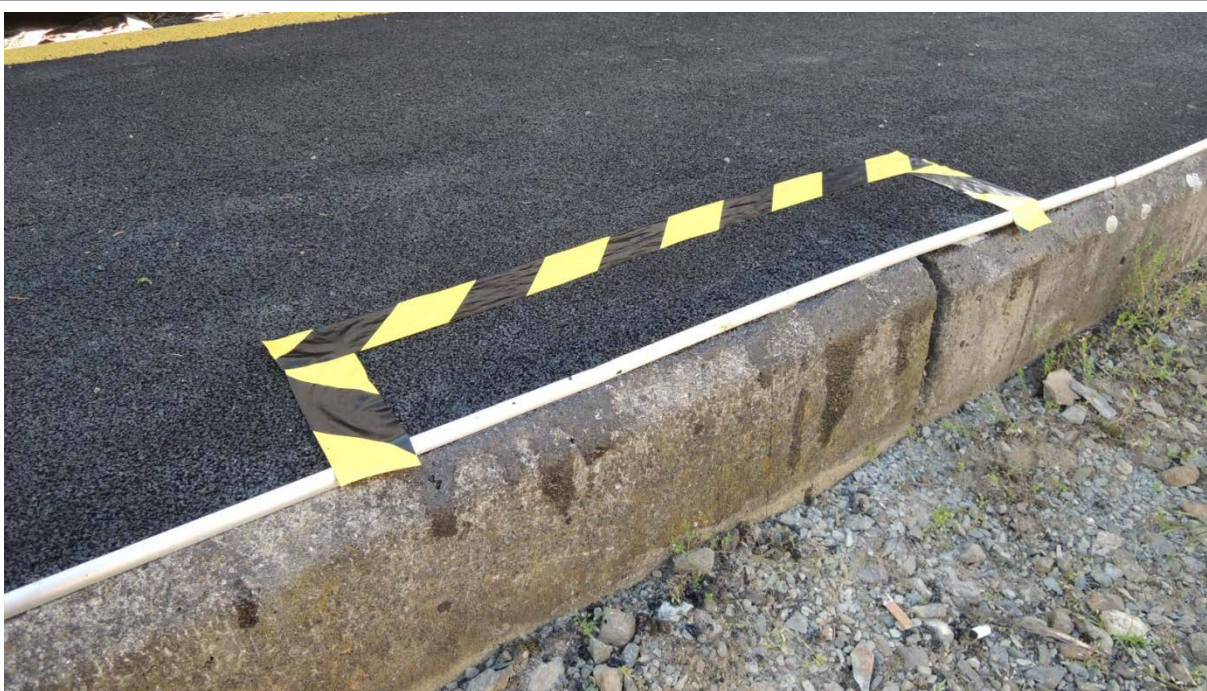
Obr. 86 Provedená oprava ochranné Alu lišty a odtrženého povrchu
