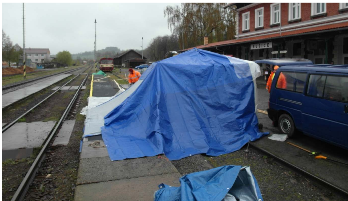
Obr. 100 Pokládka gumové stěrky na přechodu, zvýrazňující pás na hraně nástupiště
