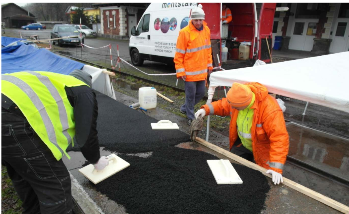
Obr. 99 Pokládka gumové stěrky na nástupišti v prostoru přechodu
