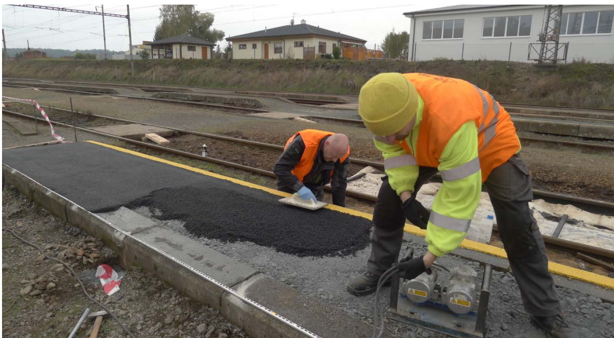
Obr. 68 Pokládka gumové stěrky na nástupišti, hutnění dosypu
