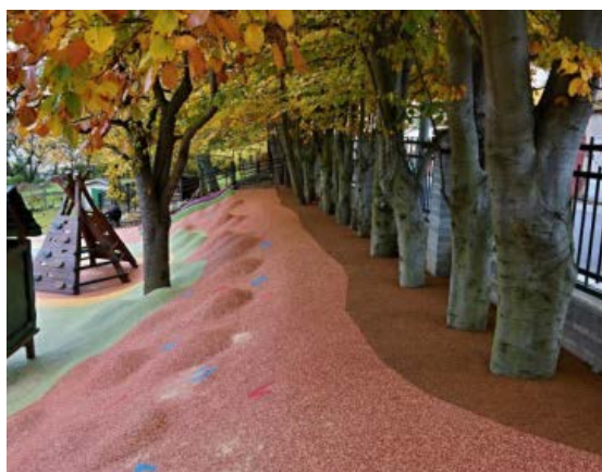
Obr. 45 Školní hřiště s povrchem EPDM Mulch
