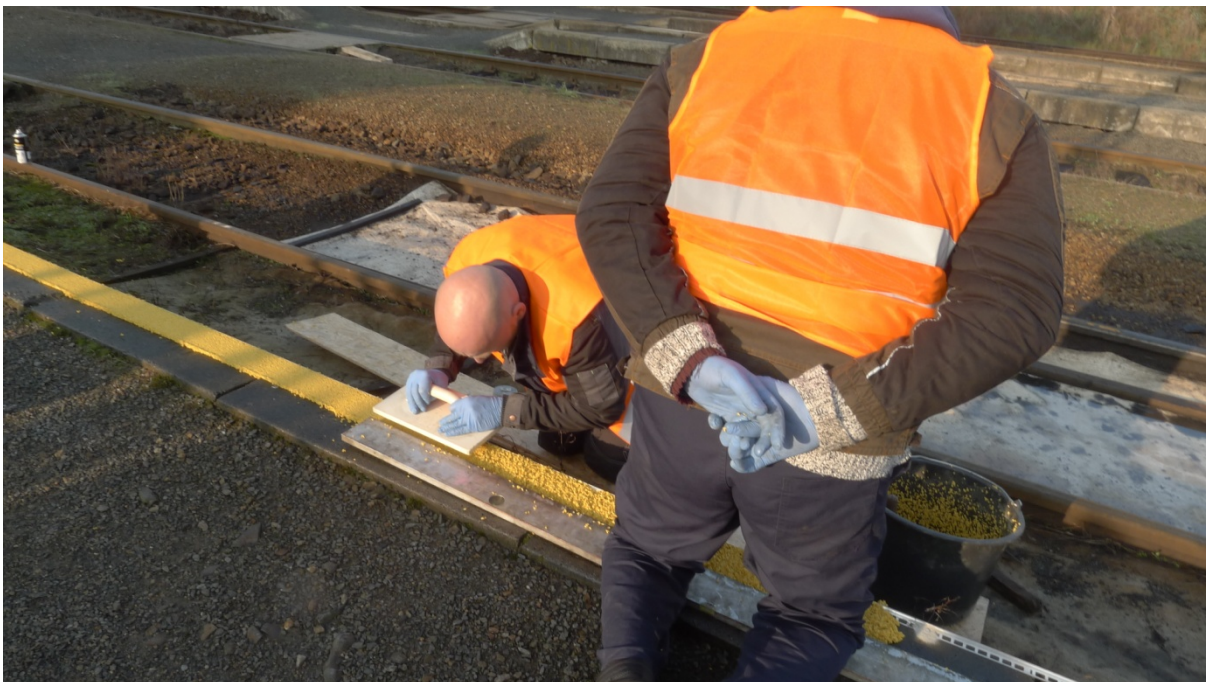
Obr. 64 Pokládka žlutého pásu
