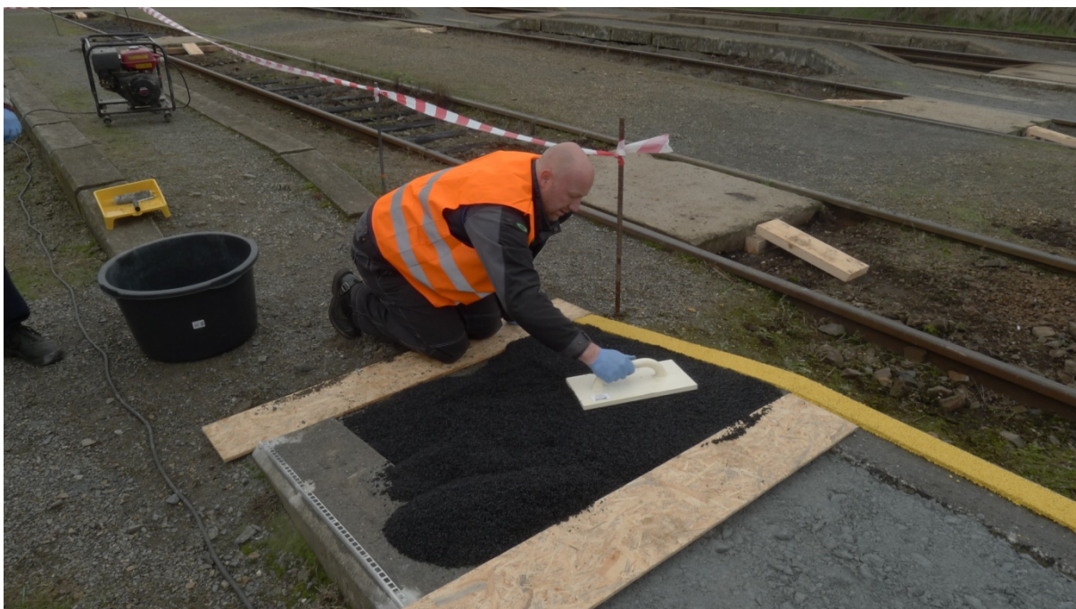
Obr. 66 Pokládka gumové stěrky na rampě nástupiště
