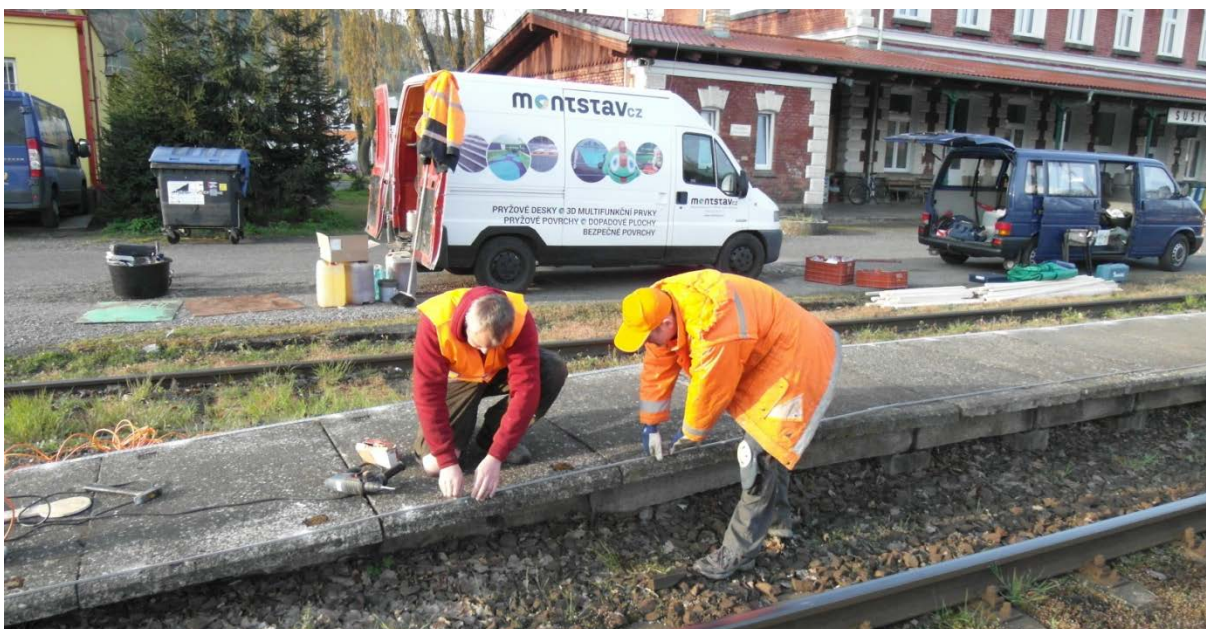
Obr. 91 Montáž ochranných lišt hran
