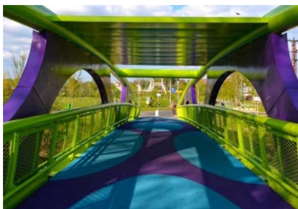
Obr. 28 Povrch lávky přes Ohří v Karlových Varech
