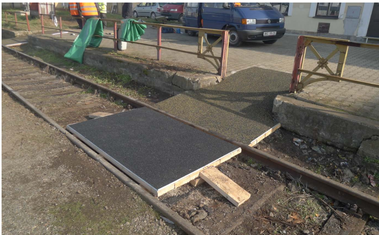
Obr. 77 Hotový povrch druhého přechodu a přístupové rampy
