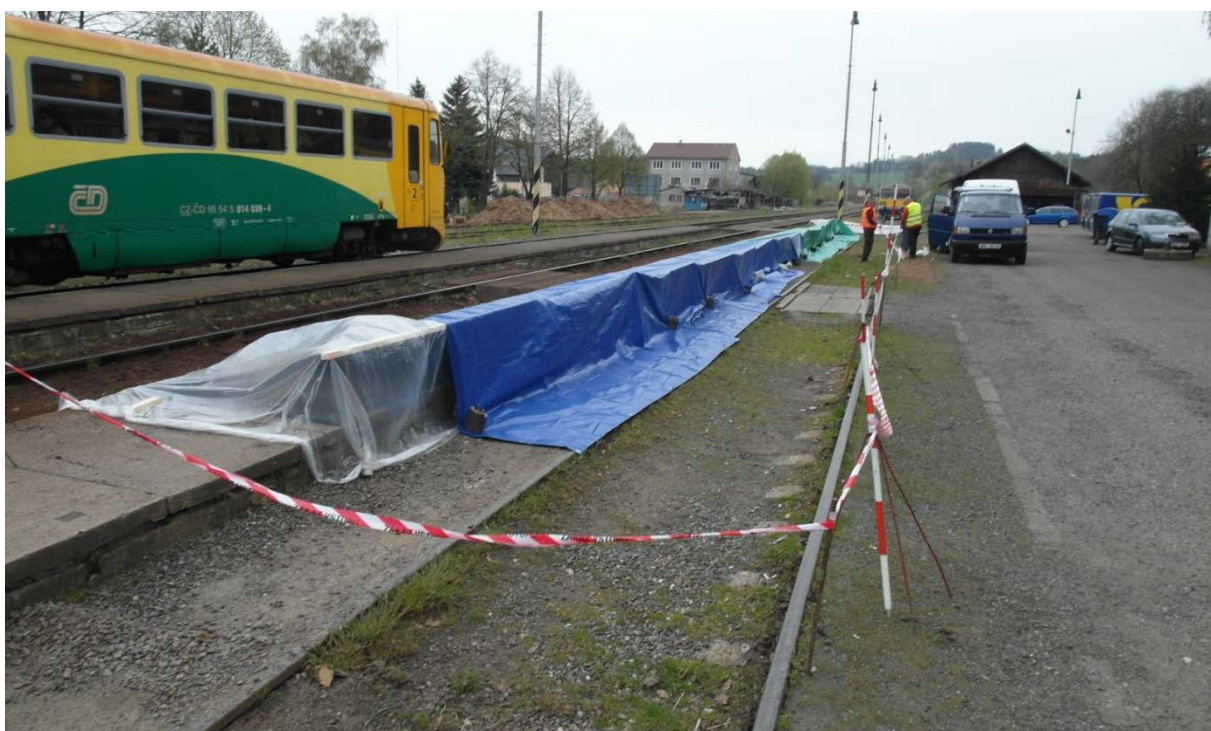
Obr. 98 Hotové zastřešení nástupiště
