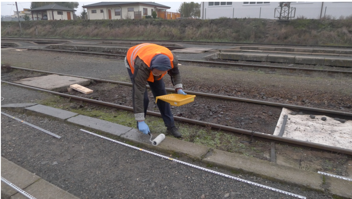
Obr. 63 Penetrování podkladu
