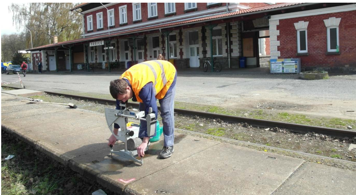
Obr. 103 Příprava přístroje před měřením - vyrovnání přístroje
