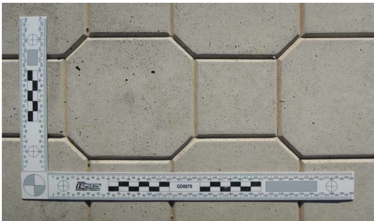
Obr. 107 Detail povrchu nástupištního panelu SUDOP KS - 230
