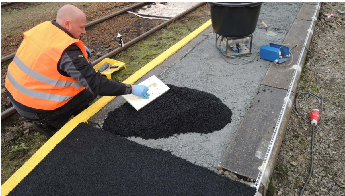
Obr. 67 Pokládka gumové stěrky na nástupišti
