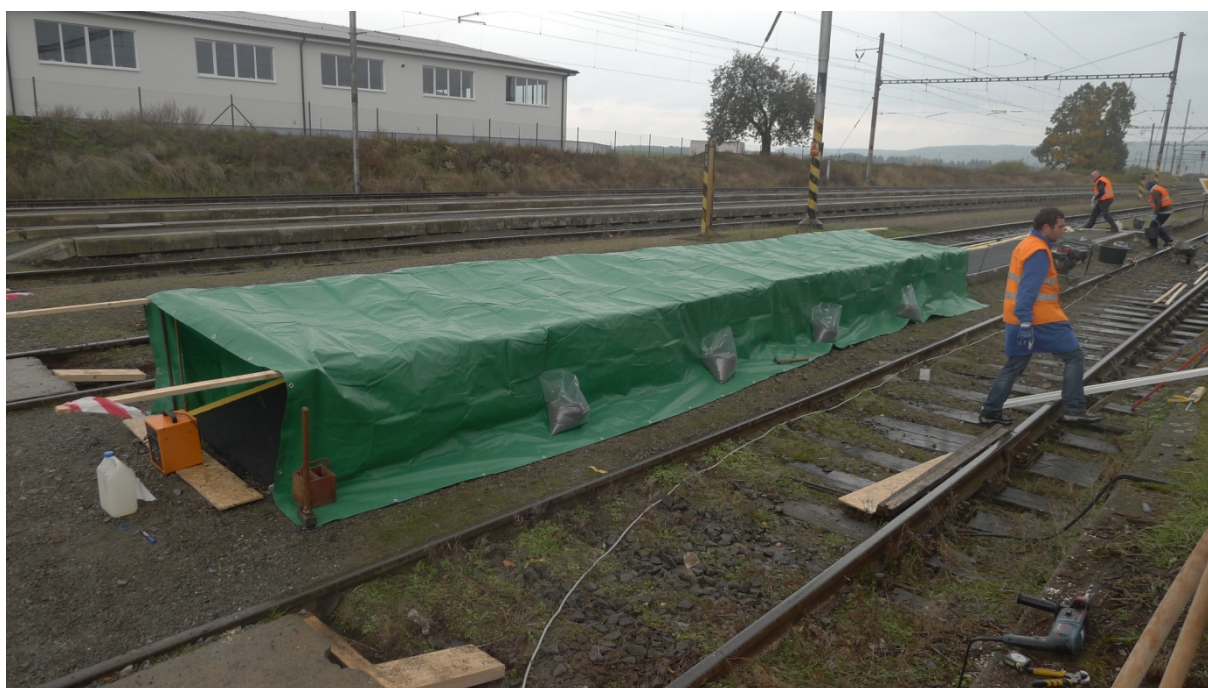
Obr. 70 Montáž krycího tubusu nástupiště, začátek vytápění
