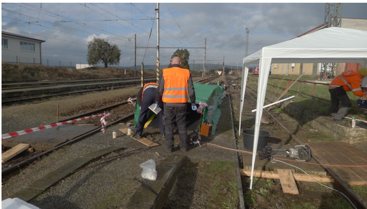
Obr. 72 Dokončování rampy nástupiště, zastřešení přechodu a přístupové rampy
