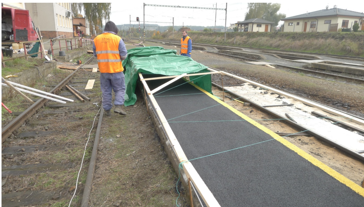
Obr. 69 Montáž krycího tubusu nástupiště
