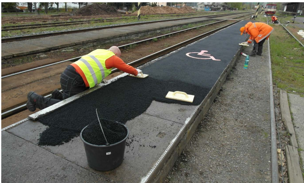
Obr. 93 Pokládka gumové stěrky na nástupišti
