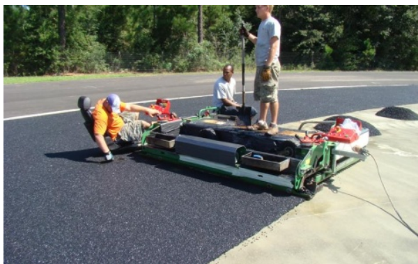
Obr. 34 Strojní pokládka tlumící vrstvy
