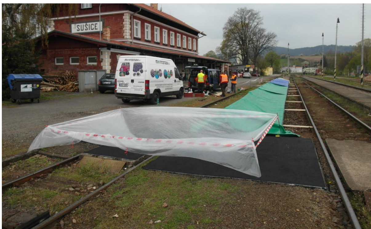
Obr. 97 Montáž zastřešení přechodu a nástupiště
