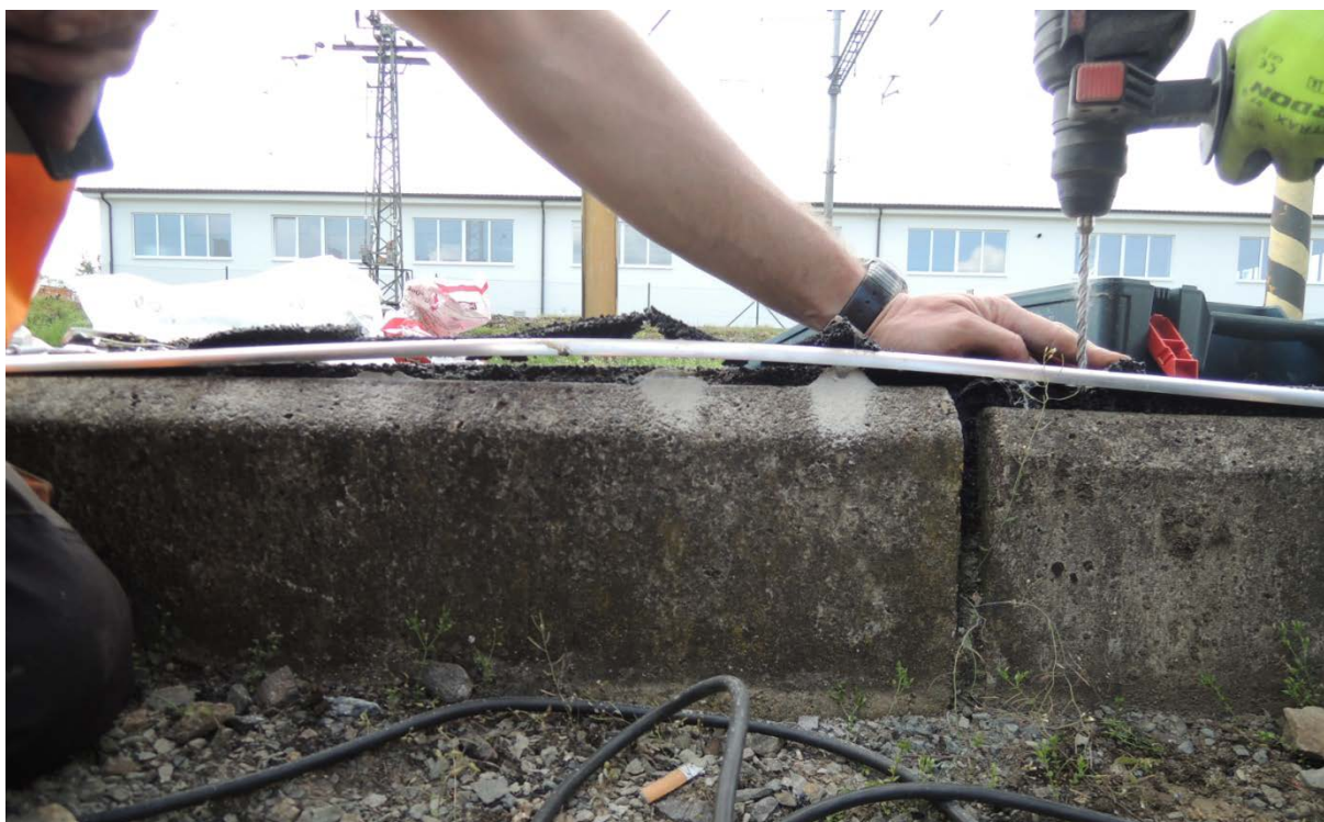
Obr. 83 Připevnění vyboulené ochranné hliníkové lišty
