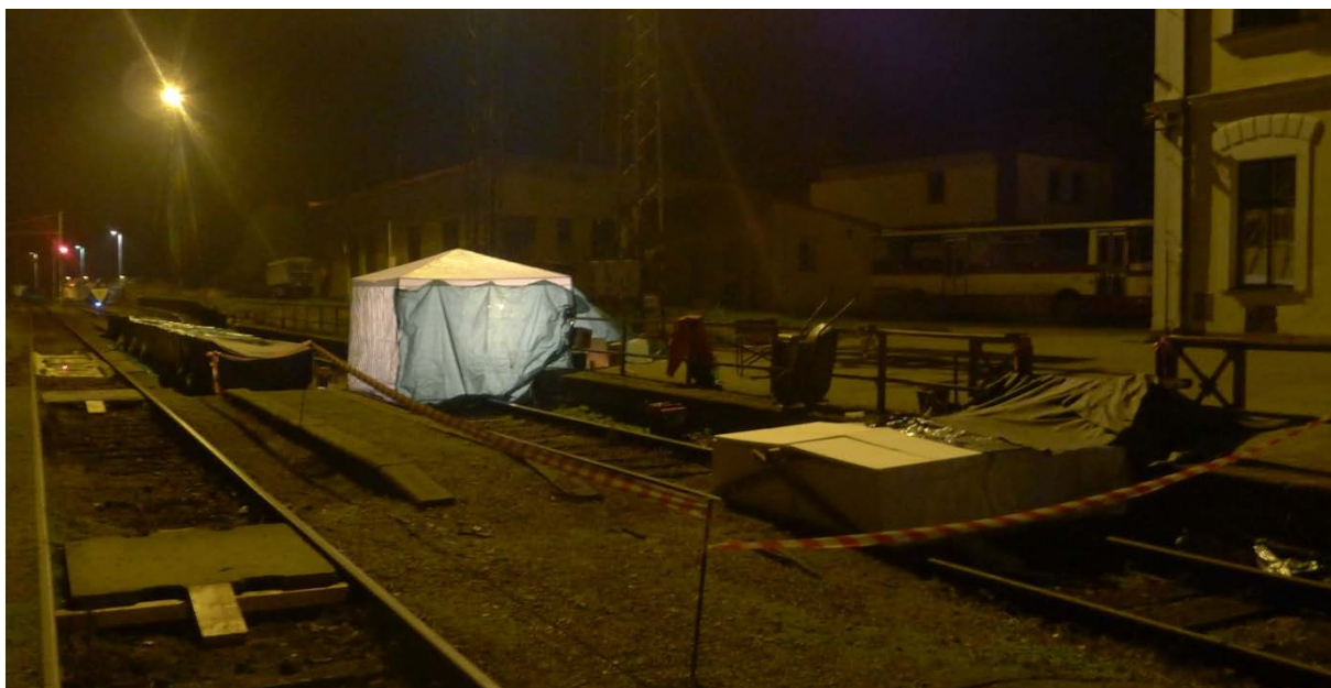
Obr. 74 Hotové zastřešení nově poležených povrchů
