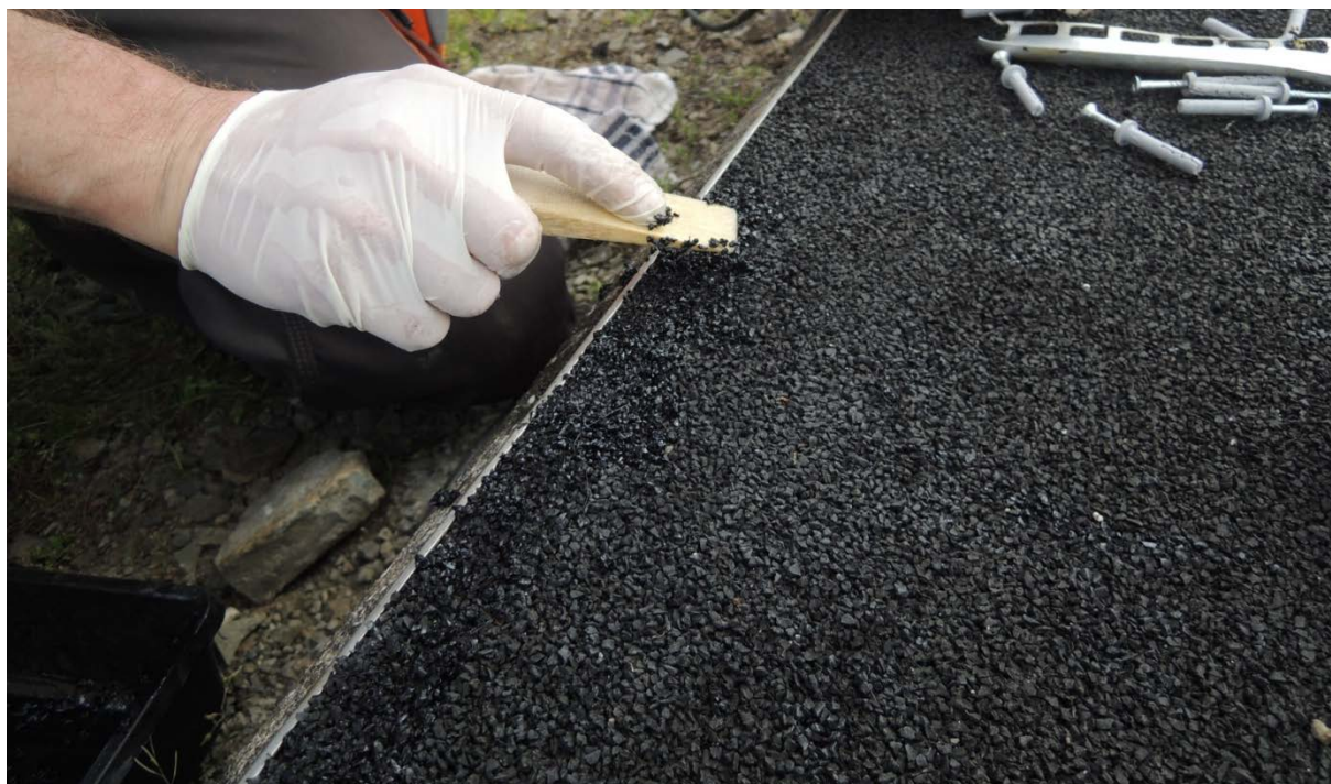
Obr. 85 Oprava odtrženého povrchu
