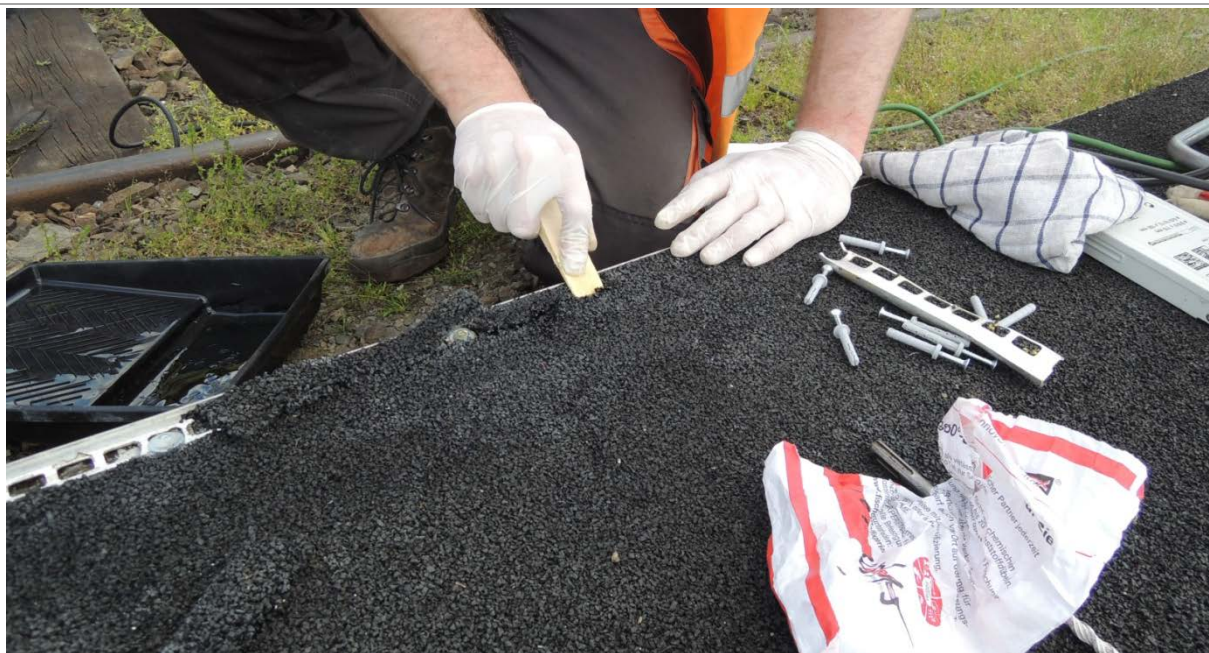
Obr. 84 Oprava odtrženého povrchu
