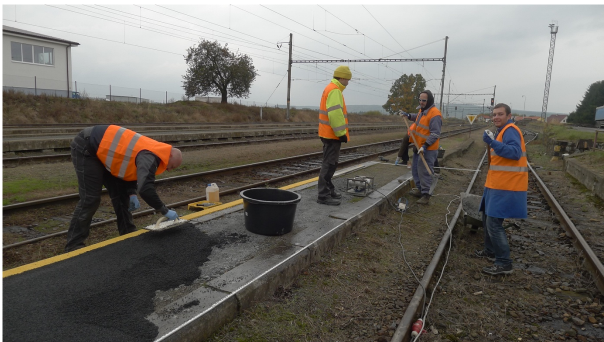
Obr. 71 Pokládka gumové stěrky na nástupišti
