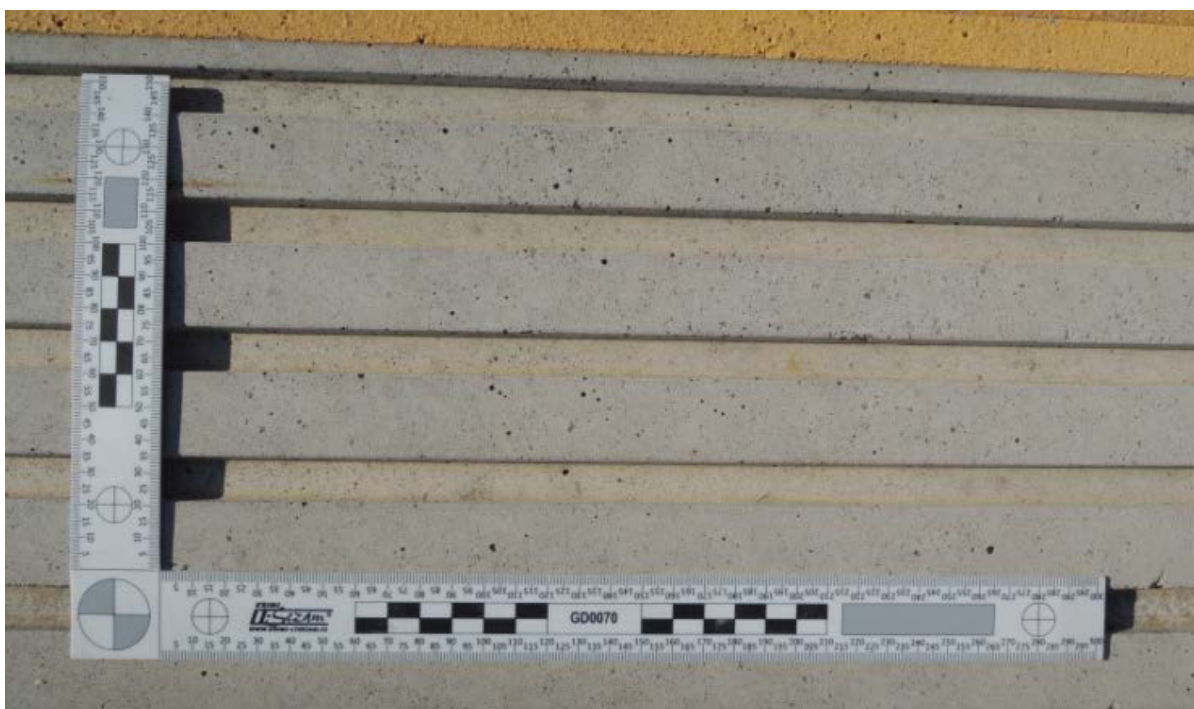
Obr. 108 Detail vodícího pásu nást. panelu SUDOP KS - 230
