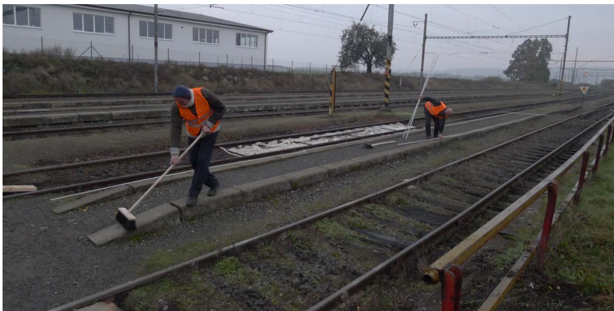
Obr. 62 Příprava podkladu nástupiště
