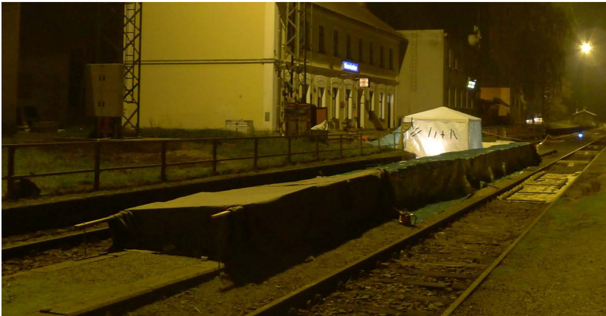
Obr. 75 Hotové zastřešení nově poležených povrchů
