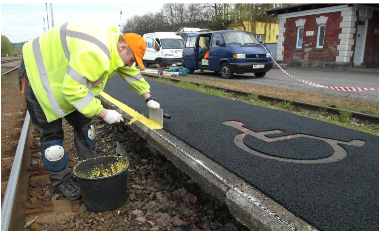
Obr. 94 Pokládka žlutého pásu
