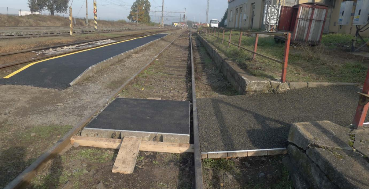
Obr. 76 Hotový povrch přechodu, přístupové rampy a nástupiště
