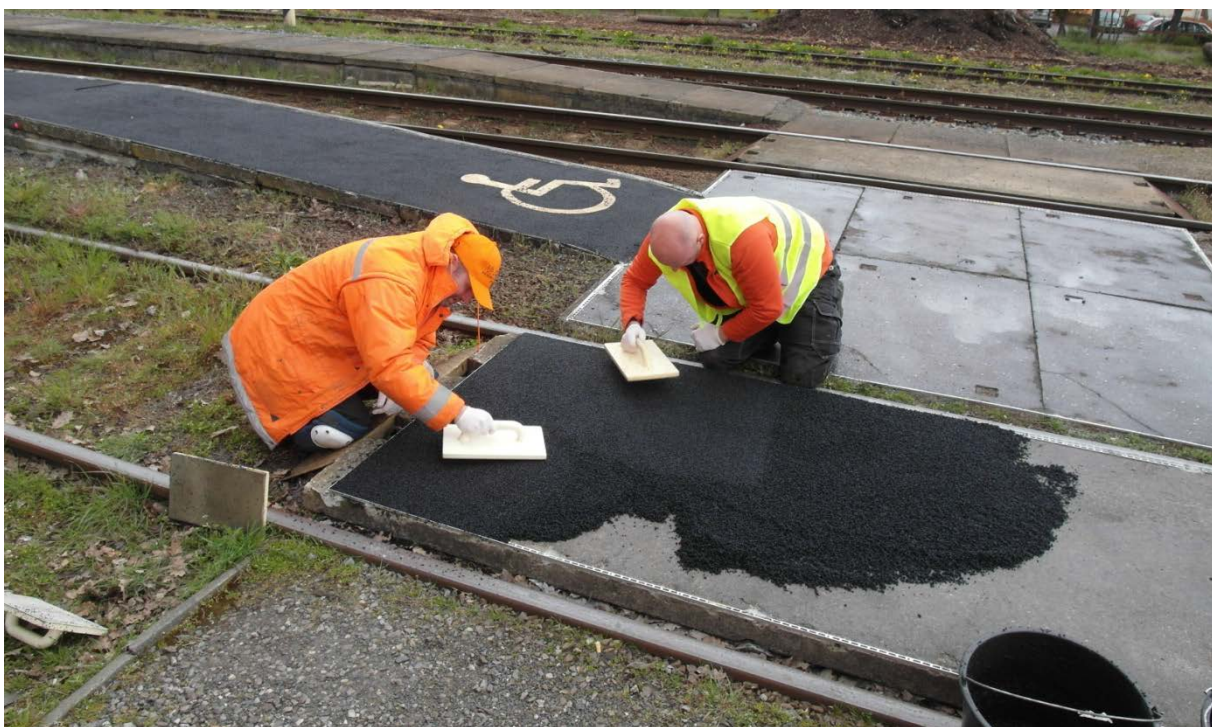
Obr. 95 Pokládka gumové stěrky přechodu
