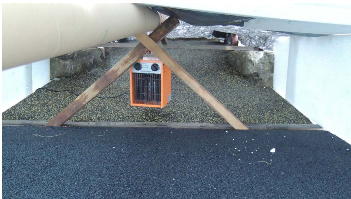
Obr. 73 Vytápění prostoru druhého přechodu a přístupové rampy
