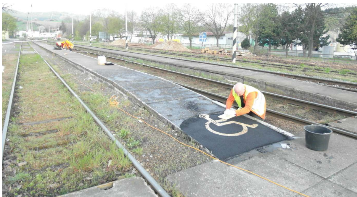
Obr. 92 Pokládka gumové stěrky na rampě nástupiště, s použitím šablony symbolu vozíčkáře
