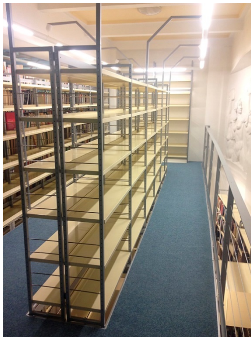
Obrázek č. 24 - Přidání regálů a rozšíření pochozí konstrukce v knihovně, Zdroj: (6)
