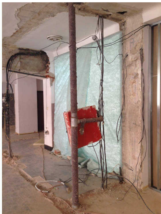
Obrázek č. 22 - Bourací práce, Zdroj: (6)
