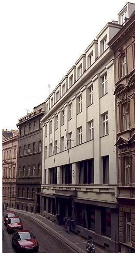
Obrázek č. 7 - Budova Marathon, Zdroj: (11)
