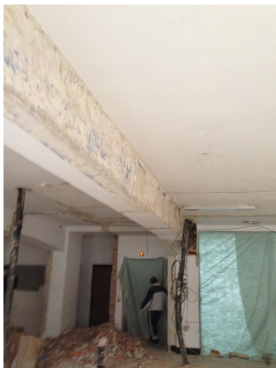
Obrázek č. 23 - Bourací práce, Zdroj: (6)
