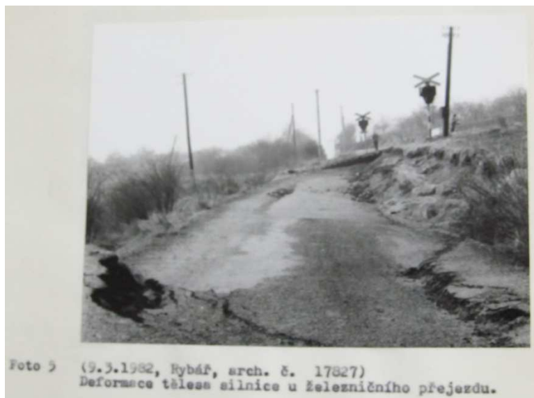
Obr. 2: Deformace tělesa silnice z roku 1982
