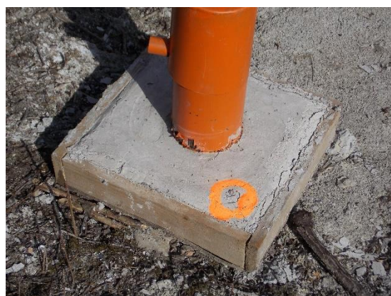
Obr. 4 Stabilizace bodu - nastřelovací hřebík
