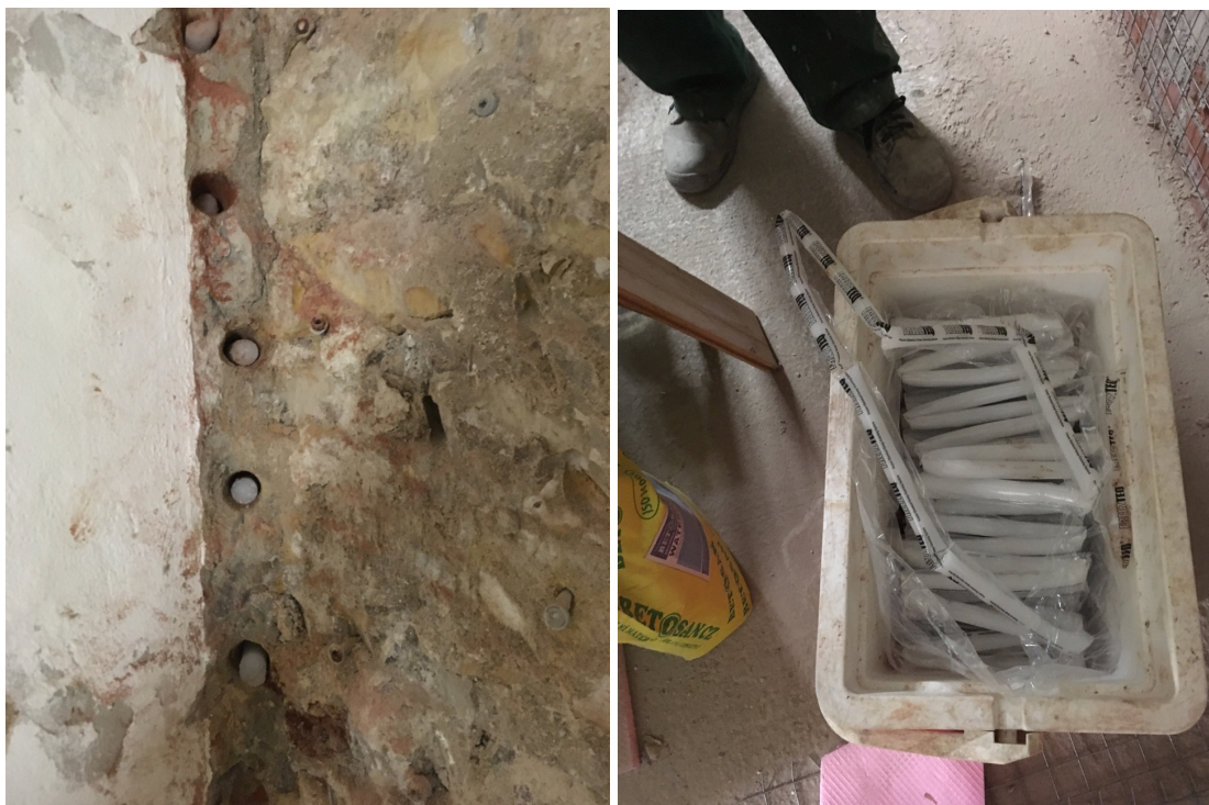
Obrázek 4: Vyplnění svislých vrtů hmotou FREEZTEQ
