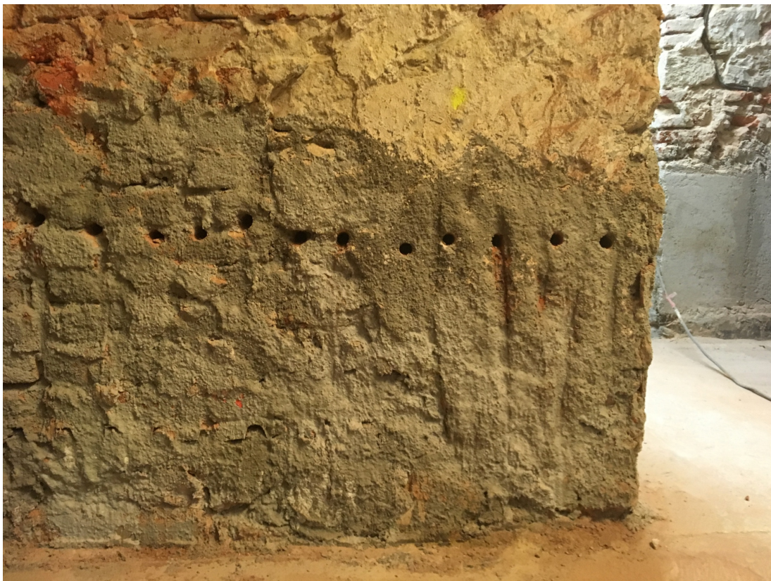
Obrázek 3: Vodorovné vrtý v cihelném zdivo pro aplikaci FREEZTEQ
