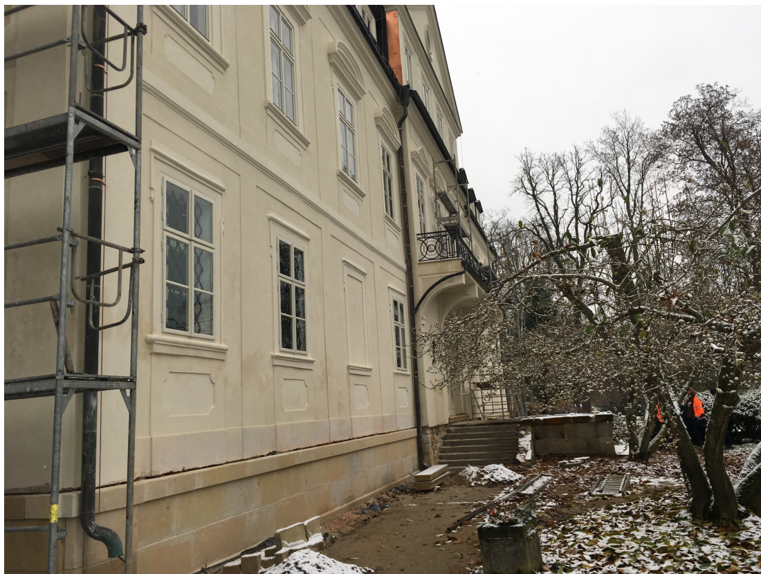
Obrázek 13: Strana fasády po opravě omítek a přeštukování kamenných prvků
