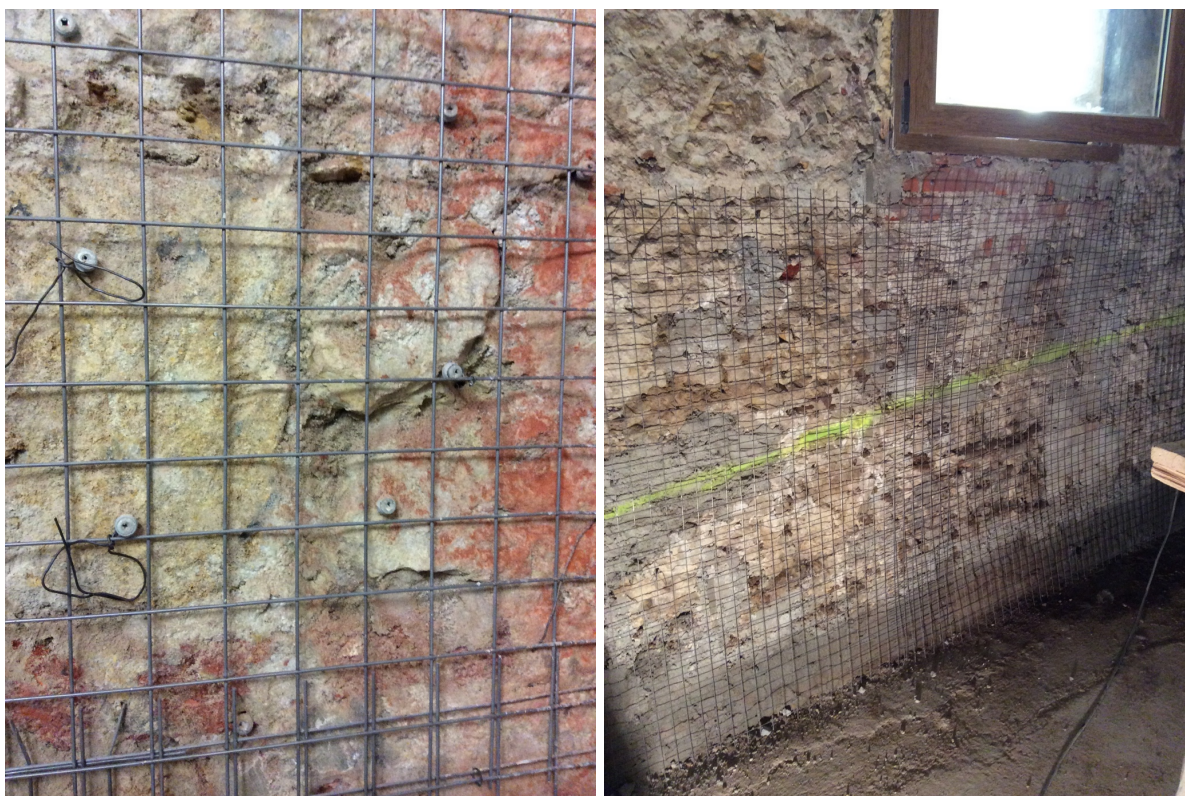
Obrázek 6: Uchycení sítě ARMOBET pomocí vázacího drátu na šrouby
