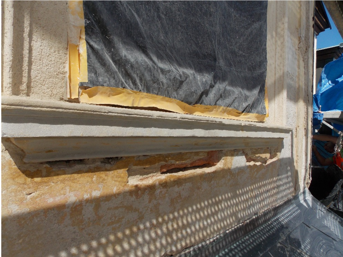
Obrázek 12: Parapet před nanesením štukové vrstvy
