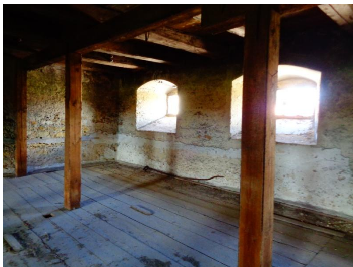
Obrázek 8: Pohled na dřevěný strop, podlahu a okna
