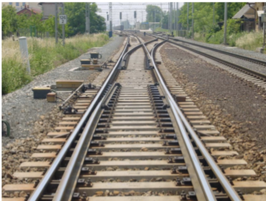
Obrázek 33: Realizovaná dodávka železniční výhybky - Hrušovany
