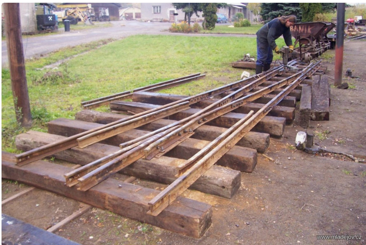
Obrázek 37: Renovace výhybky demontované na Nové Vsi
