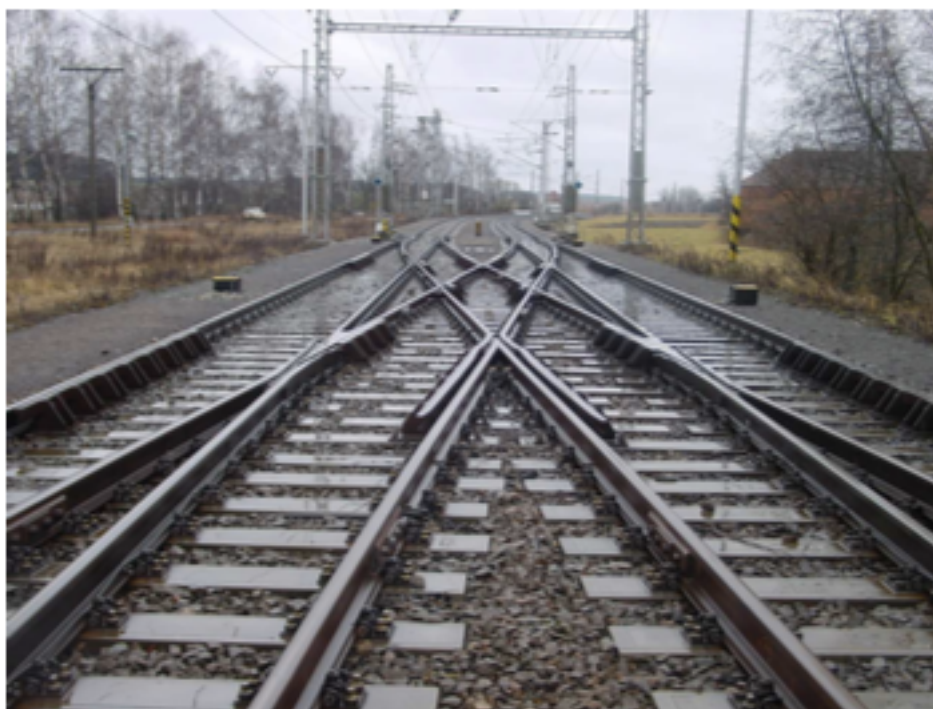
Obrázek 34: Realizovaná dodávka železniční výhybky - Opatov
