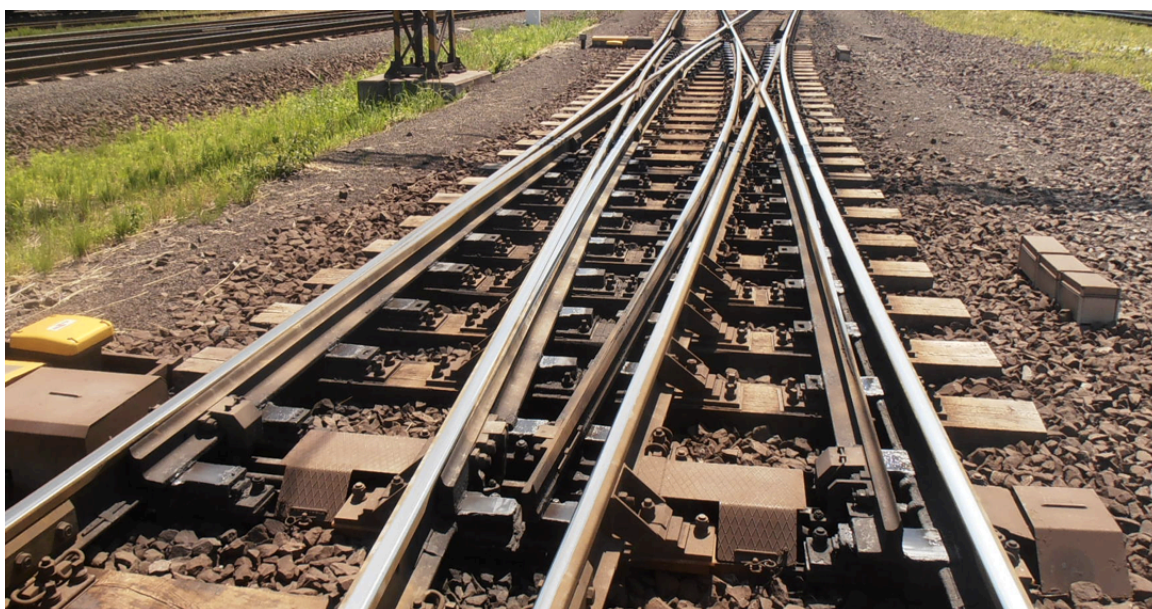
Obrázek 22: Křižovatková výhybka celá, dvojitě srdcovky pevné
