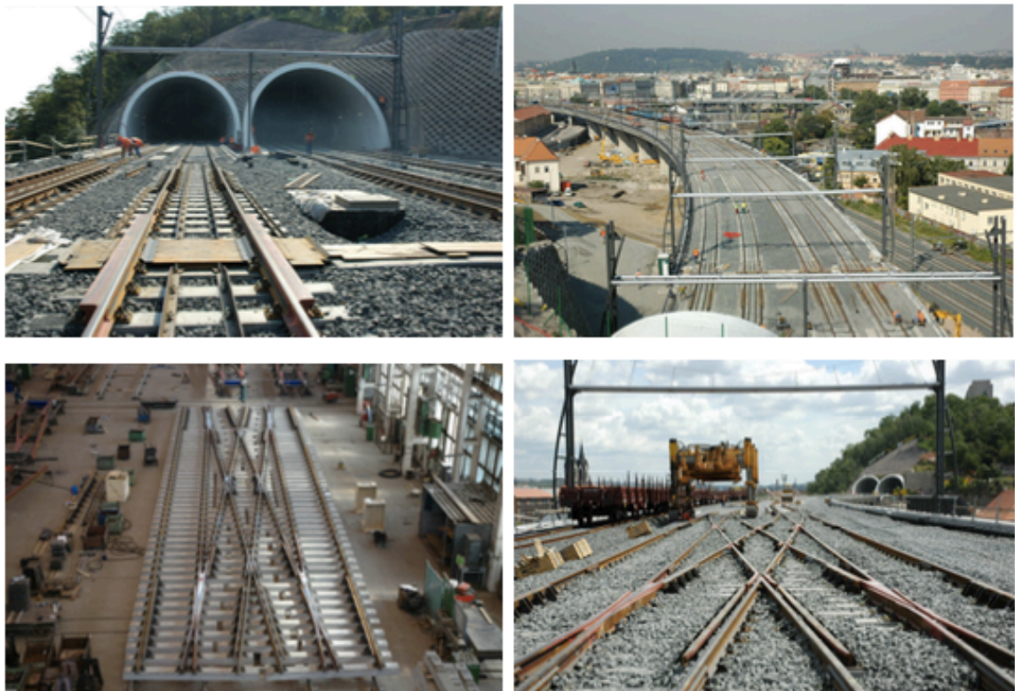
Obrázek 31: Realizovaná dodávka železniční výhybky - Praha Nové spojení
