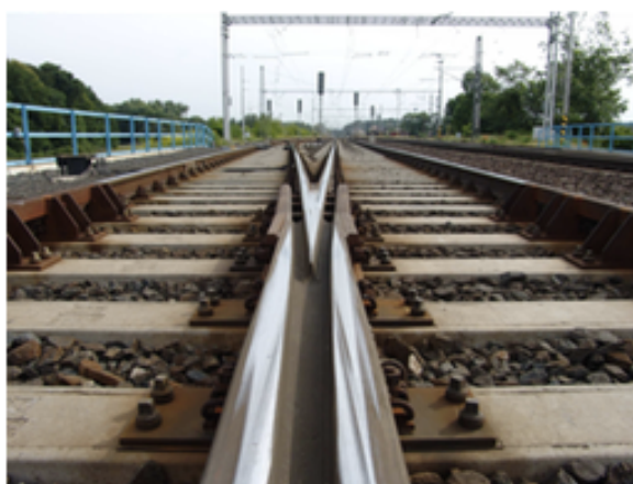
Obrázek 36: Realizovaná dodávka železniční výchybky – Záboří nad Labem
