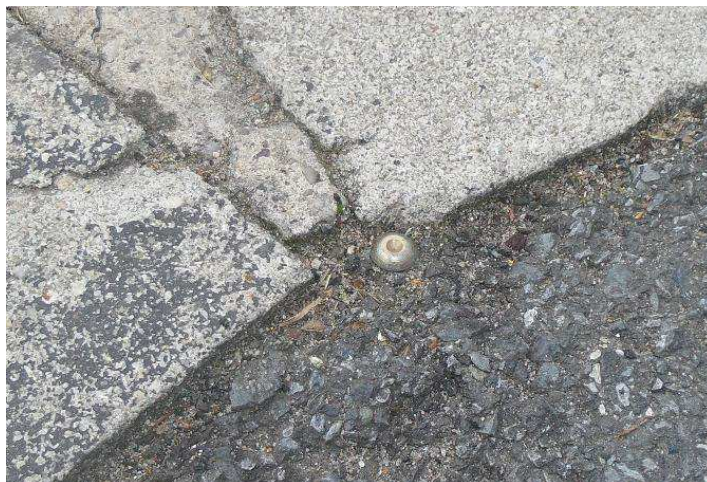
Obr. 4.2: Dočasná stabilizace kovovými hřebíky
