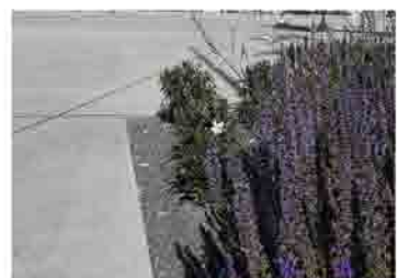
pochozí plocha - lité betonové desky
