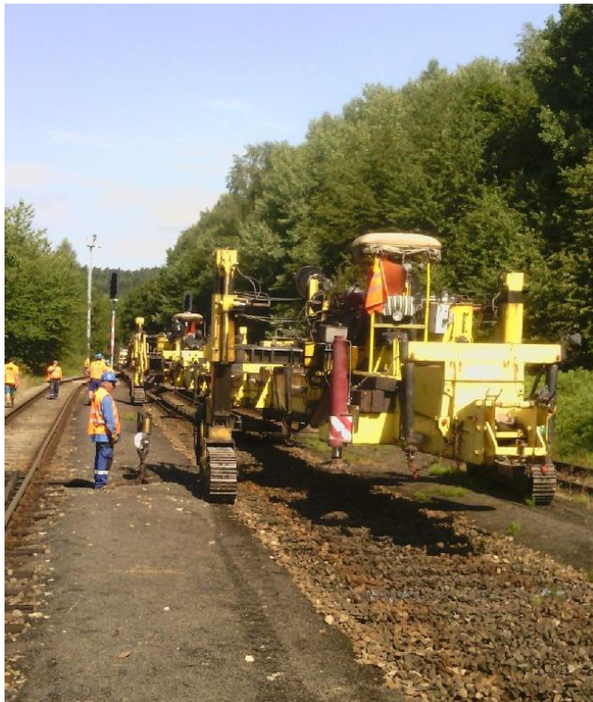
Obrázek 2: Trhání roštu v Hodkovicích nad Mohelkou [1]
