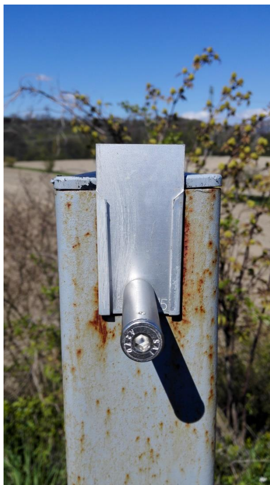
Obrázek 8: Konzolová značka (foto: Hovorka, 2017)
