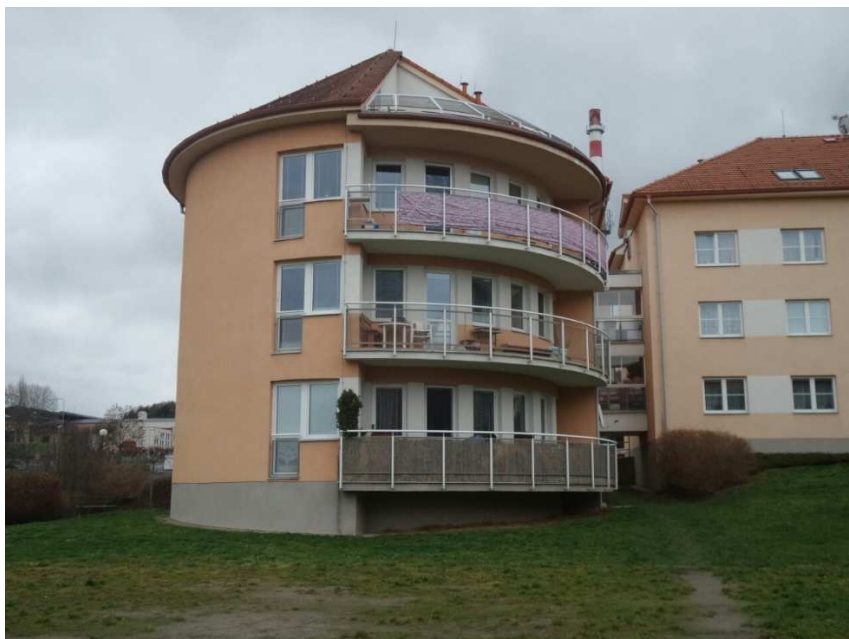
Obrázek 2 - Bytový dům D (SV pohled)
