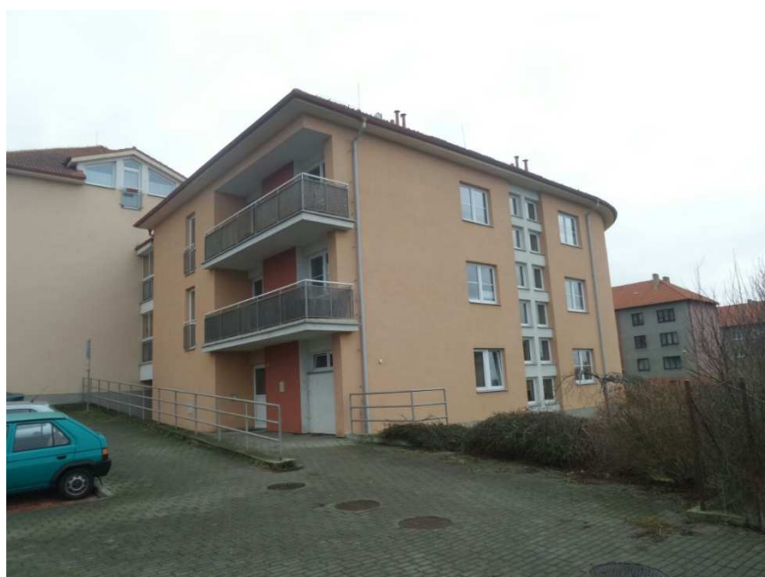
Obrázek 1 - Bytový dům D (SZ pohled)
