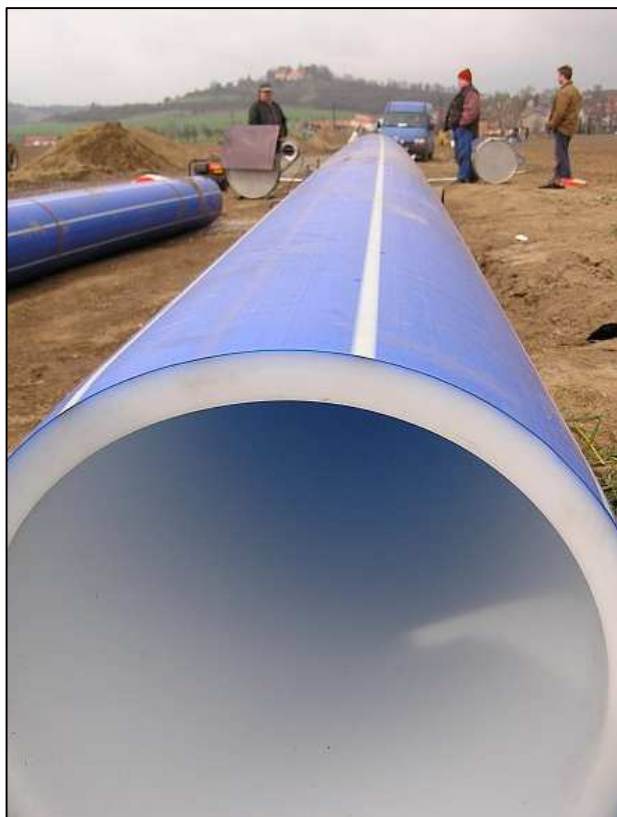
Obr. 10. Potrubí z PE 100 s vnějším ochranným pláštěm (6)
