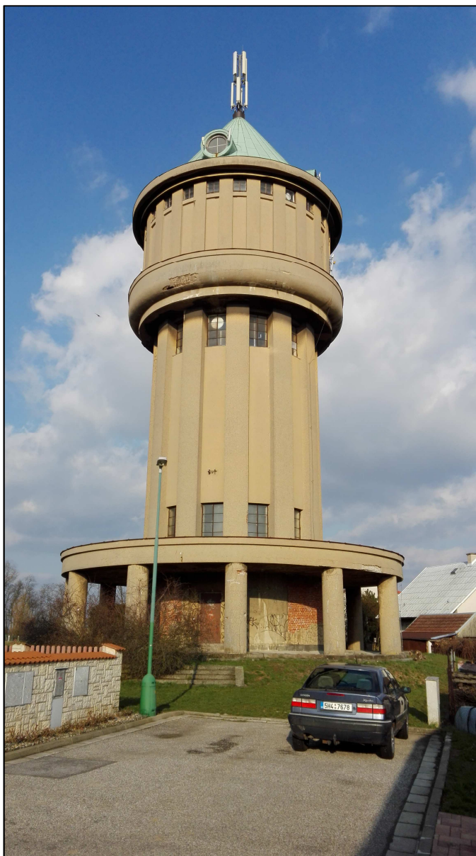
Obr. 17. Věžový vodojem Jaroměř (12)
