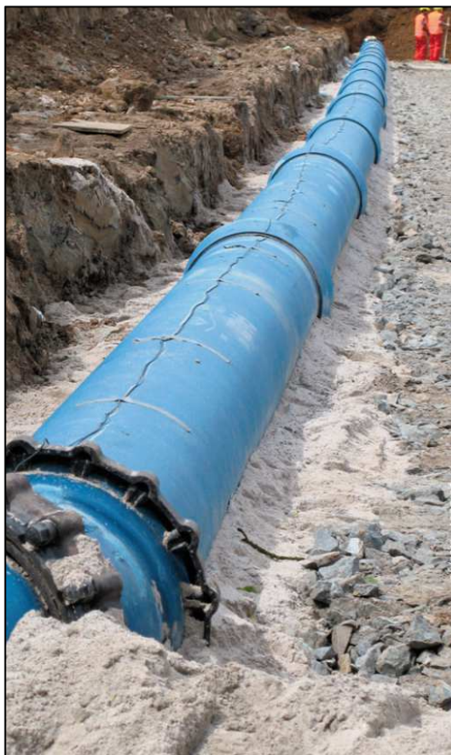
Obr. 9. Část trubního vodovodu z tvárné litiny (5)
