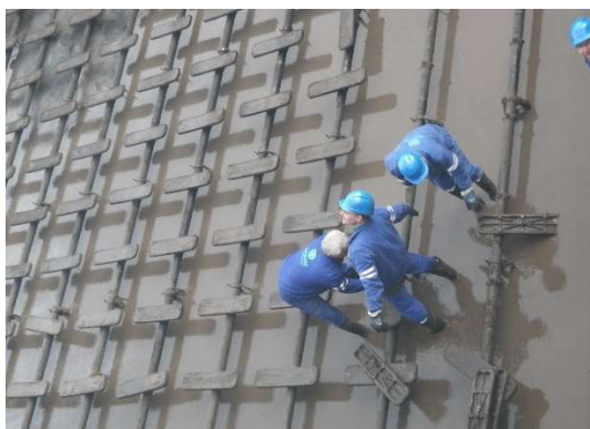
Obr. 3.18: Aerační elementy v aktivační nádrži (vlevo) a dmychadla (vpravo) [22, 29]
