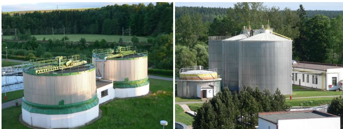
Obr. 5.11: Zahušťovací nádrže, plynojem a vyhnívací nádrže ČOV Havlíčkův Brod [22]
