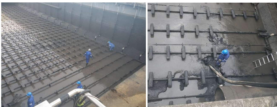
Obr. 5.14: Výměna aeračních elementů [22]
