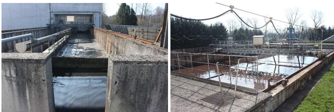
Obr. 5.7: Lapák písku a usazovací nádrž [29]
