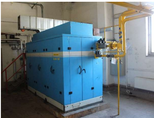
Obr. 5.13: Kogenerační jednotka a fotovoltaické panely [29]
