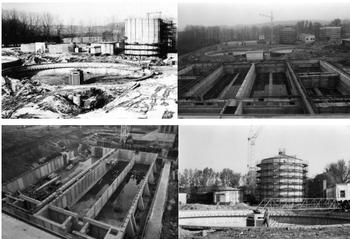
Obr. 5.3: Výstavba ČOV HB, dosazovací nádrž, aktivace a vyhnivací nádrž [22]
