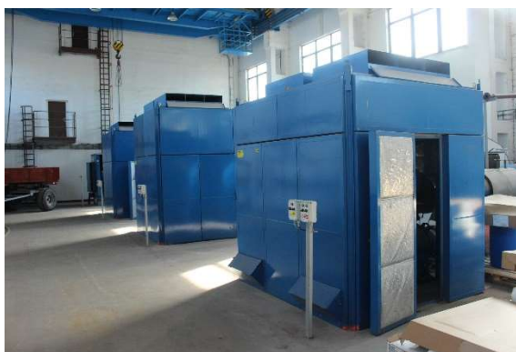
Obr. 3.18: Aerační elementy v aktivační nádrži (vlevo) a dmychadla (vpravo) [22, 29]
