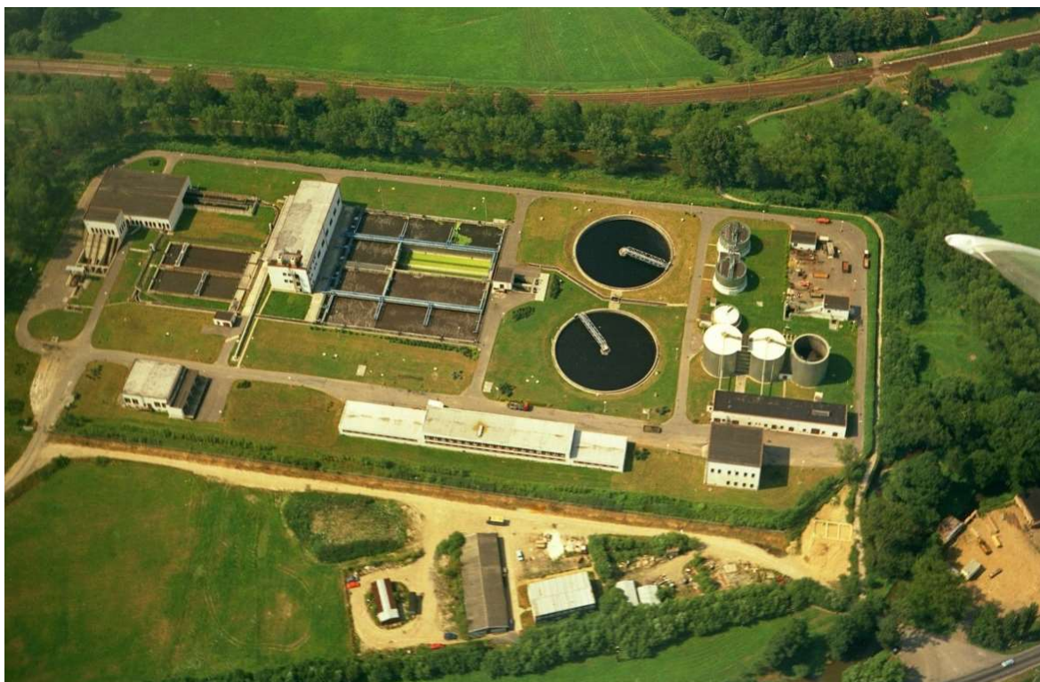
Obr. 5.2: Letecký pohled ČOV Havlíčkův Brod [22]
