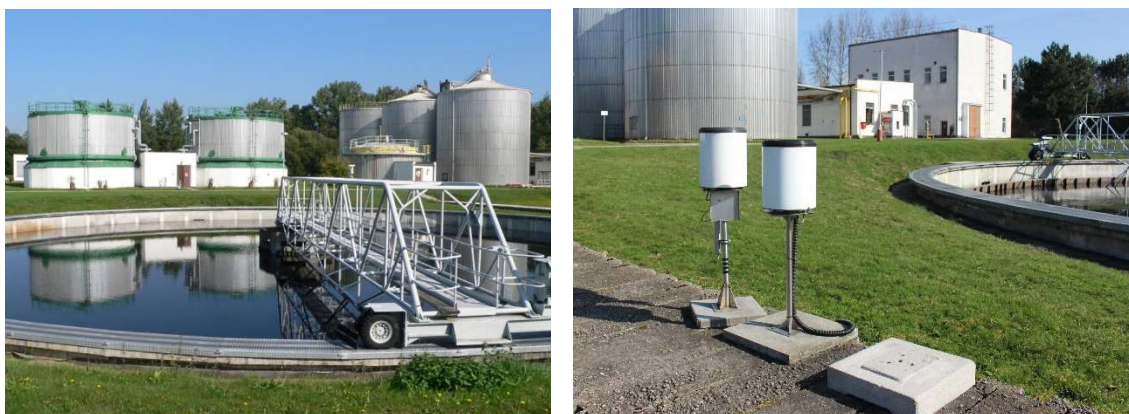
Obr. 5.10: Dasazovací nádrž a meteorologická stanice [22, 29]
