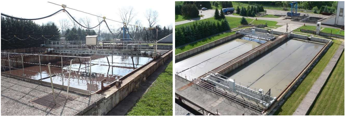
Obr. 3.10: Pravoúhlé usazovací nádrže [22, 29]
