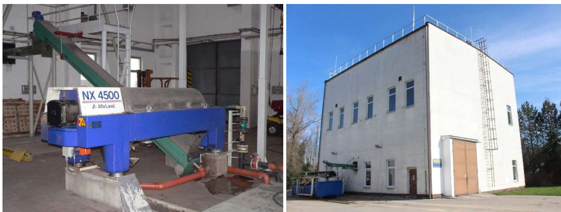
Obr. 5.12: Dekantační odstředivka a lisovna tuhých kalů s kontejnerem na kal [22, 29]
