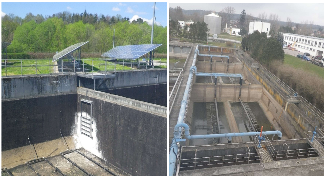
Obr. 5.15: Vybouraný otvor se stavidlem a záložní linka aktivace [22]
