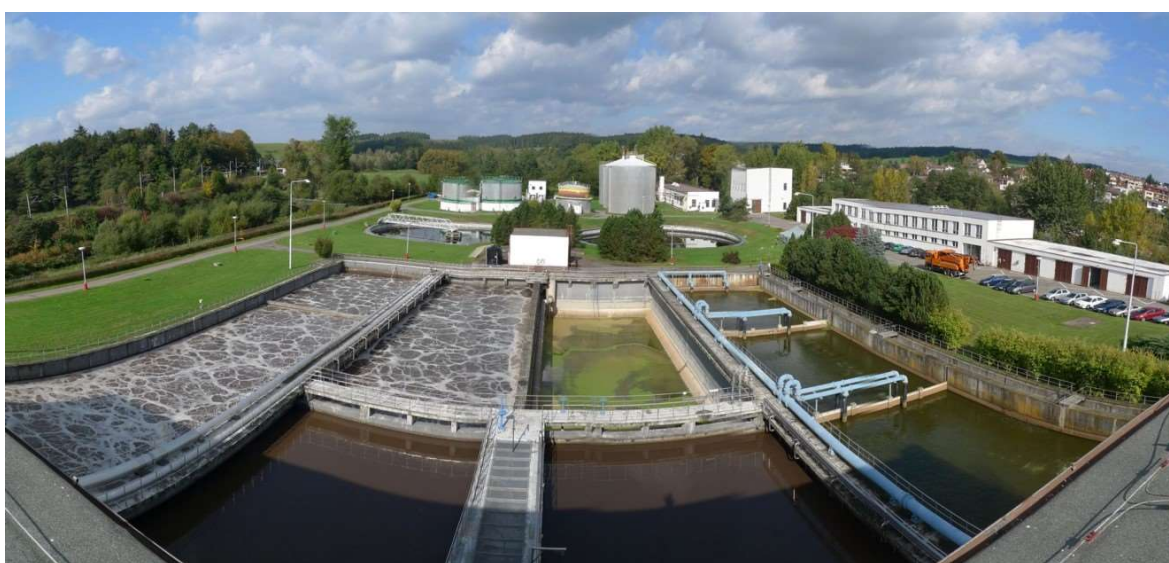
Obr. 3.15: Aktivační nádrže ČOV Havlíčkův Brod [22]
