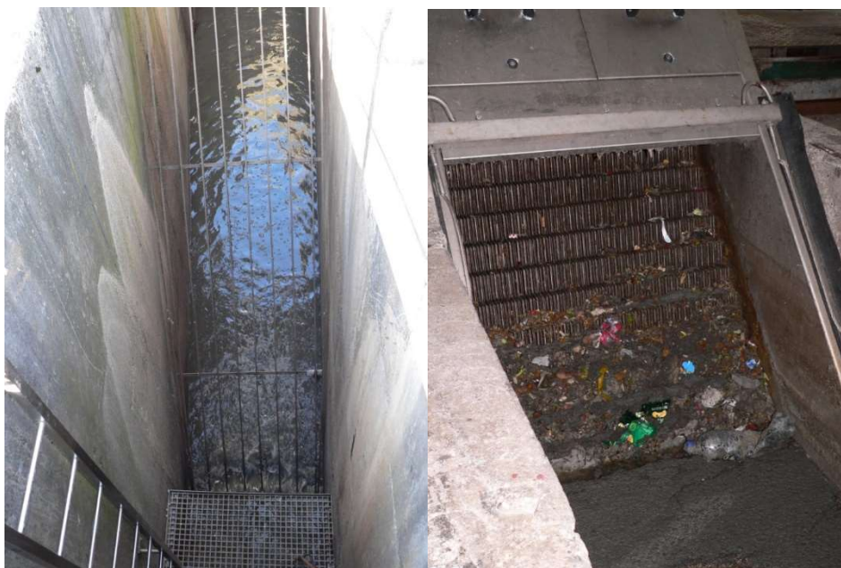
Obr. 3.3: Hrubé česle ručně stírané (vlevo) a jemné česle [22]
