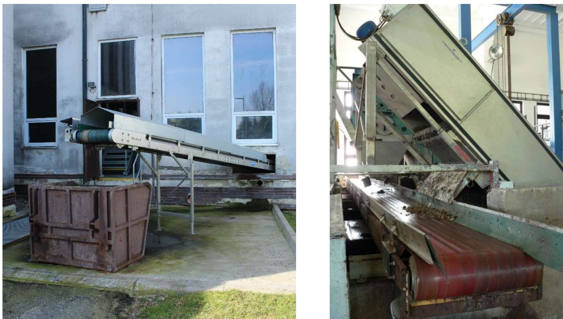
Obr. 3.5: Dopravník na shrabky (vlevo) [29] a přepad shrabků z česlí na dopravník [22]
