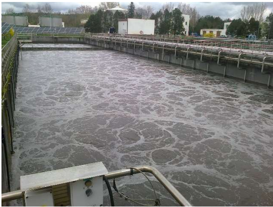
Obr. 5.9: Celkový pohled na aktivaci, nitrifikace a denitrifikace [22]
