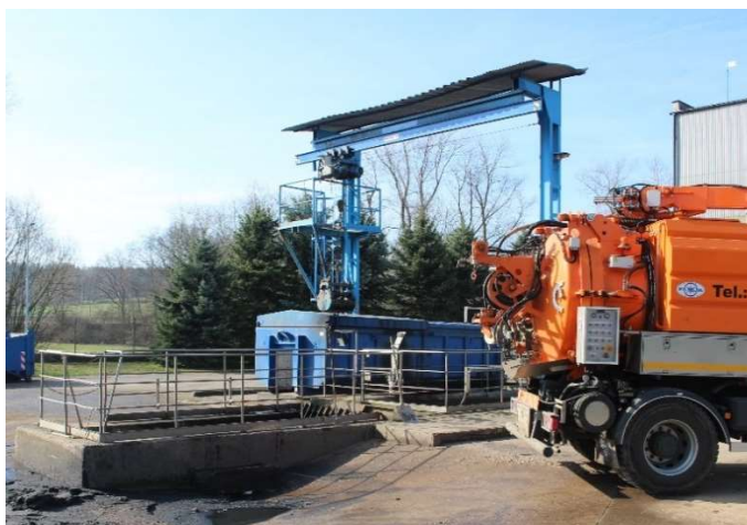
Obr. 3.2: Zařízení na těžení štěrku
