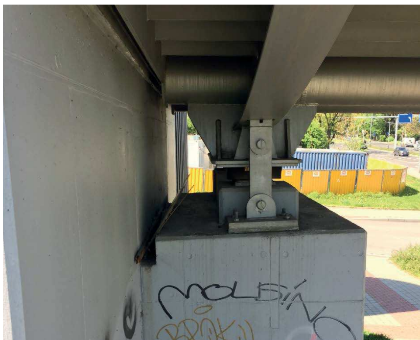
Obrázek 6: Odvodnění opěry 1
