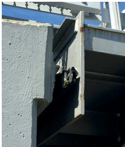
Obrázek 8: Mostní závěr na opěře 1
