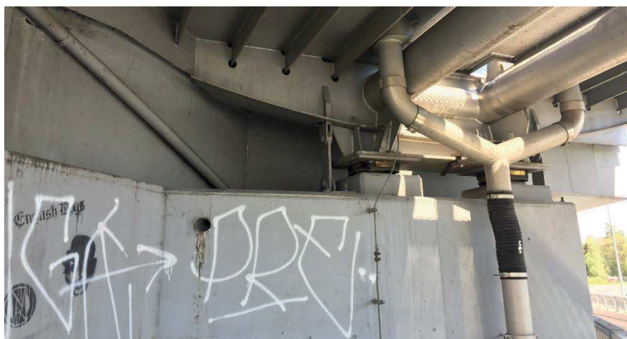
Obrázek 7: Odvodnění opěry 4
