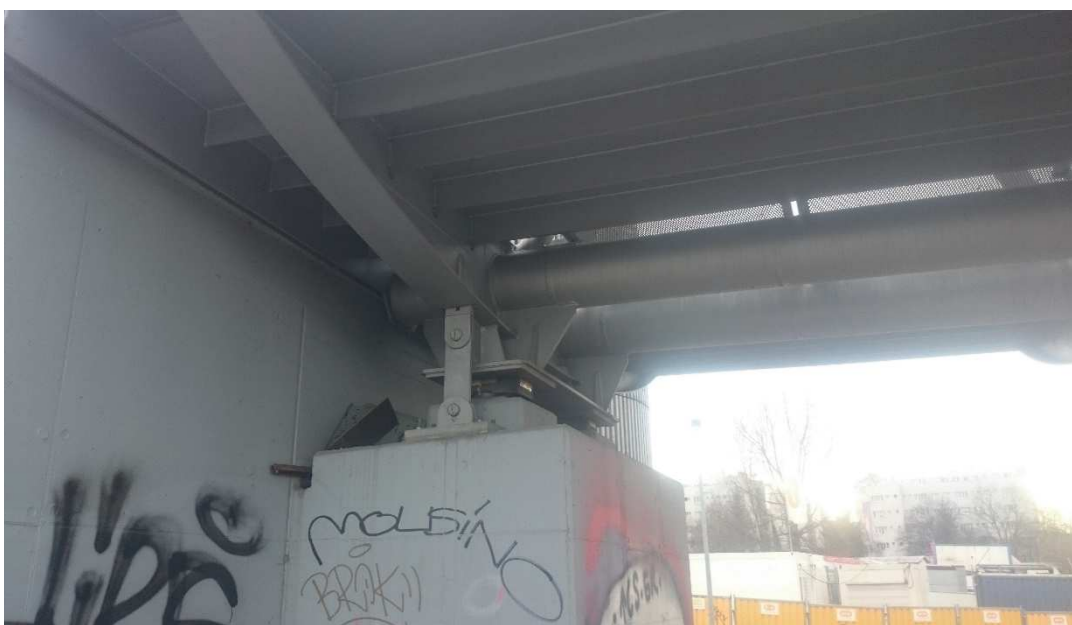
Obrázek 5: Uložení na opěře 1
