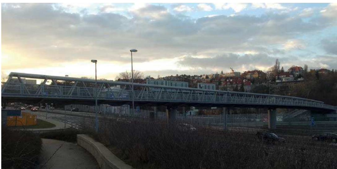
Obrázek 2: Celkový pohled na lávku
