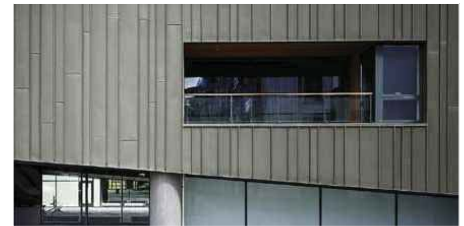
FASÁDA RHEINZINK - KOVOVÁ PŘEDSAZENÁ FASÁDA STŘEŠNÍ NÁSTAVBA A HORNÍ ČÁST BISTRA
