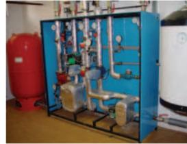
OPS TNKT sestává ze dvou sekcí - sekce vytápění (UT) a sekce ohřevu teplé vody (TV). Obě sekce jsou zapojeny paralelně. V případě požadavku je možné OPS dodat se dvěma a více regulačními okruhy UT. Technologie OPS umožňuje instalaci měřičů tepla. Standardně jsou osazovány dva měřiče - celkové spotřeby a pro UT. Na přání zákazníka mohou být měřiče osazeny pro ohřev TV a UT.
