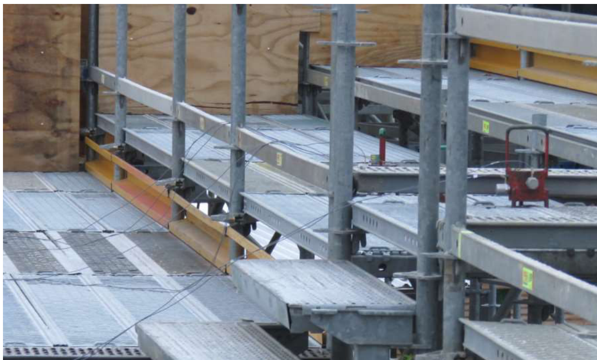
Obrázek 13 - Podlážky položeny na horizontále, připevněné pomocí speciálních svorek, ne rozet.
