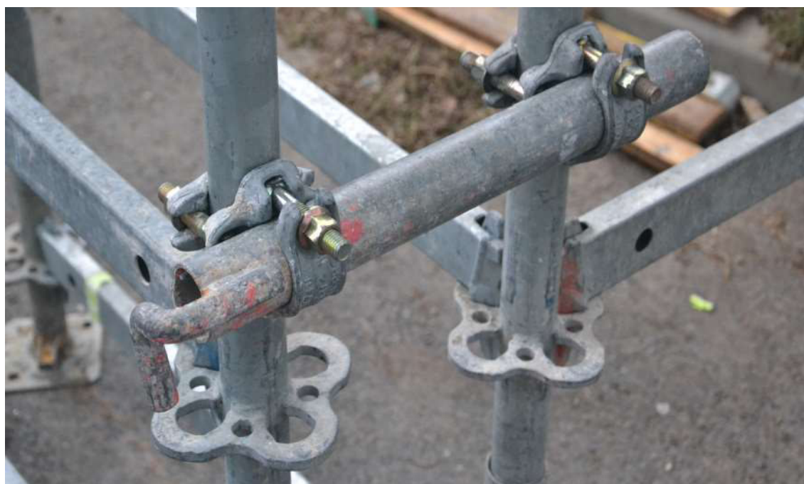
Obrázek 6 - Spojení tribuny se schodištěm pomocí ocelové trubky, ukázka rozety na sloupku
