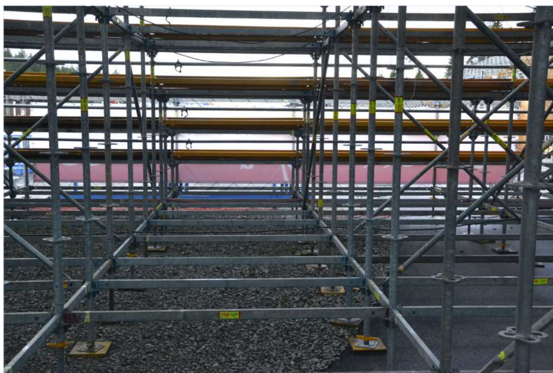
Obrázek 10 - Část bez diagonál, uložení na štěrku a asfaltu
