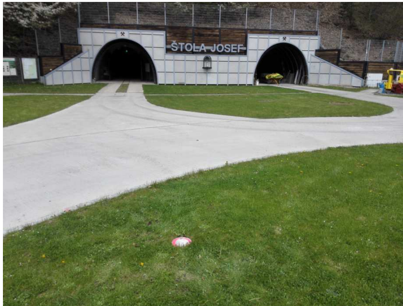
Obr. 3 – bod 501 umístěný před portálem štoly
