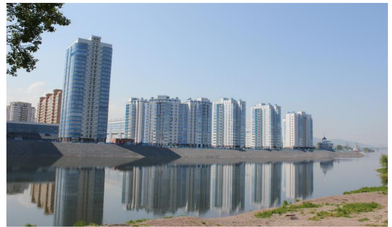
Obrázek 38 Dokončená výstavba - aktuální stav.
