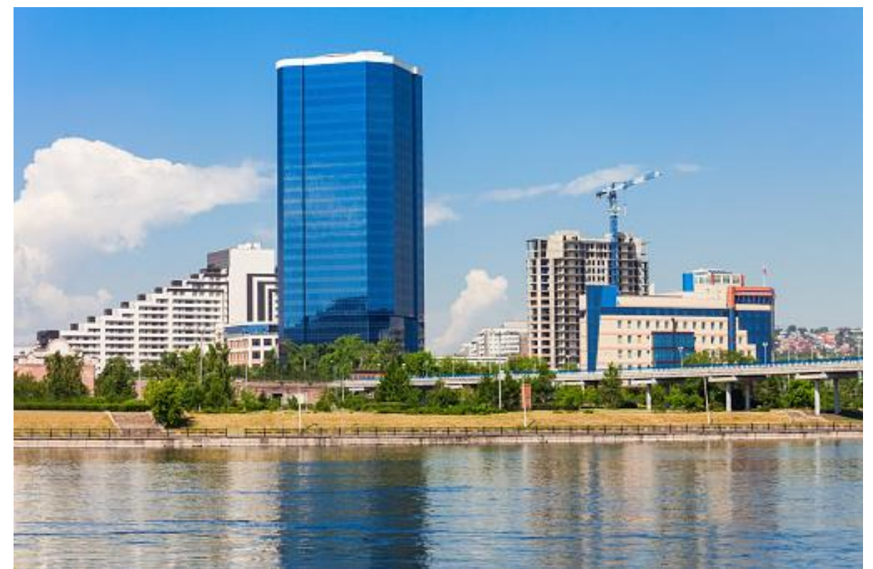
Obrázek 40 Opláštění, dle nového projektu. Současný stav, budova nevyužitá.
