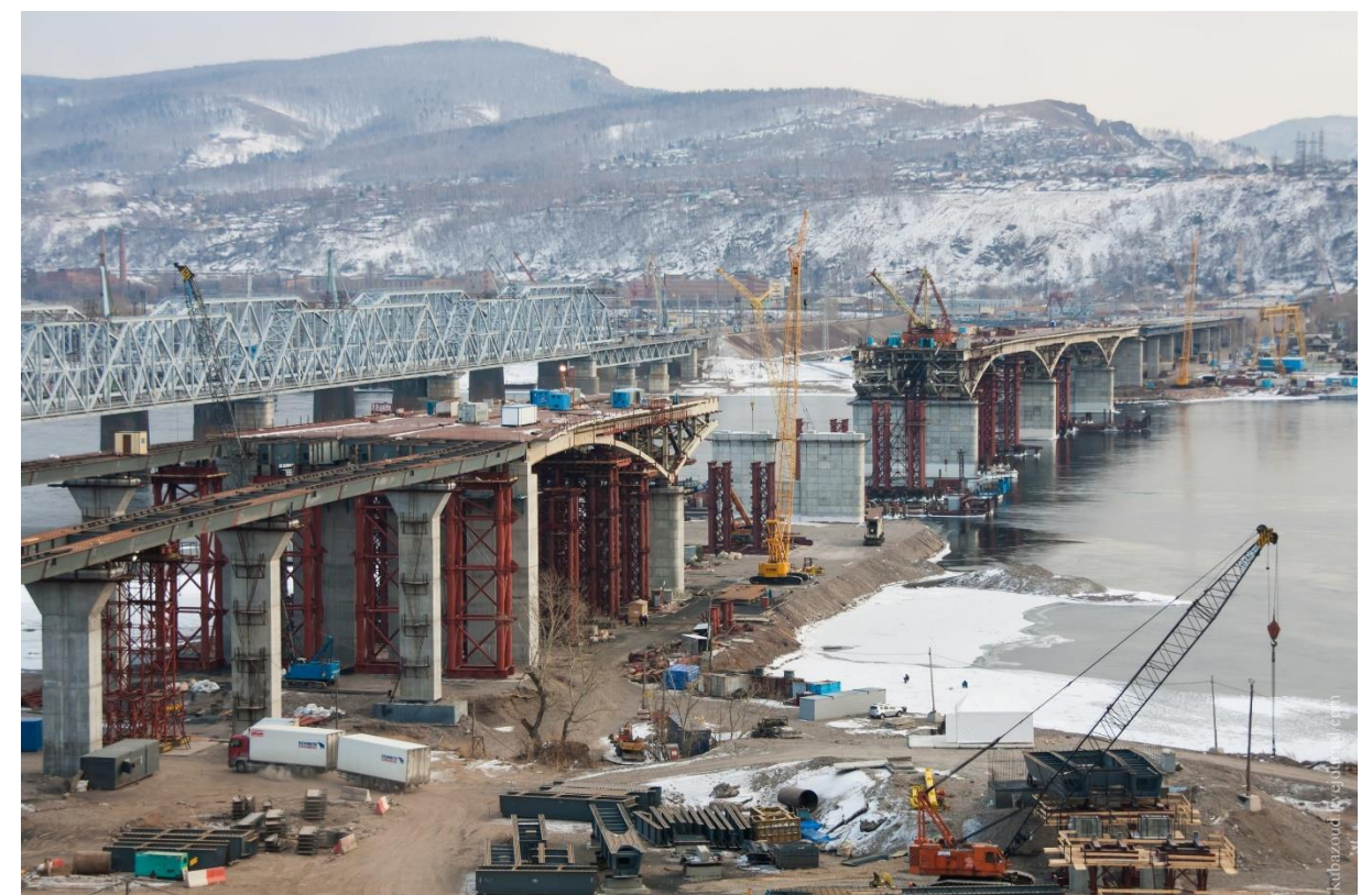
Obrázek 42 Stavba 4. mostu za 12 mld. rublů. Staví se nepřetržitě v létě i v zimě.
