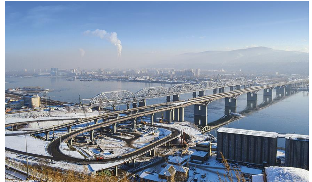
Obrázek 41 Aktuální stav dostavěného 4. mostu.
