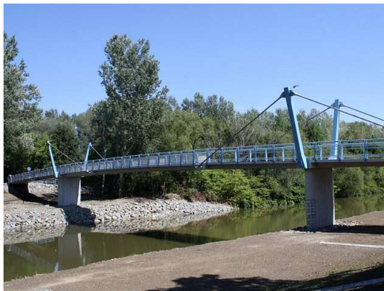
Obrázek 1: Pohled na lávku z pravého břehu [11]
