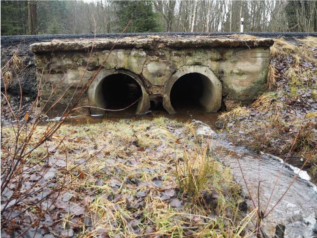
Obrázek 8: Pohled na propustek pod komunikací
