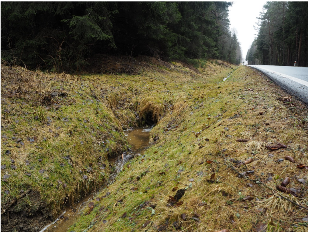
Obrázek 9: Pohled na možný vjezd na pozemek, přímo k budoucí hrázi
