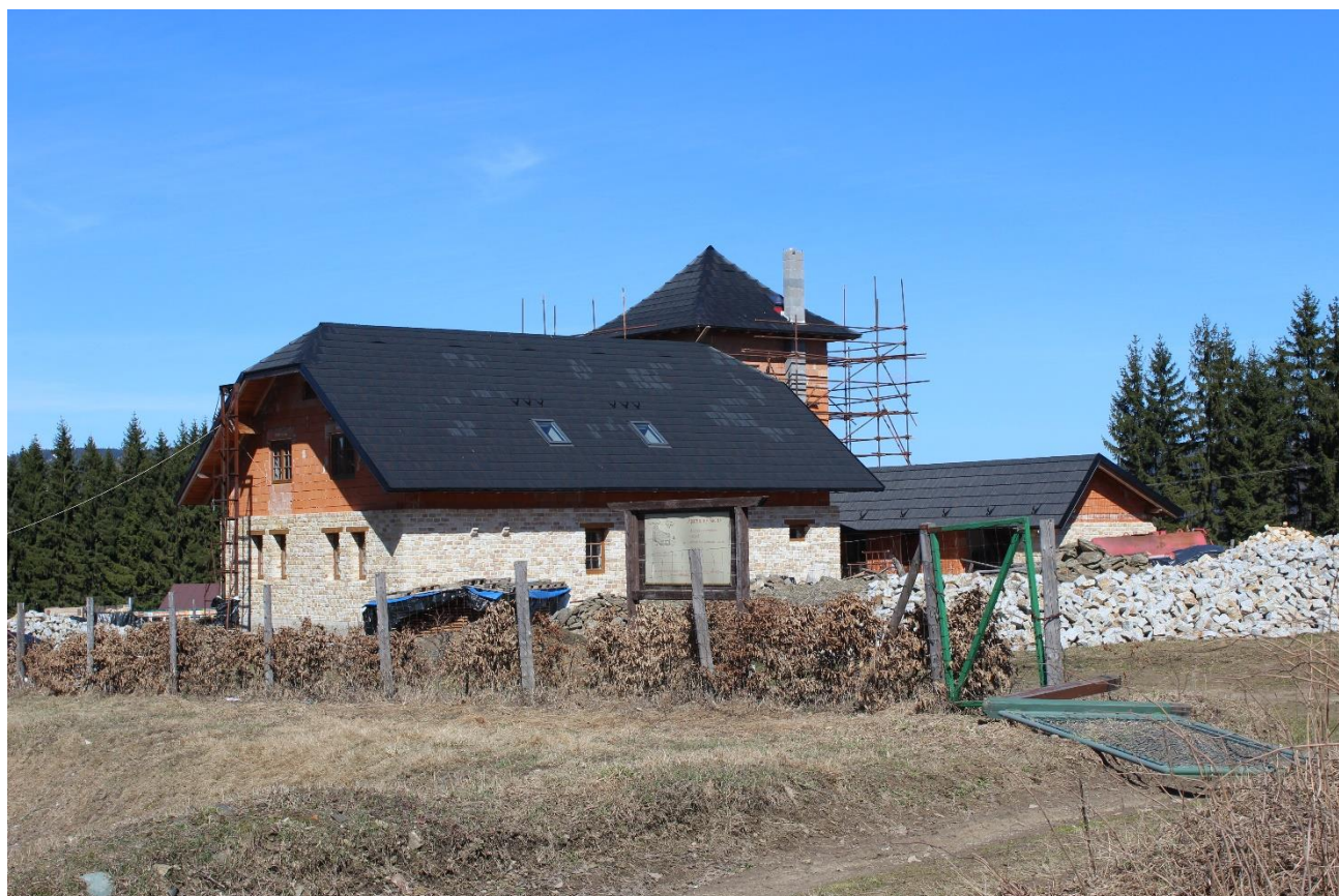
Obrázek č.16 – Hrubá stavba na louce u parkoviště skiareálu Šachty
