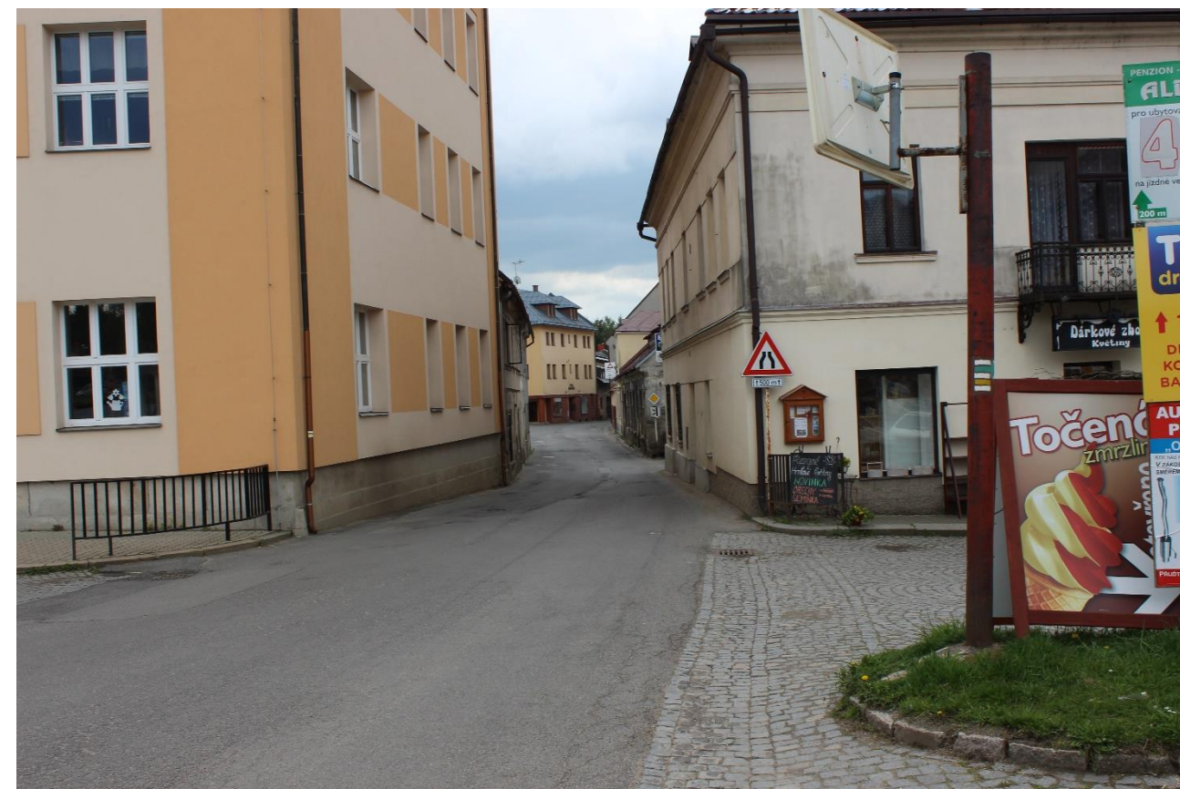
Obrázek č.17 – Silnice II/290 a její zúžení v centru obce, dopravní zrcadlo zajišťující přehlednost křižovatky
