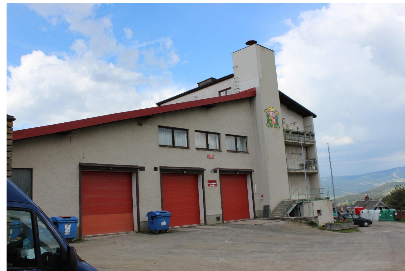
Obrázek č.13 – Hasičská zbrojnice Vysoké nad Jizerou
