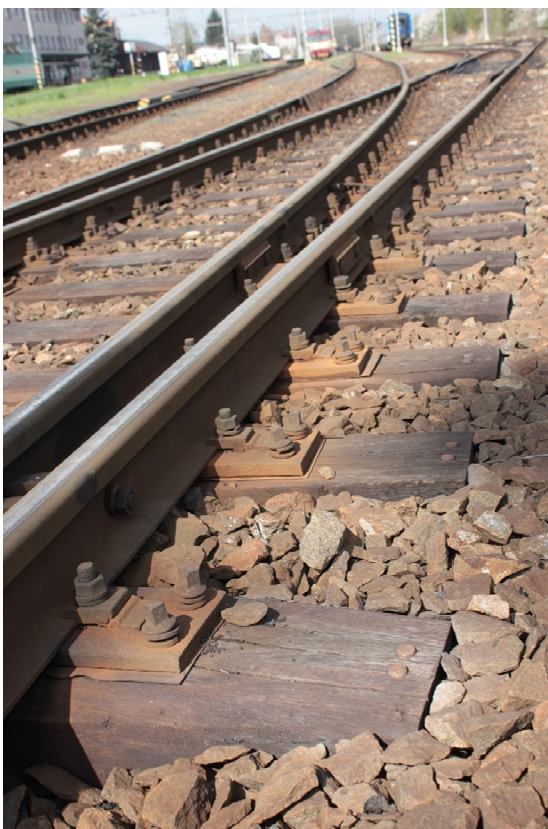
Obr. 20: Detail upevnění výhybky
