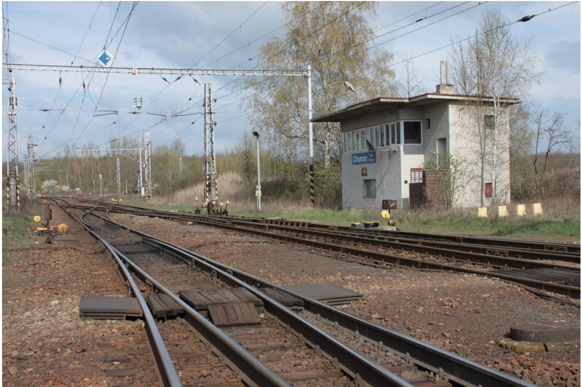
Obr. 9: Pohled ve směru Velký Osek/Městec Králové - stavědlo St.2 a v pozadí dvojitá kolejová spojka
