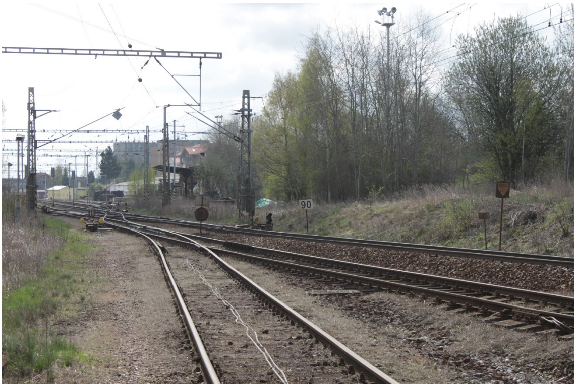
Obr. 13: Pohled z koleje č. 102 směrem do stanice
