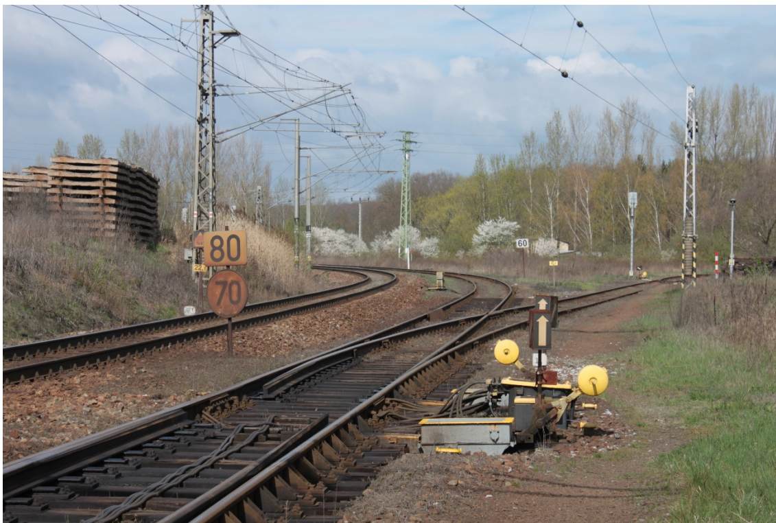
Obr. 11: Pohled z výhybky č. 37 směrem do trati
