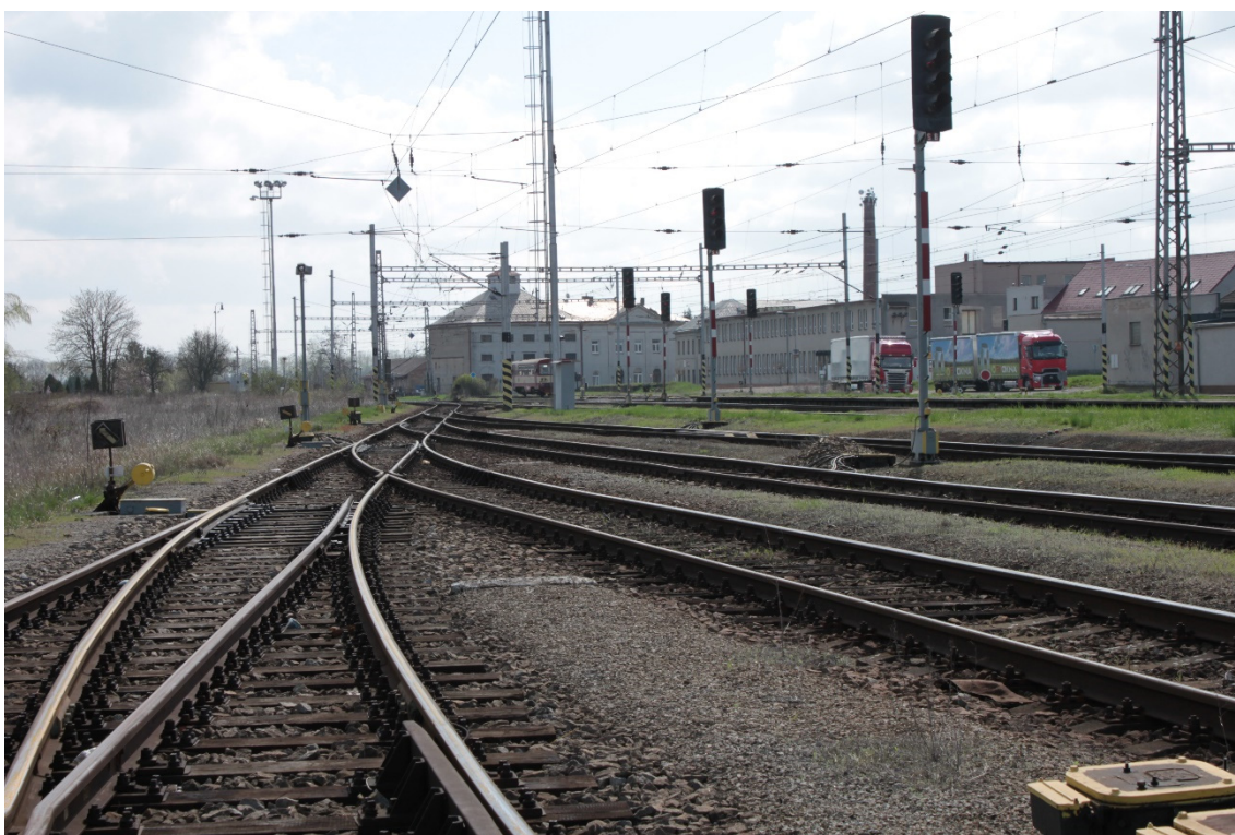
Obr. 18: Královéhradecké zhlaví, pohled směrem ze stanice
