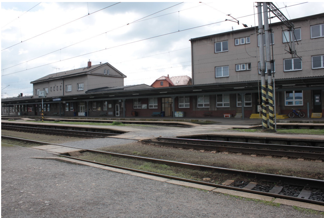
Obr. 34: Úrovňový přechod před výpravní budovou, nástupiště č. 4 (kolej č. 4) s obrubníkem
