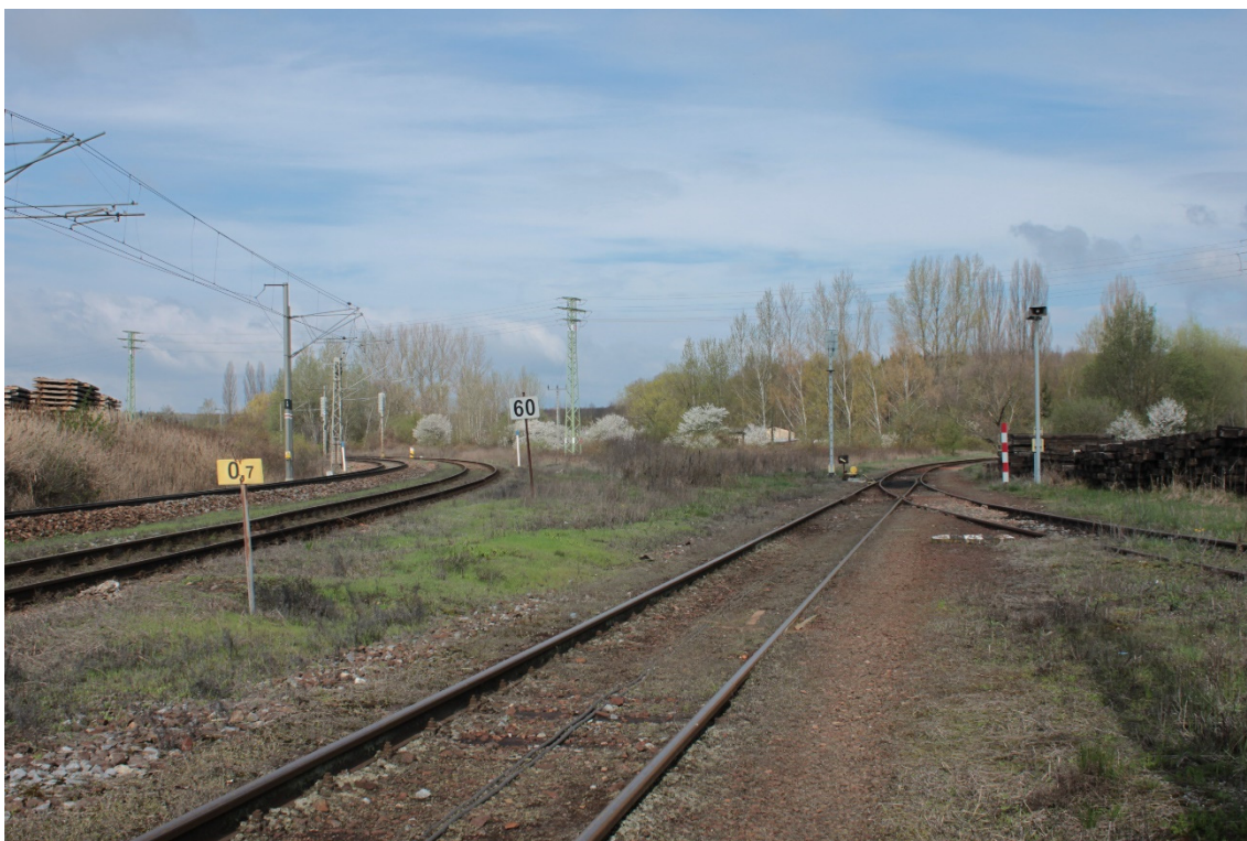
Obr. 12: (Zleva) Trať směr Velký Osek, trať směr Městec Králové, kolej č. 102, pokračující dále jako vlečka č. V4224 a odvratná kolej č. 102a napojená výhybkou O1
