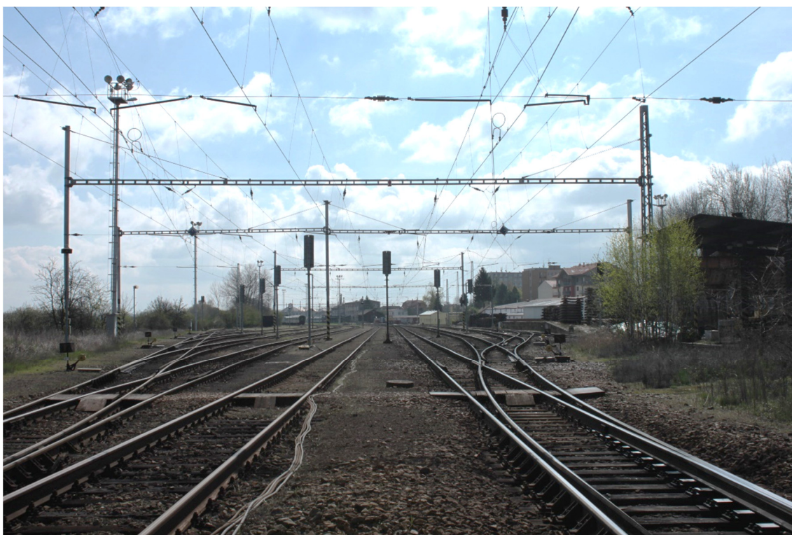
Obr. 16: Osecké zhlaví, pohled směrem do stanice
