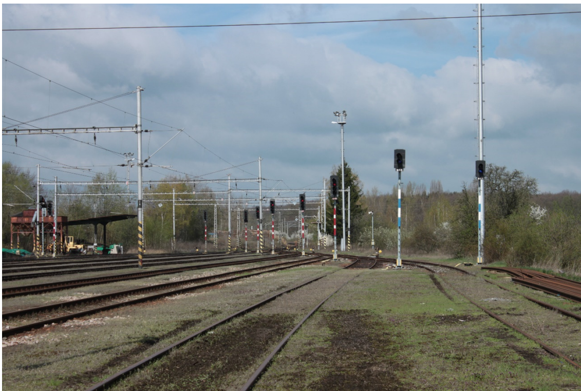
Obr. 17: Pohled na osecké zhlaví z manipulačních kolejí
