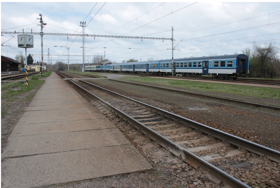
Obr. 31: Nástupiště č. 3 (kolej č. 3), konstrukce Tischer
