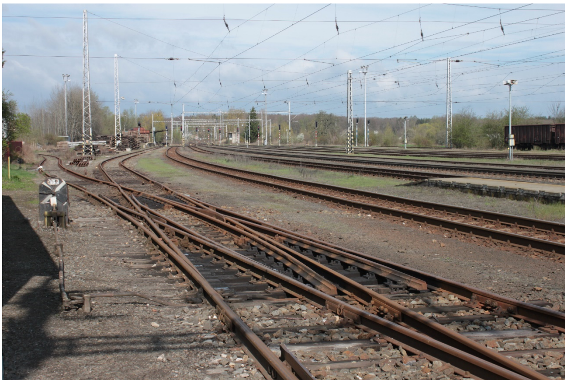
Obr. 3: Křižovatková výhybka č. 19, pohled proti směru staničení. Doleva odbočuje vlečka č. 4223
