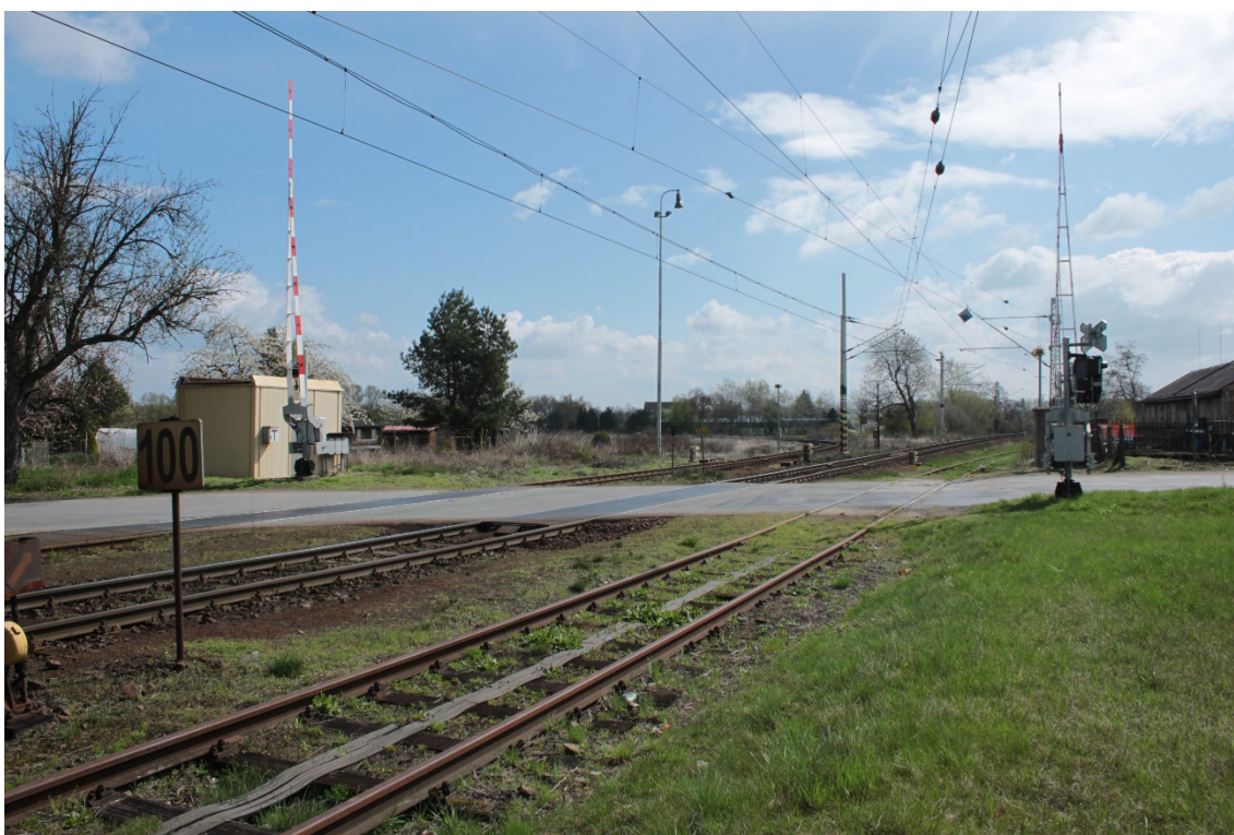
Obr. 23: Železniční přejezd P3980
