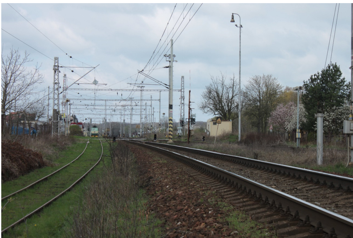
Obr. 27: Pohled z trati směrem ke stanici
