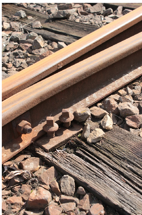
Obr. 4: Detail přímého upevnění na dřevěných výhybkových pražcích
