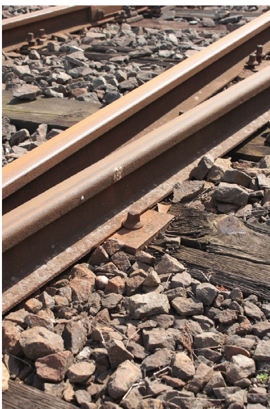
Obr. 4: Detail přímého upevnění na dřevěných výhybkových pražcích
