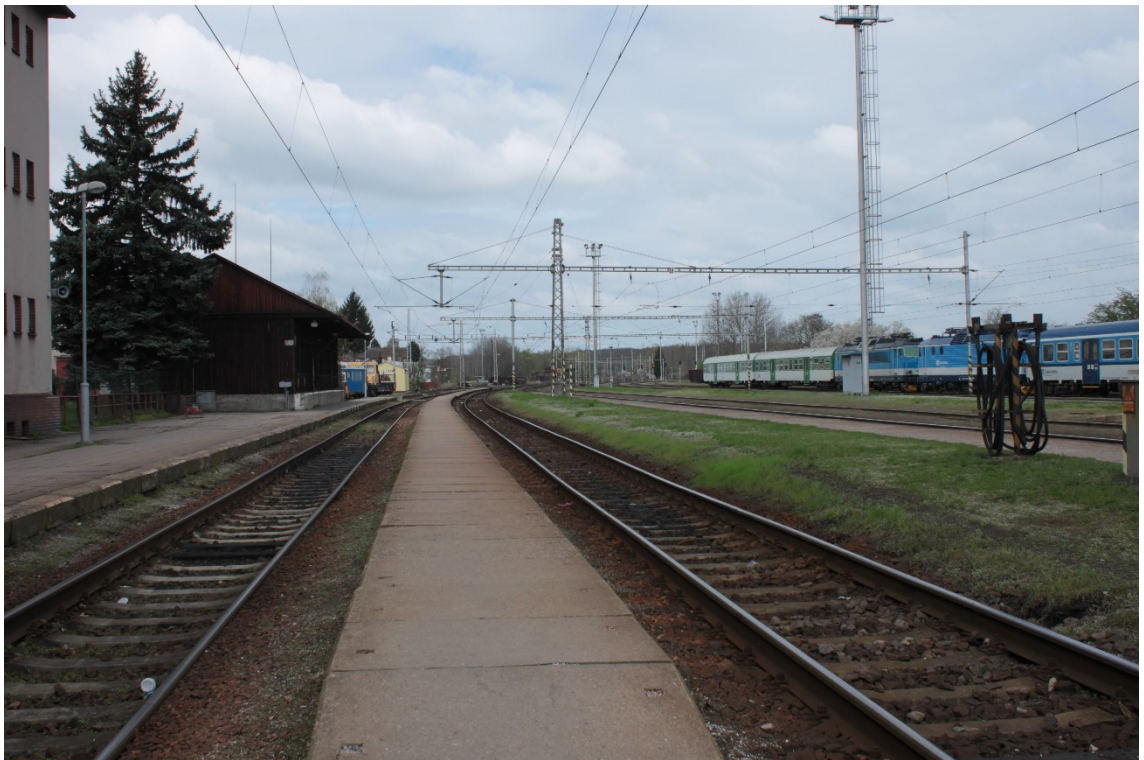
Obr. 37: Pohled z nástupiště č. 3, vlevo kolej č. 5, vpravo kolej č. 3
