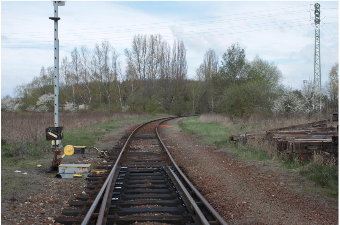
Obr. 14: Výměnový styk výhybky 01 a pohled směrem do vlečky
