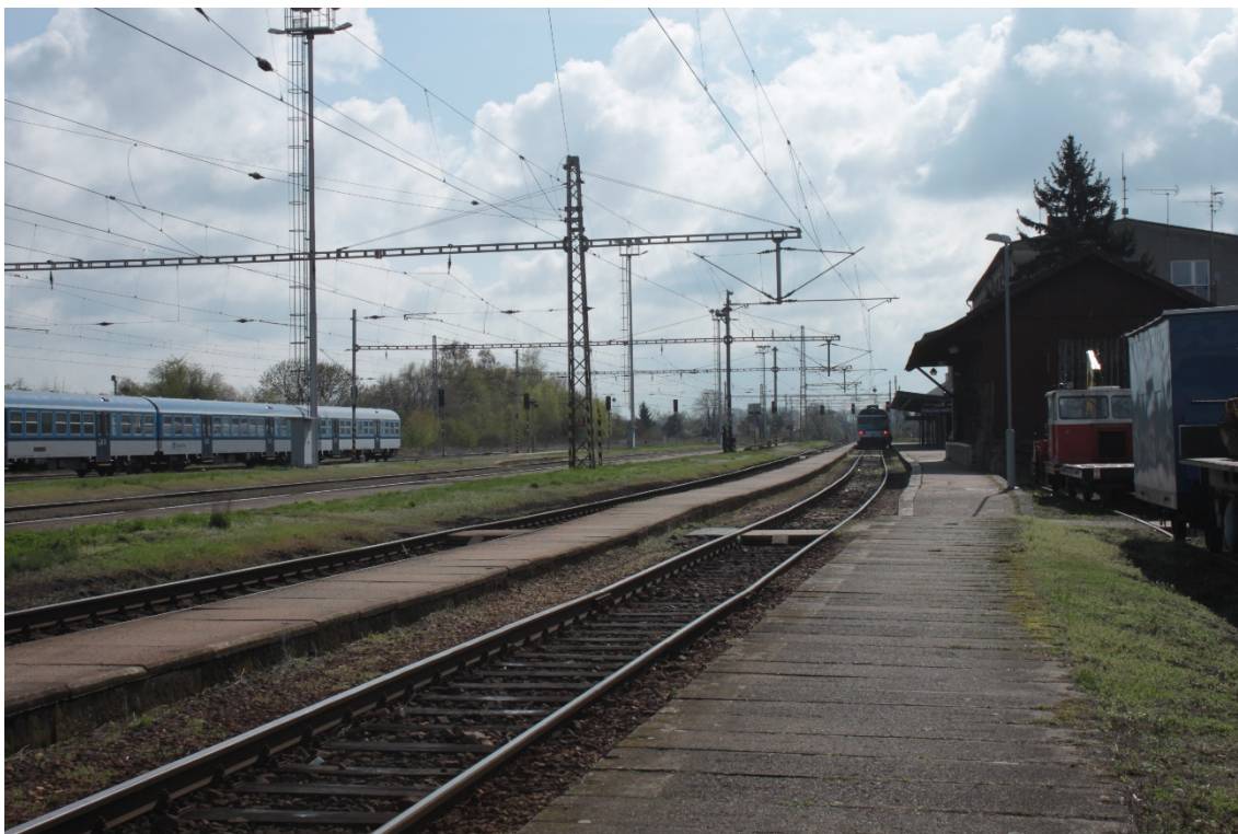
Obr. 1: Východní část nástupiště č. 5, pohled směrem do stanice
