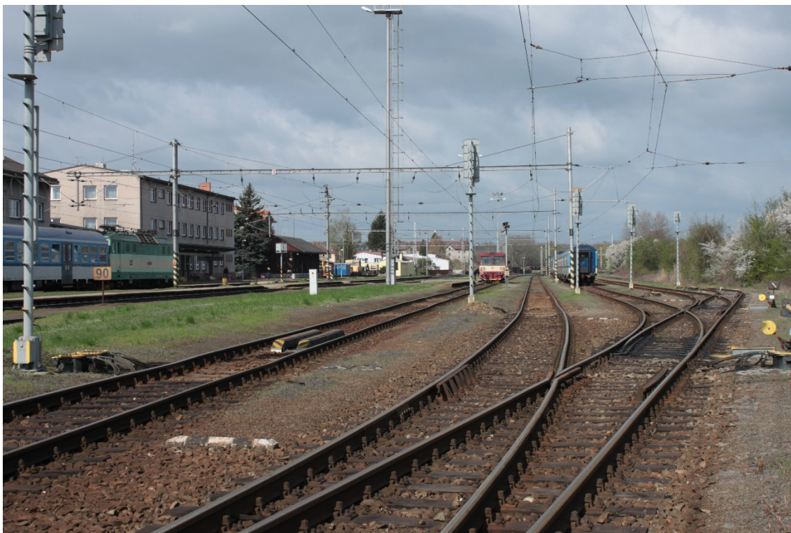
Obr. 19: Pohled z výhybky č. 12 směrem do stanice
