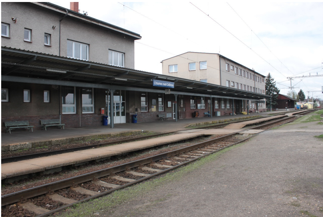
Obr. 30: Výpravní budova, před ní nástupiště č. 5 (kolej č. 5) konstrukce Tischer, v pozadí úrovňový přechod z panelů
