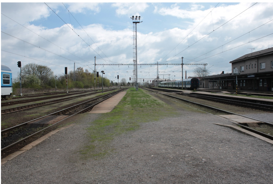
Obr. 35: Osobá vzdálenost 9,500 m mezi kolejemi č. 2 a 4 - prostor pro budoucí ostrovní nástupiště
