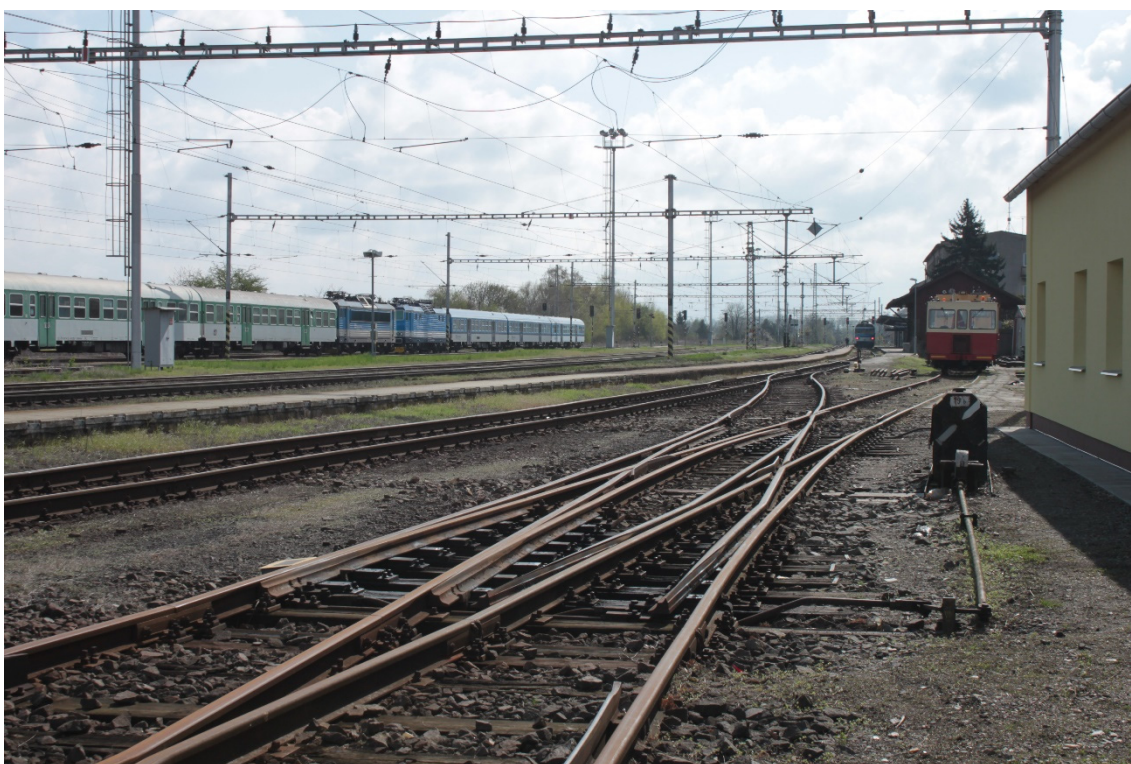
Obr. 2: Křižovatková výhybka č. 19, pohled ve směru staničení
