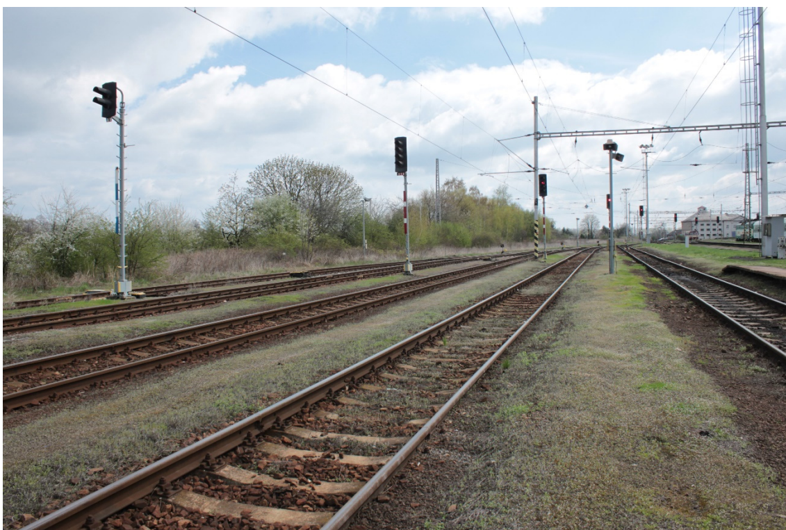
Obr. 33: Pohled do předjízdých a manipulačních kolejí
