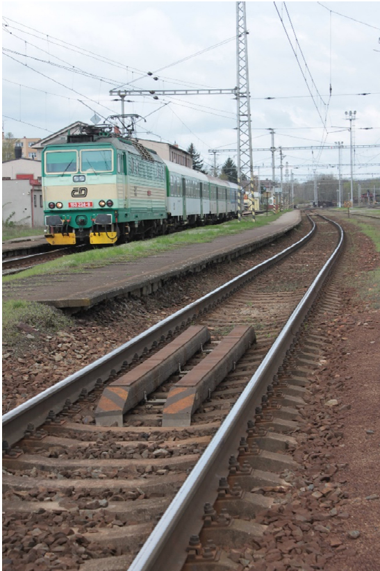
Obr. 29: Nástupiště č. 1 (kolej č. 1), konstrukce Tischer
