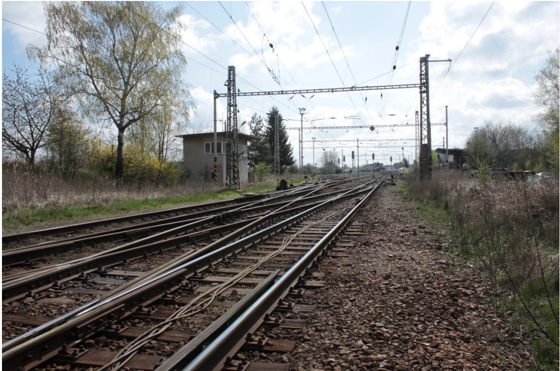
Obr. 10: Dvojitá kolejová spojka č. 805, pohled směrem do stanice
