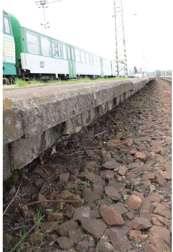
Obr. 29: Nástupiště č. 1 (kolej č. 1), konstrukce Tischer
