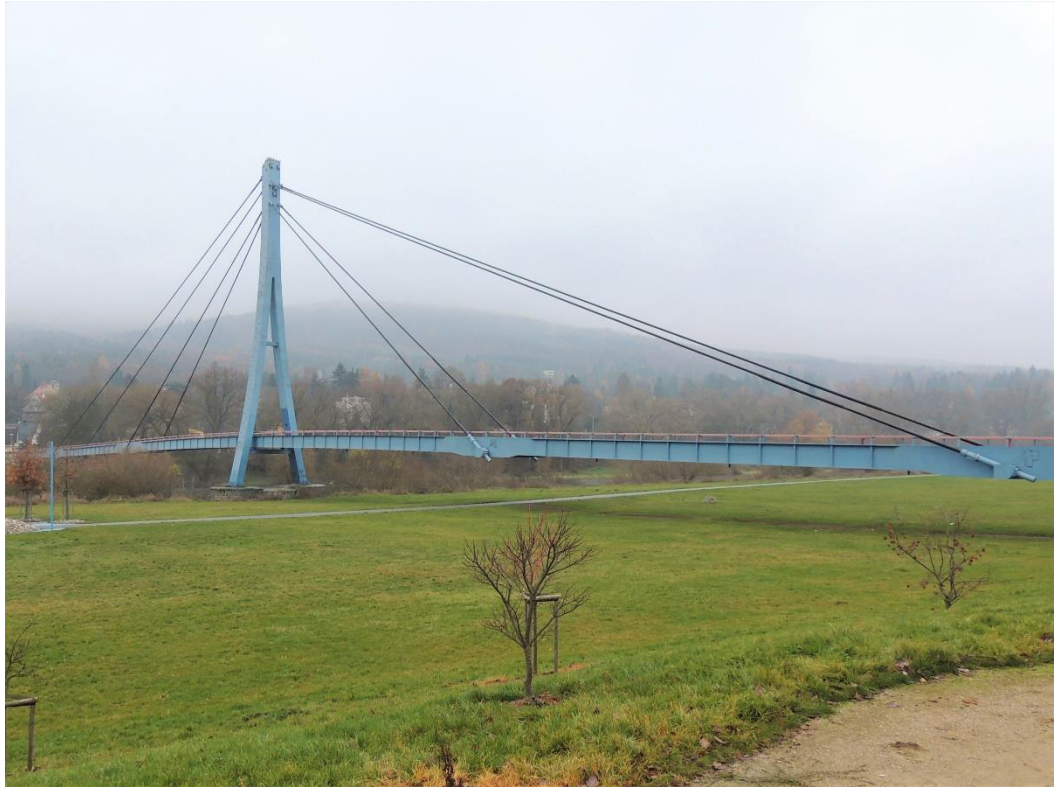
Obr. 3.1 Pohled na lávku z levého břehu řeky
