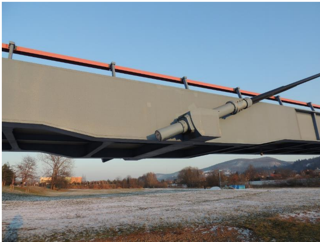
Obr. 14 Navýšení hlavních nosníků v oblasti ukotvení závěsů
