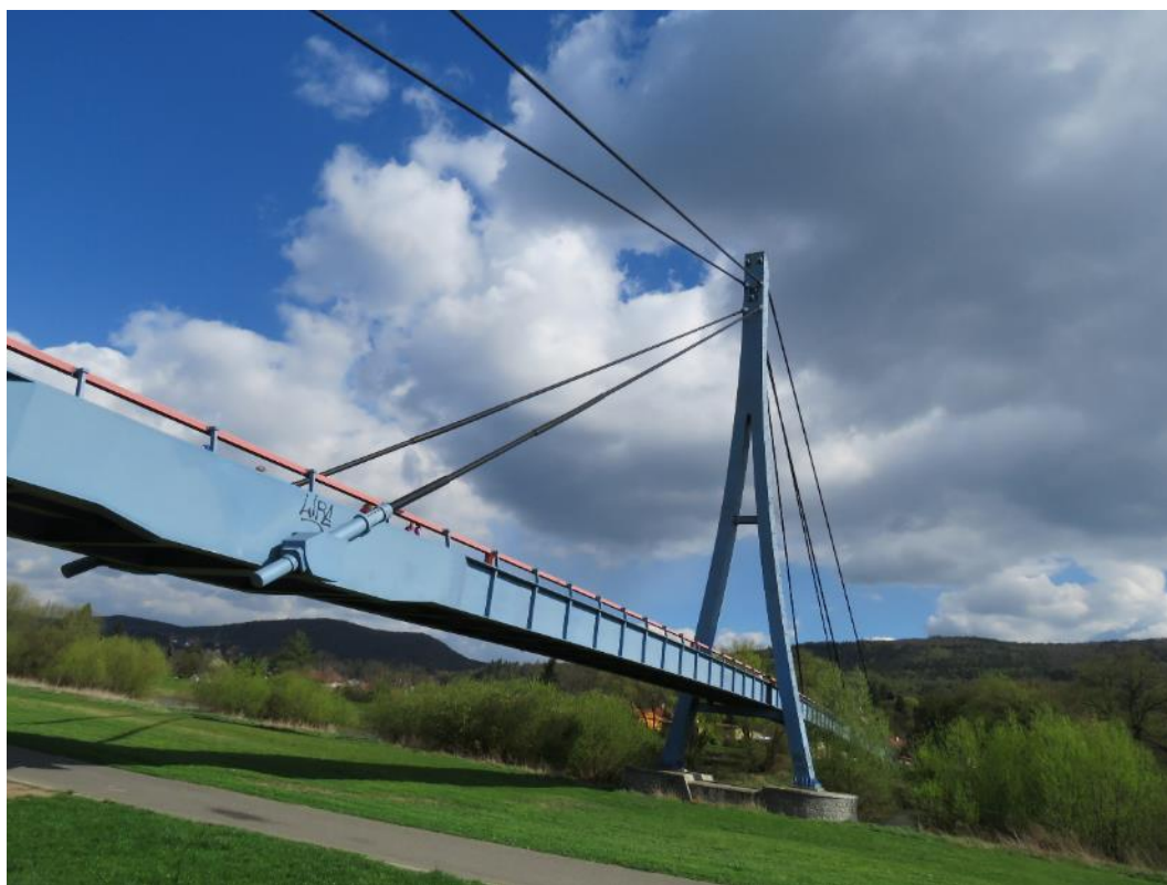
Obr. 13 Boční pohled na lávku
