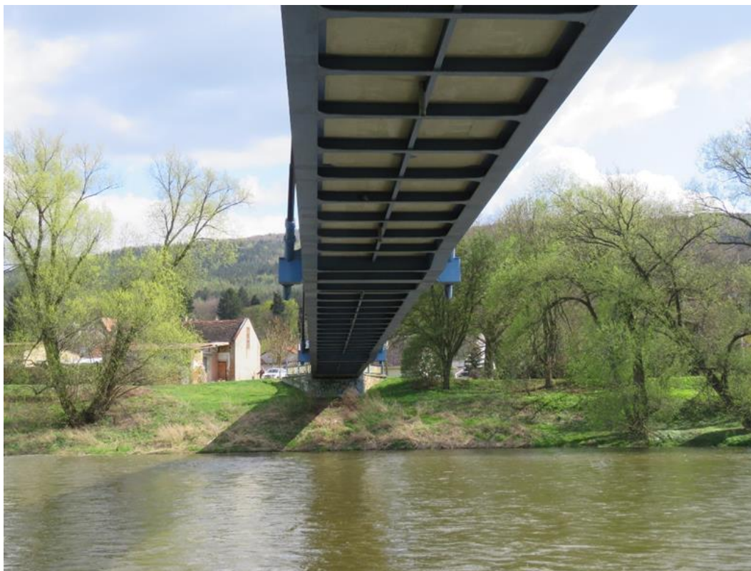
Obr. 12 Spodní pohled na nosnou konstrukci
