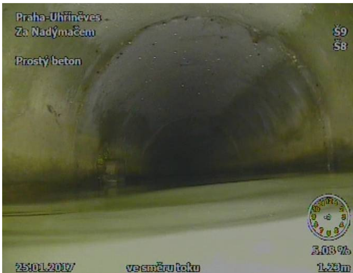
Obr. 63 Začátek úseku ve směru toku a kanalizační přípojka
