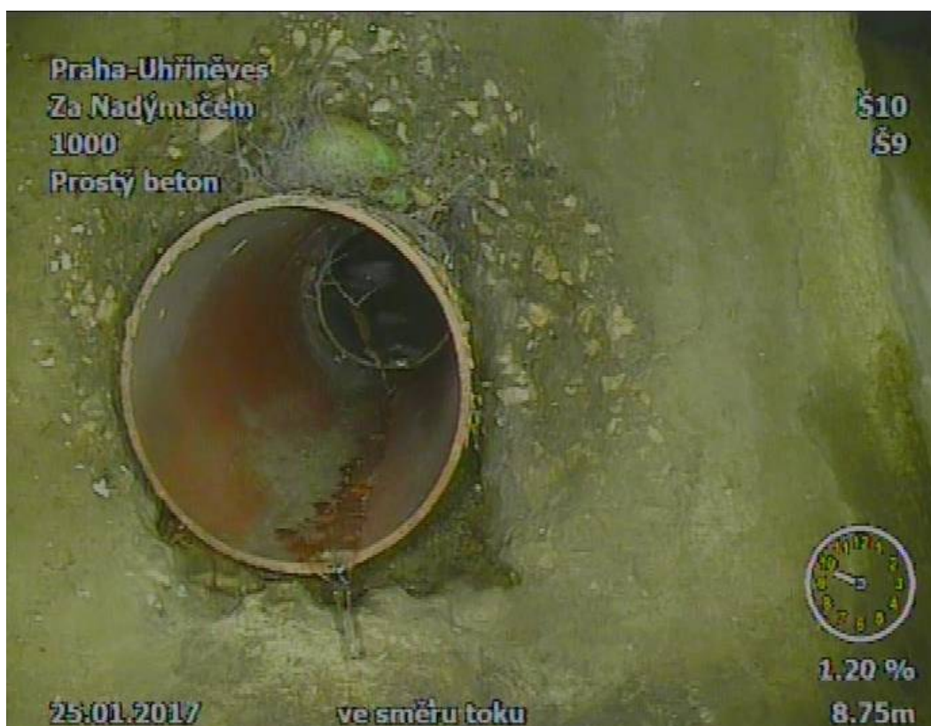
Obr. 58 Detail kanalizační přípojky 5
