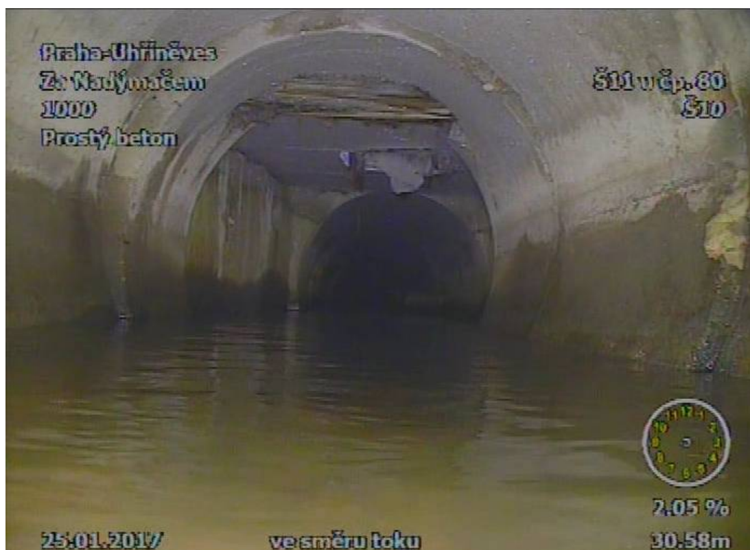
Obr. 51 Pohled na uliční vpust šachty Š10
