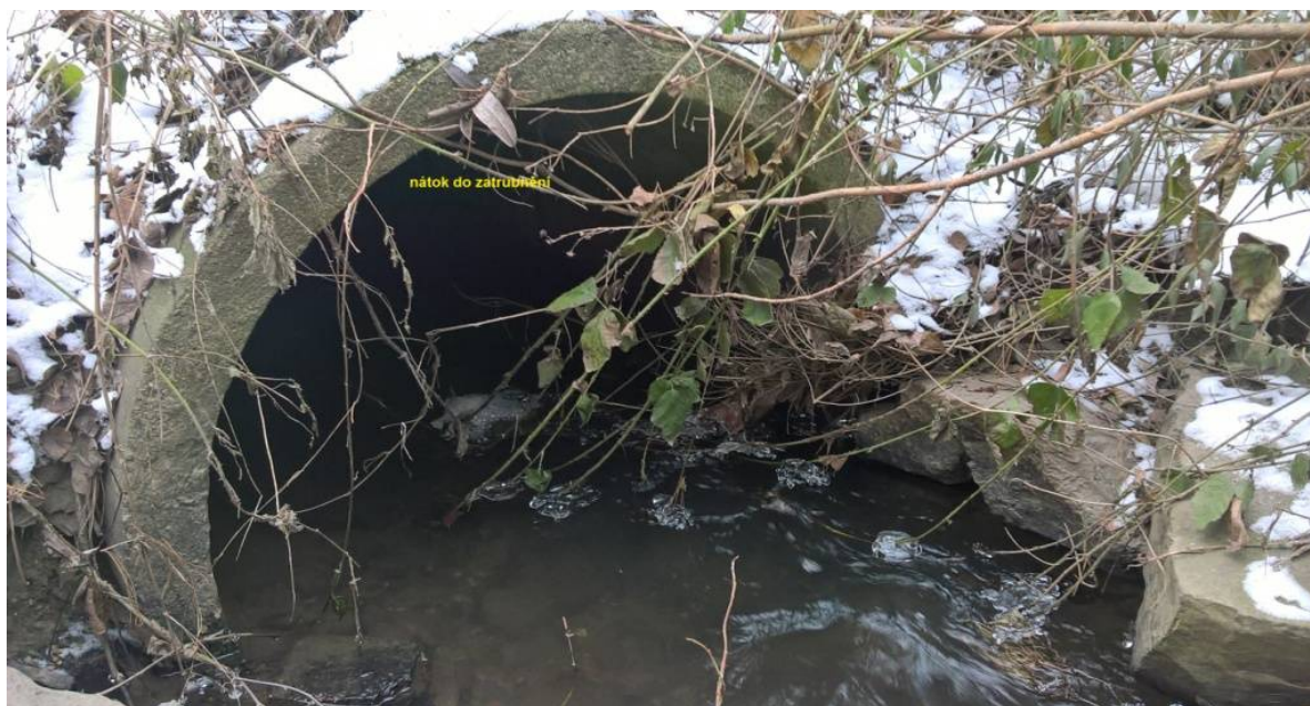
Obr. 22 Nátok do zatrubnění
