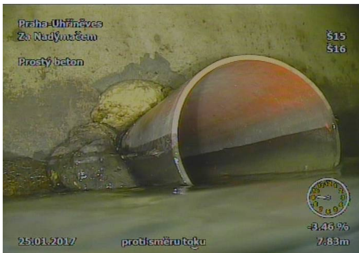
Obr. 27 Vrtaná kanalizační přípojka PVC DN 150
