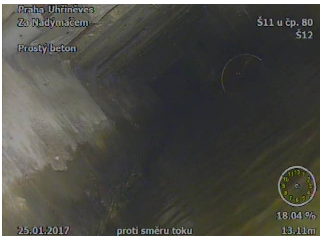
Obr. 43 Obdélníkový profil + neidentifikovatelný objekt na dně
