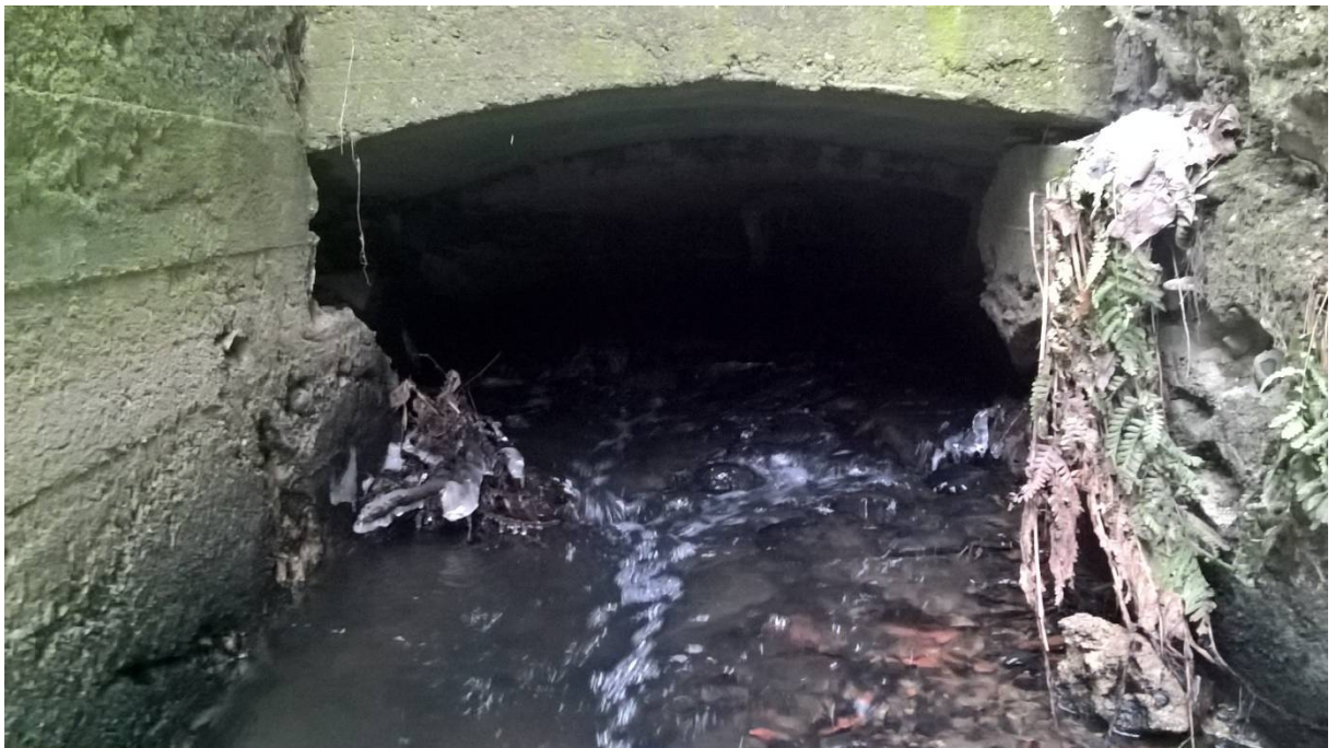
Obr. 24 Výtok do ŽB žlabu
