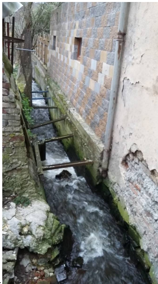
Obr. 17 Otevřené koryto za zatrubněním
