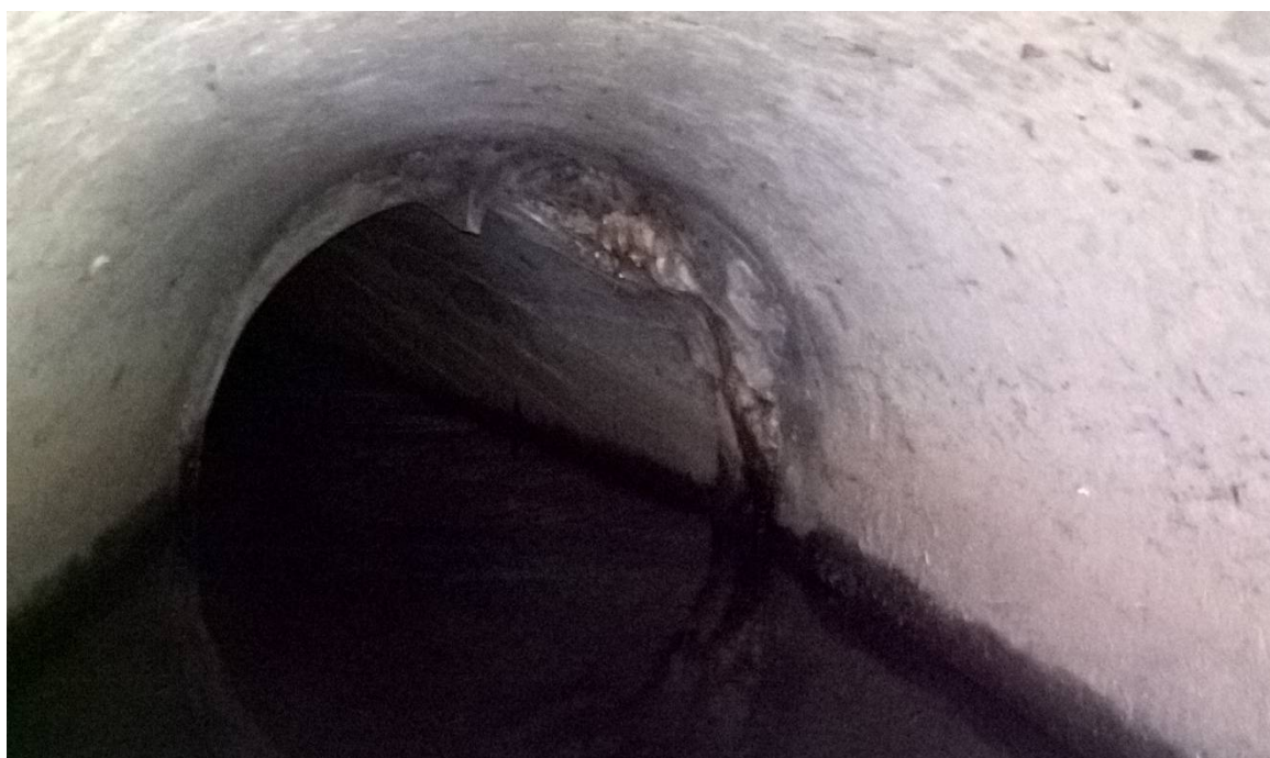
Obr. 64 Pohled do výtokového objektu
