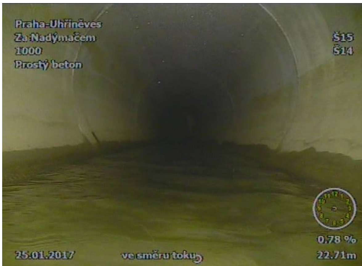
Obr. 31 Pohled po směru toku
