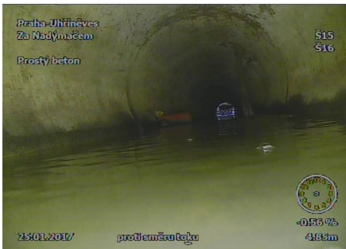
Obr. 26 Pohled proti vodě směrem k ŽB žlabu
