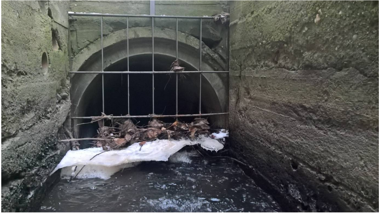
Obr. 30 Železobetonový žlab zakončený česlemi
