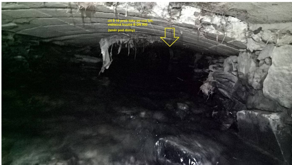
Obr. 25 Pohled z ŽB žlabu proti vodě
