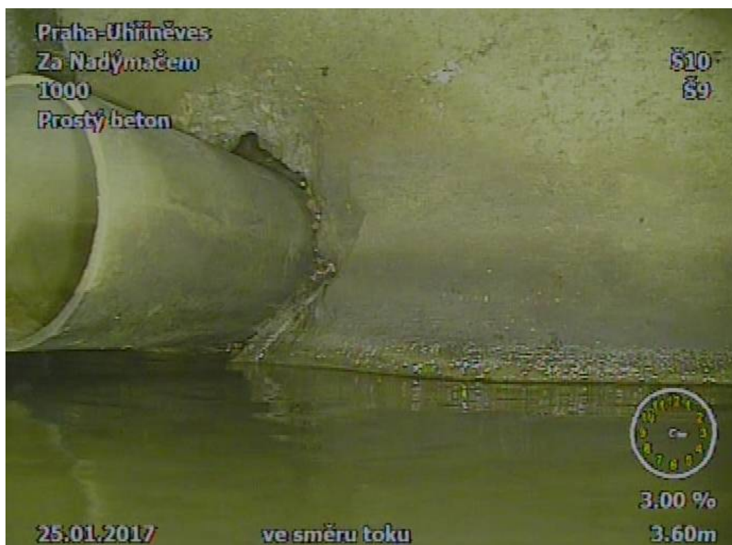
Obr. 57 Detail kanalizační přípojky 4
