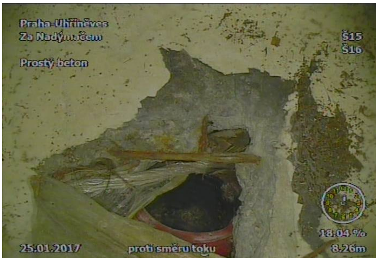
Obr. 28 Sekaná kanalizační přípojka
