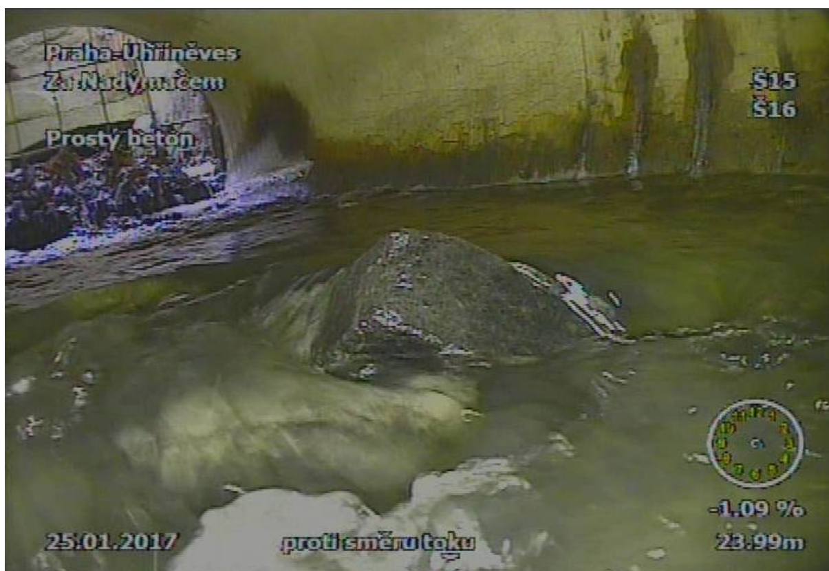
Obr. 29 Překážka z cihel a dalších zdících prvků
