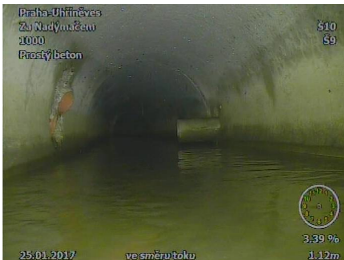
Obr. 55 Kanalizační přípojky 2,3 a 4
