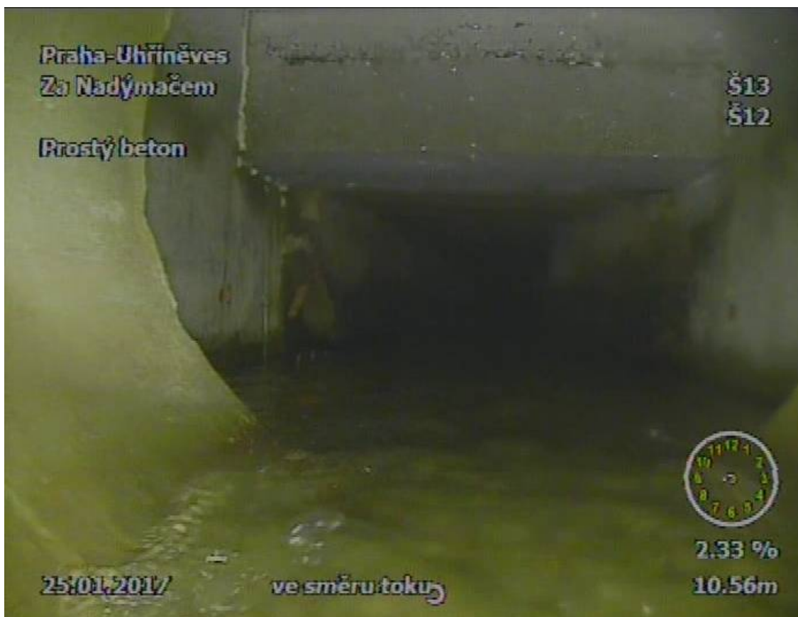
Obr. 37 Přejít rekonstruované kruhové části na stávající obdélníkovou
