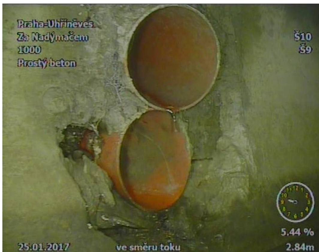
Obr. 56 Detail kanalizační přípojky 2 a 3
