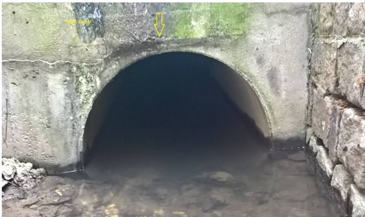
Obr. 65 Konec zatrubnění
