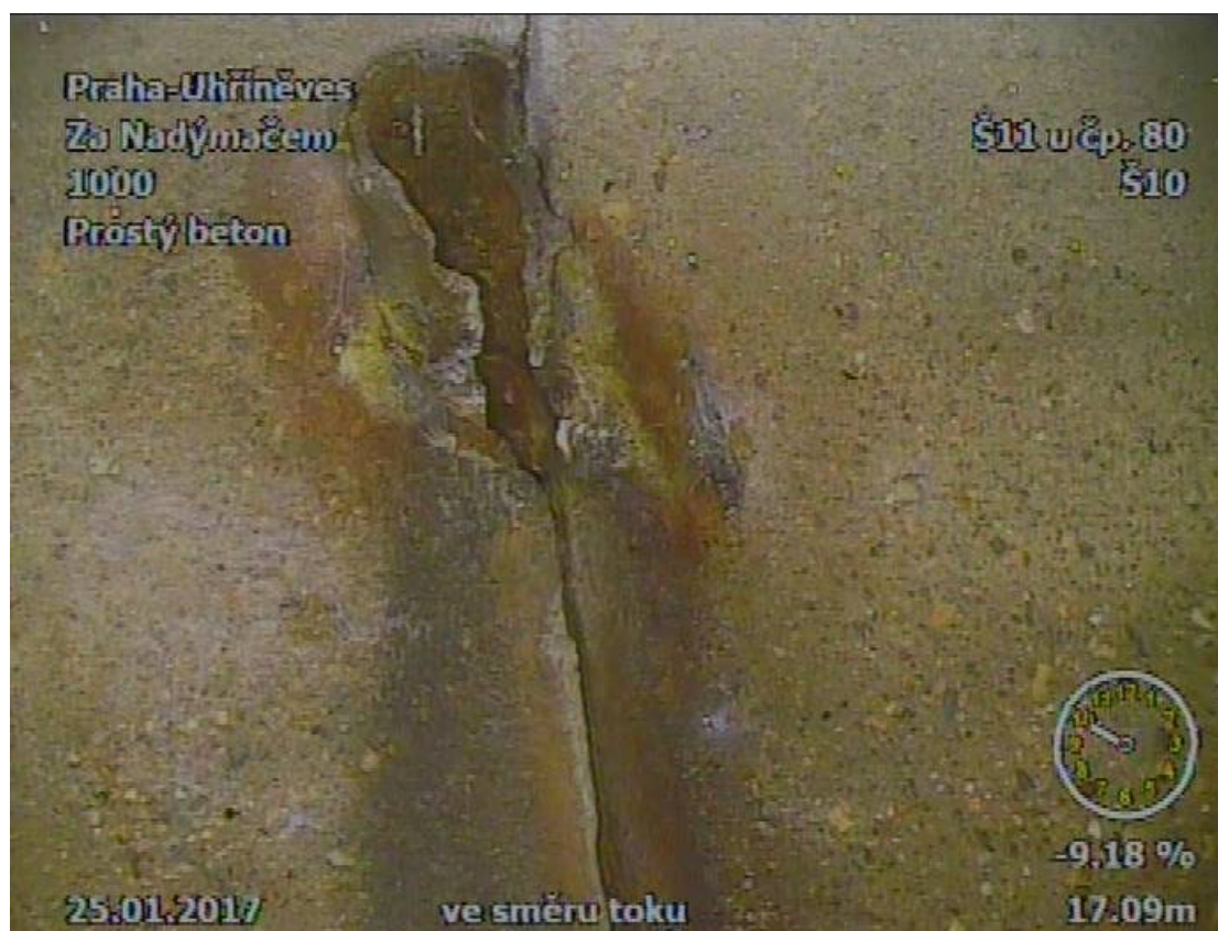
Obr. 48 Detail kanalizační přípojky
