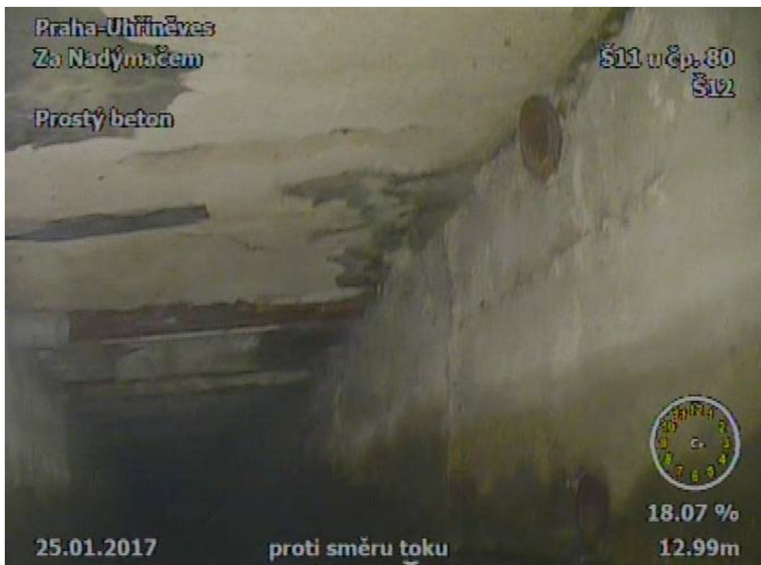
Obr. 42 Kanalizační přípojky 3, 4 a 5
