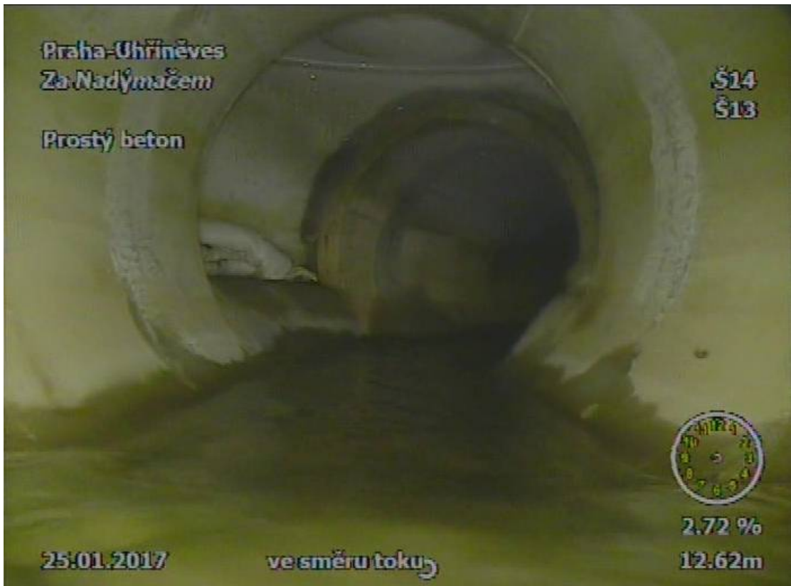
Obr. 34 Pohled po směru toku na Š13
