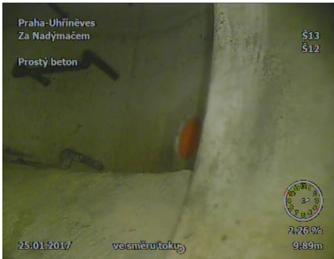
Obr. 36 Kanalizační přípojka DN 150
